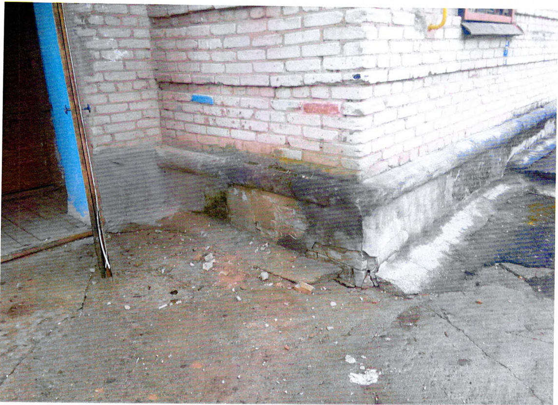
Фото 9. Фрагмент северного фасада. Разрушение штукатурного покрытия цоколя, обнажение кирпичной кладки.
