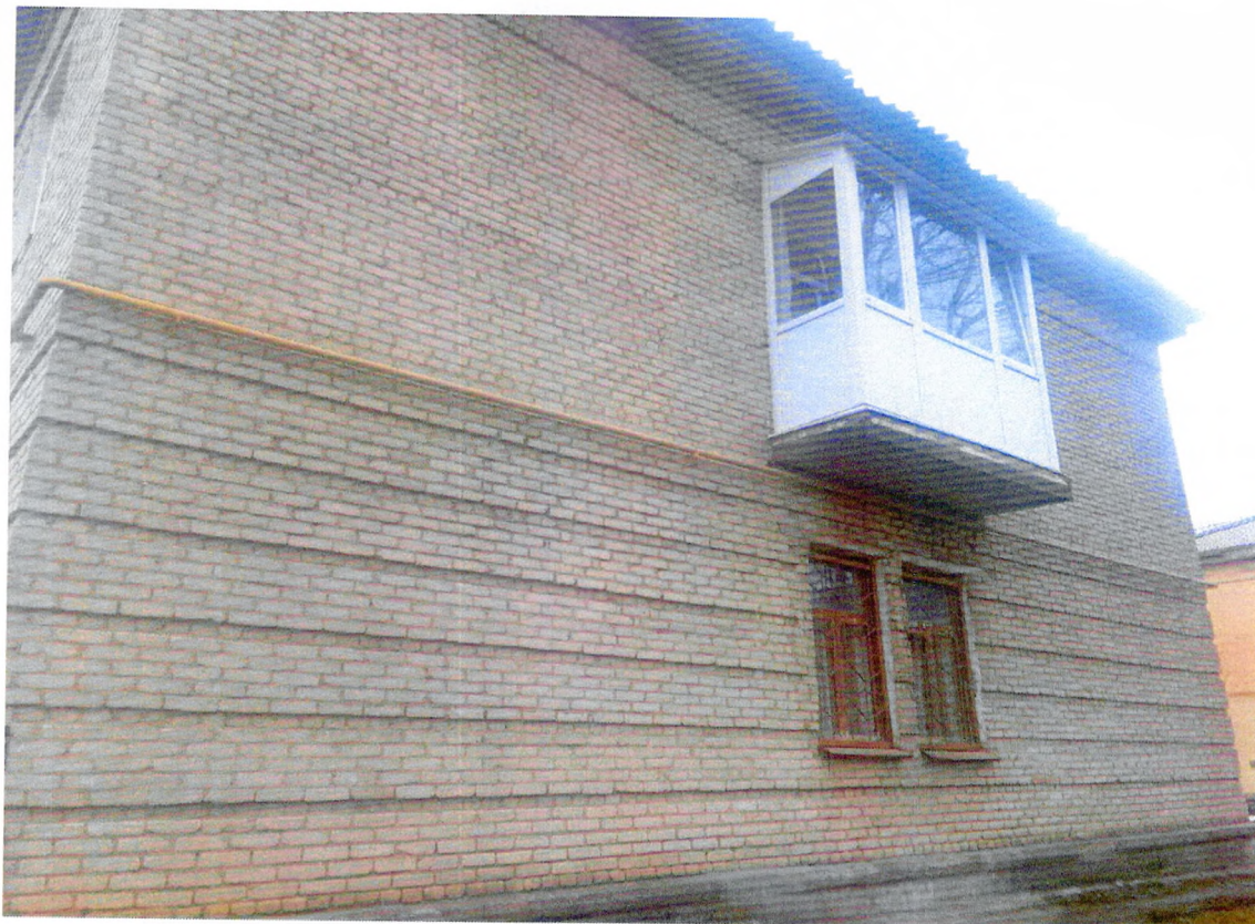
Фото 11. Фрагмент западного фасада.
