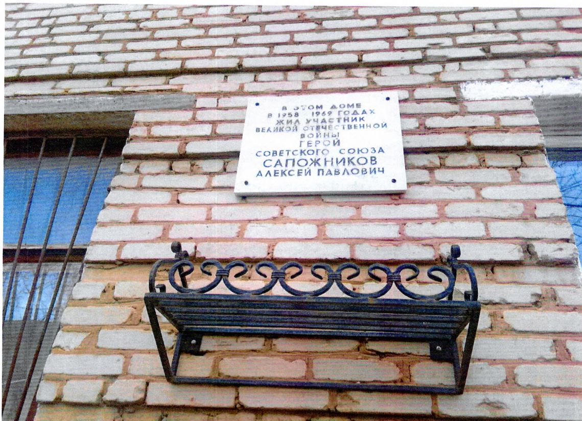
Фото 17. Фрагмент южного фасада. Мемориальная доска.
