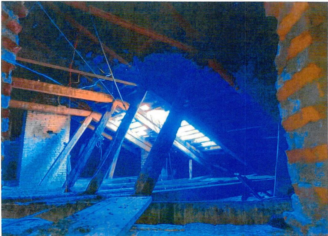
Фото 15. «Офицерский корпус», чердачное помещение, частично отсутствует металлическая кровля
