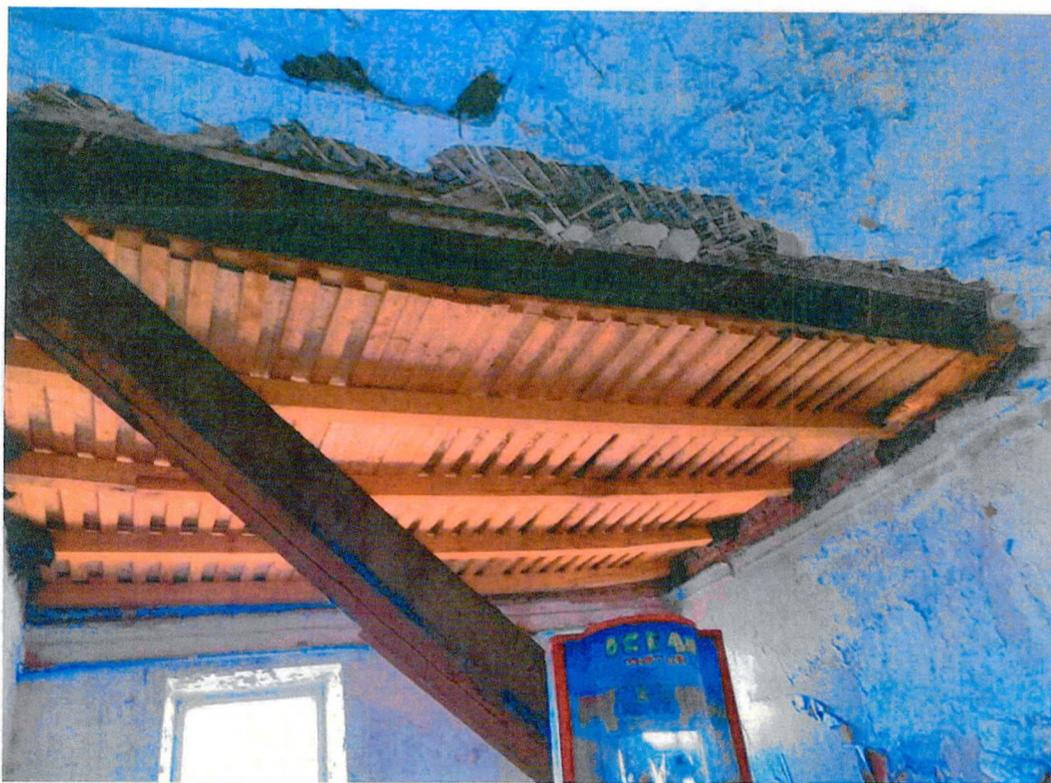
Фото 18. «Офицерский корпус», место обрушения перекрытия на втором этаже. Место ремонта перекрытия
