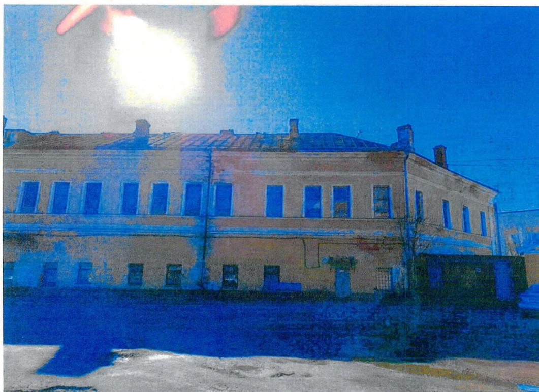
Фото 9. «Офицерский корпус», зафиксировано частичное отслоение штукатурного слоя от стен северного фасада. Следы коррозии на металлической кровле и водосточных трубах
