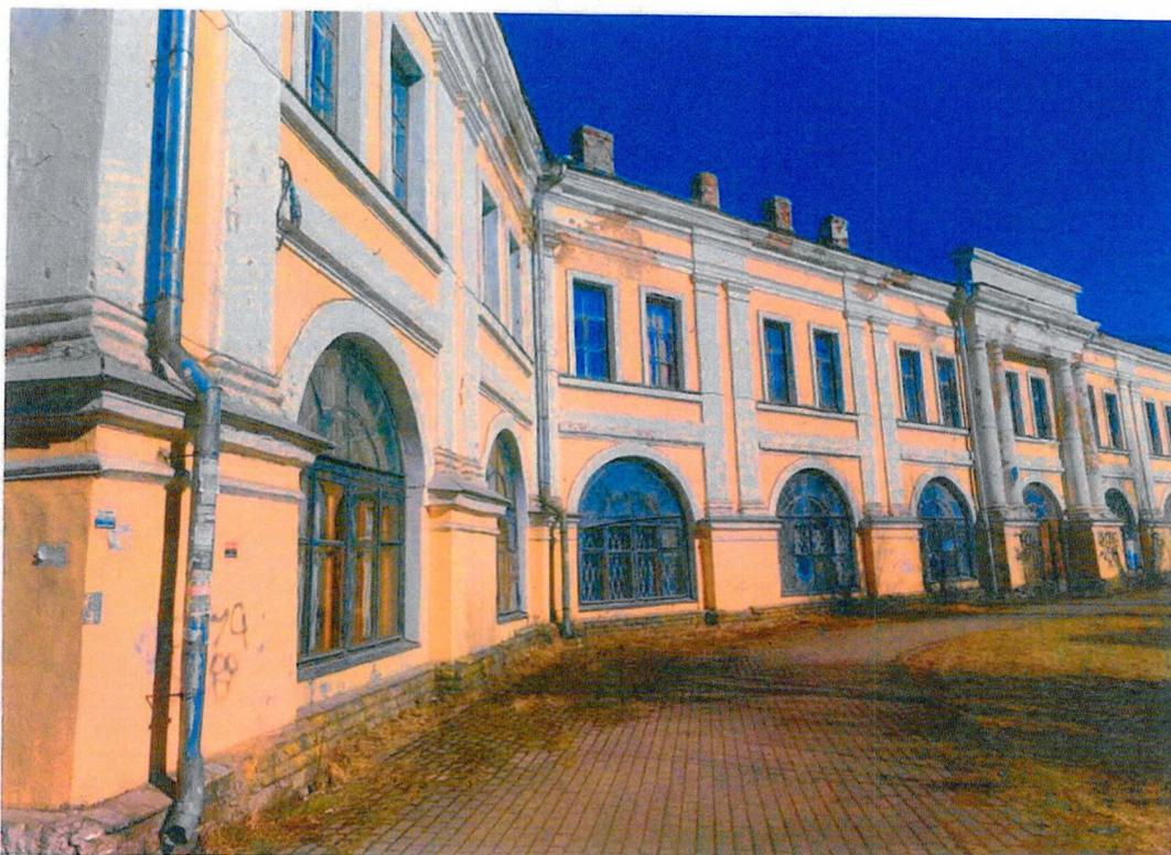
Фото 8. «Офицерский корпус», зафиксировано деструкция: цоколя, штукатурного слоя на трубах и декоративных элементах здания. Произрастает сорная растительность вдоль цоколя
