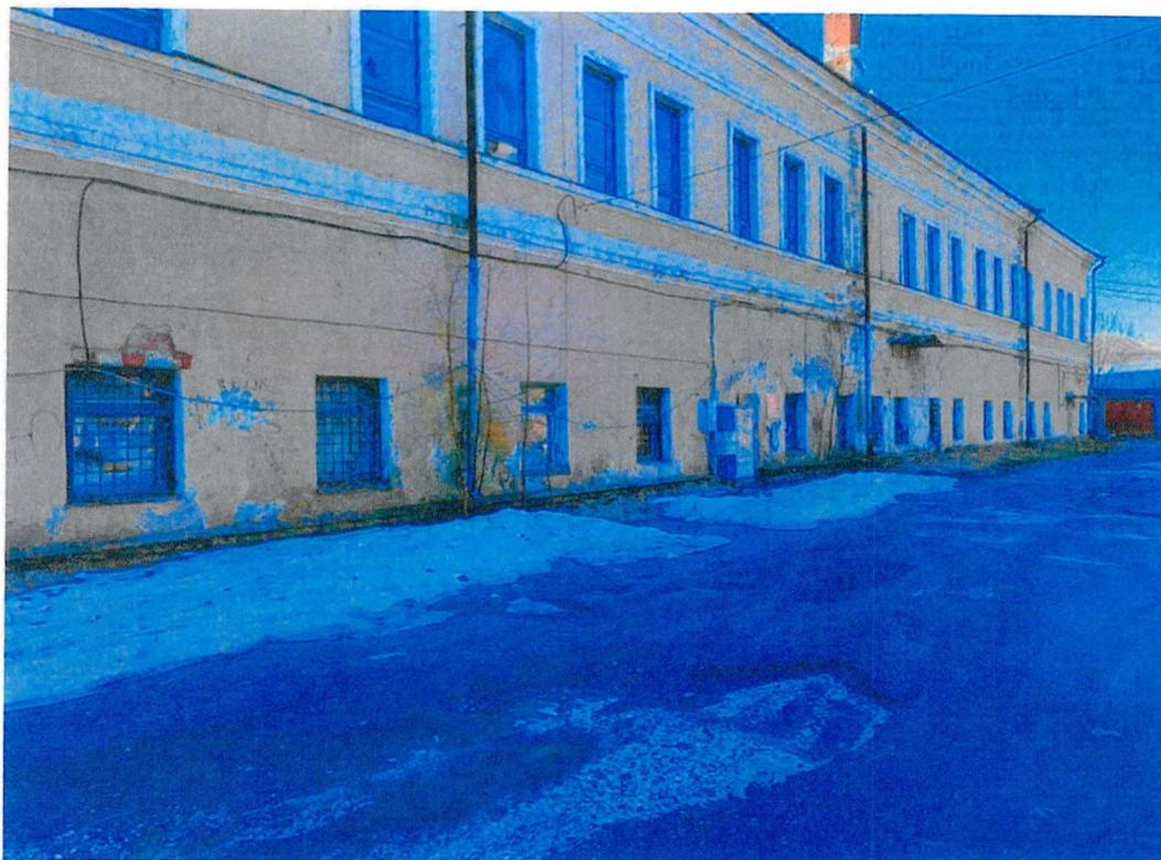
Фото 10. «Офицерский корпус», зафиксировано частичное отслоение штукатурного слоя от стен северного фасада
