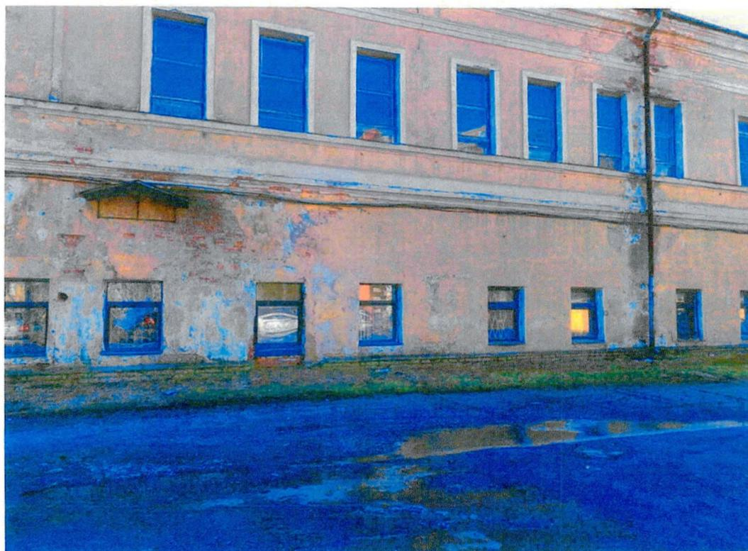
Фото 11. «Офицерский корпус», зафиксировано частичное отслоение штукатурного слоя от стен северного фасада
