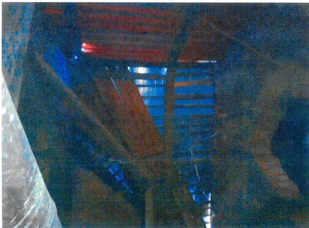
Фото 19. «Офицерский корпус», зафиксированы сквозные отверстия в кровле
