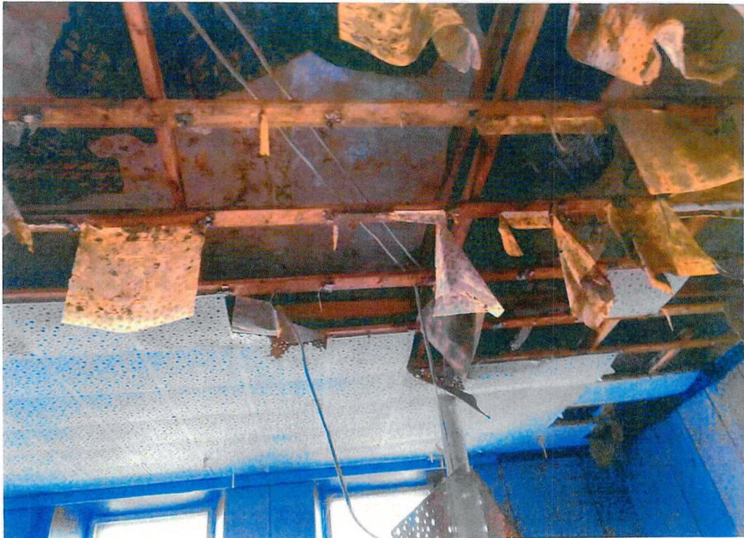
Фото 17. «Офицерский корпус», протечки в перекрытии второго этажа. Деструкция подвесных потолков
