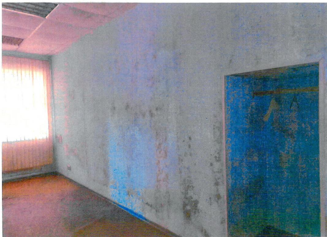
Фото 13. «Офицерский корпус», помещение первого этажа, следы биопоражения на стенах
