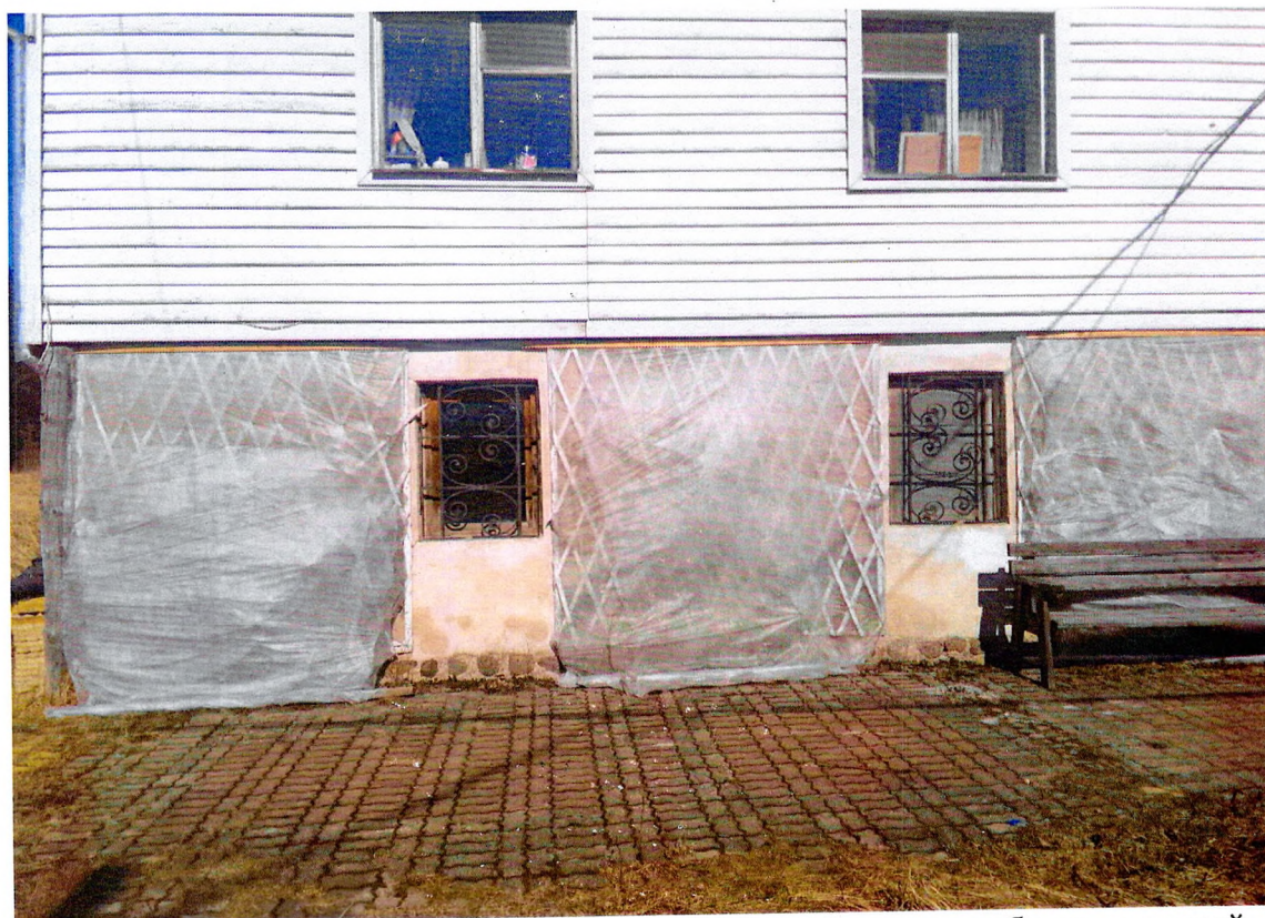
Фото 12. Фрагмент южного фасада. Простенки первого этажа обшиты пленкой.
