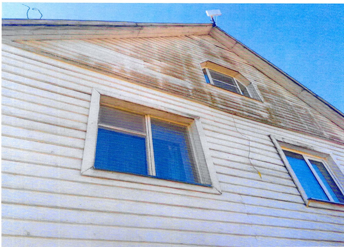
Фото 8. Фрагмент северного фасада. Биоповреждение наличников окон второго этажа, деревянных панелей облицовки стен мансарды.
