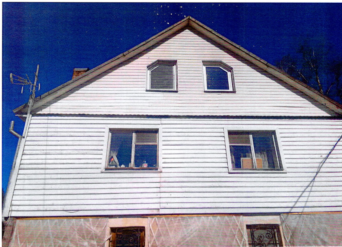
Фото 11. Фрагмент южного фасада.
