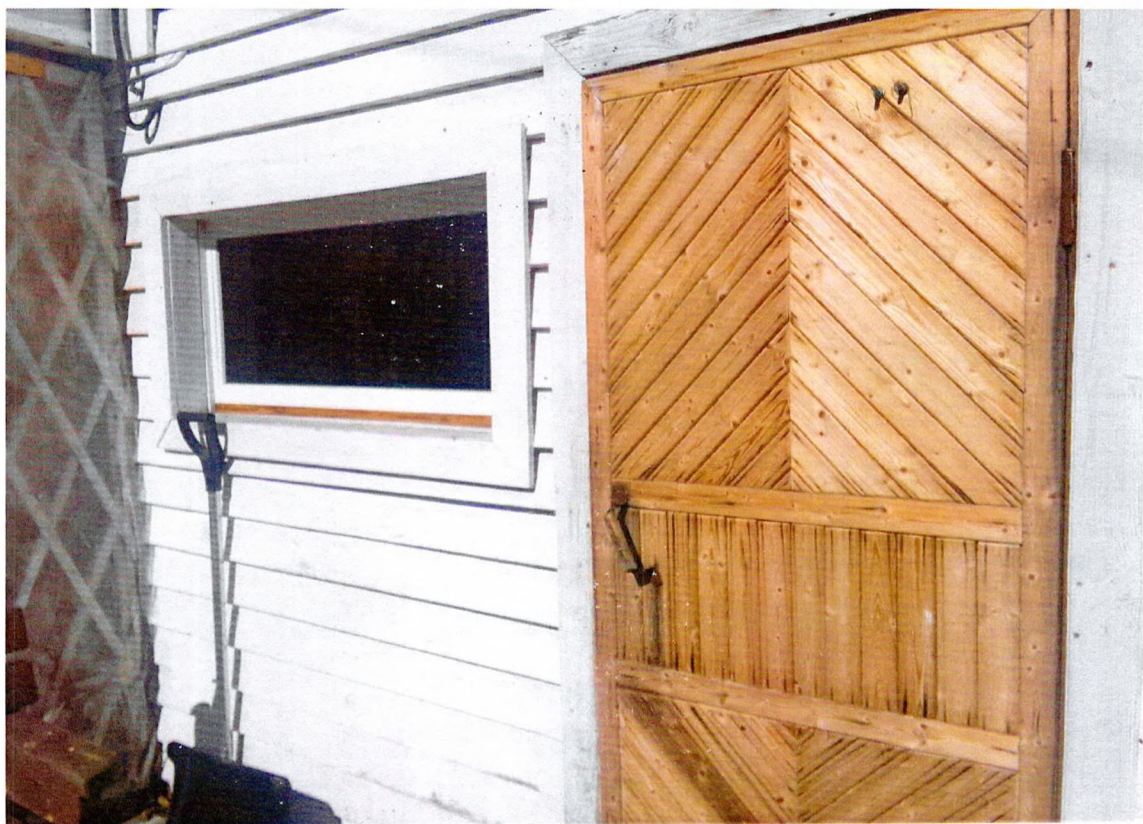
Фото 13. Фрагмент южного фасада.
