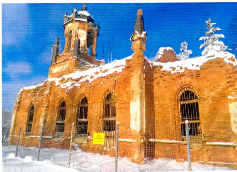
Фото 2. Южный фасад здания.
