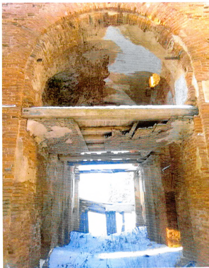
Фото 32. Крестовый кирпичный свод над притвором. Деревянное перекрытие под сводом.
