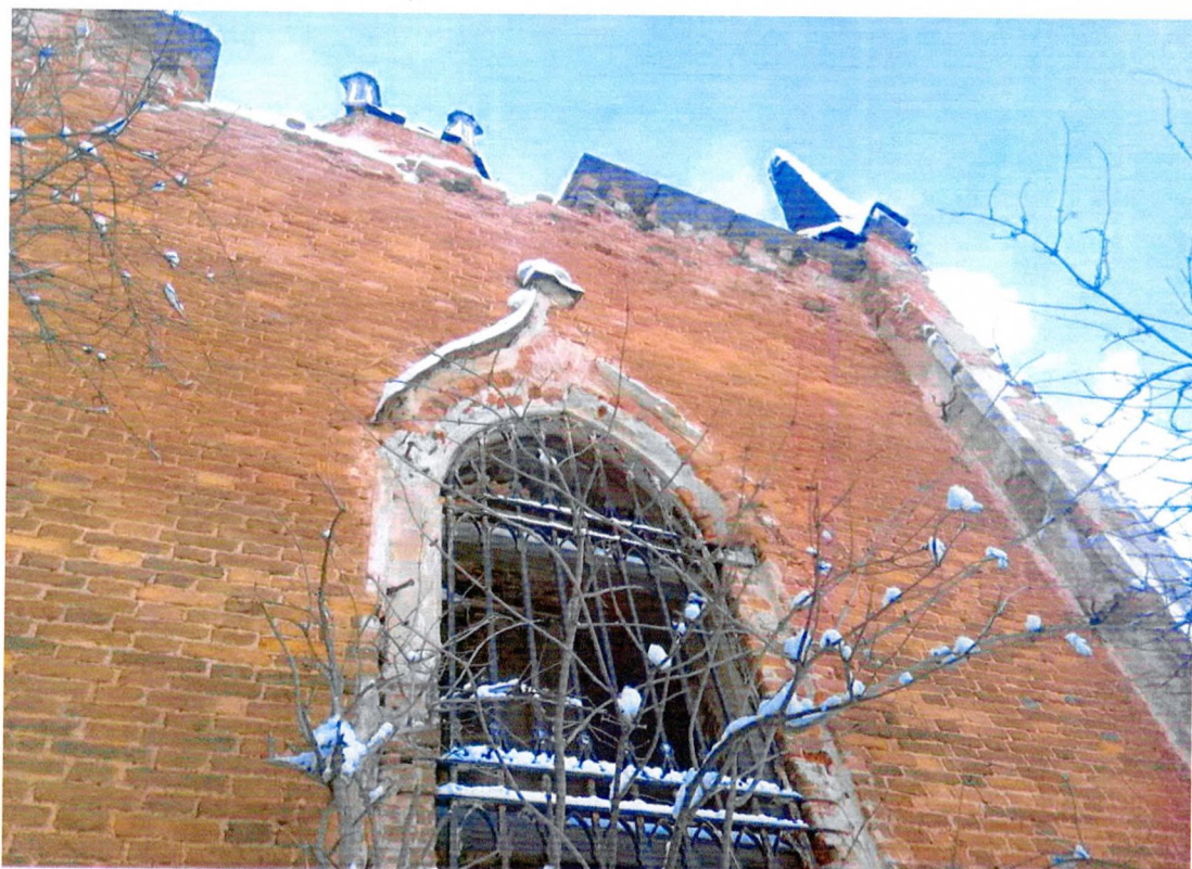
Фото 25. Фрагмент северного фасада. Частично сохранившийся штукатурный слой обрамления оконного проема и металлическое покрытие фиала.
