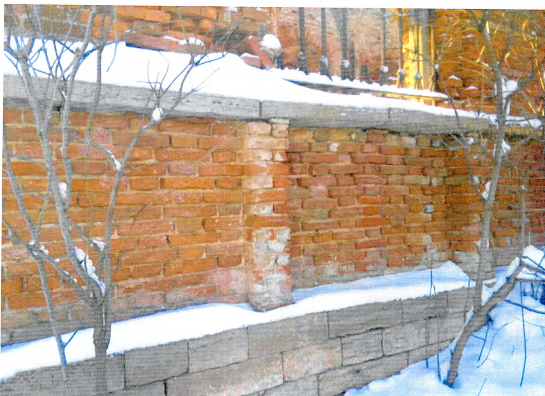
Фото 21. Фрагмент северо-восточного фасада. Прорастание кустарника в зоне фундамента.
