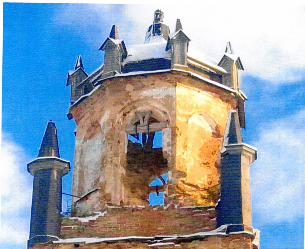
Фото 9. Фрагмент западного фасада. Конструкция барабана и главки.
