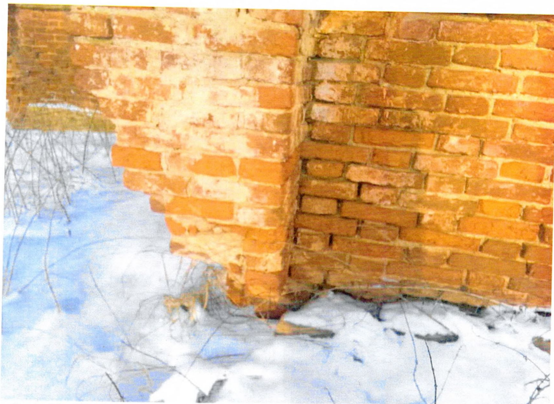
Фото 13. Фрагмент южного фасада. Коррозия металлических решеток на окнах.
