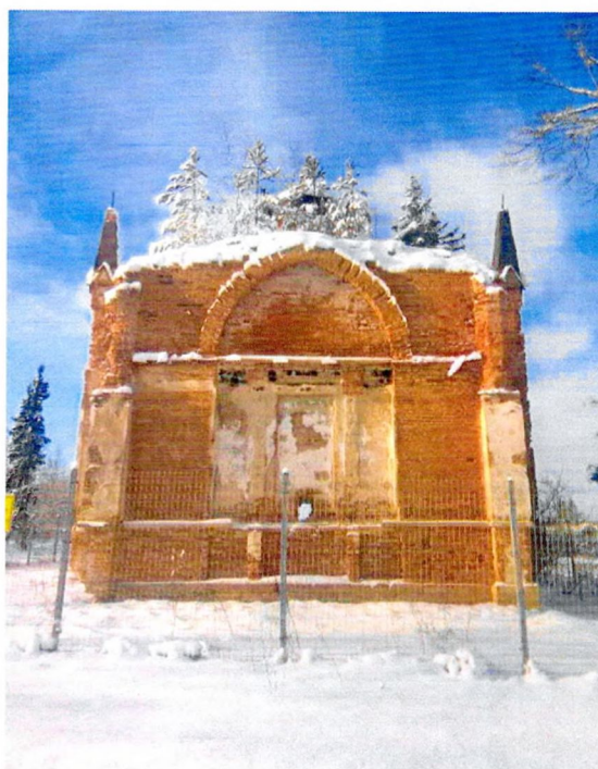
Фото 1. Восточный фасад здания.
