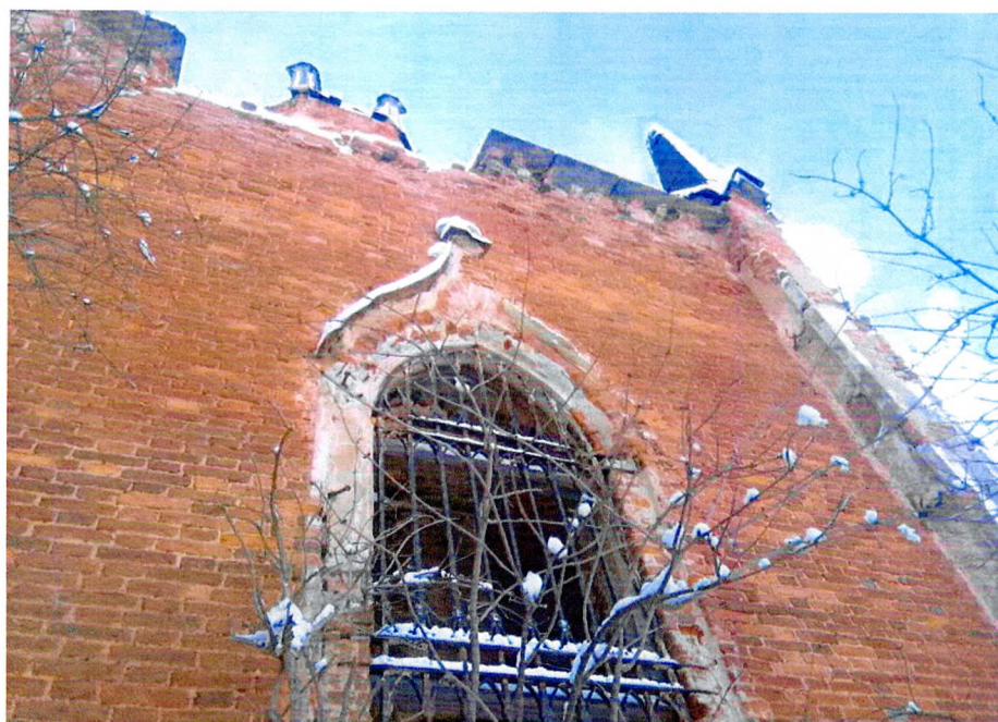
Фото 4. Фрагмент северного фасада здания.
