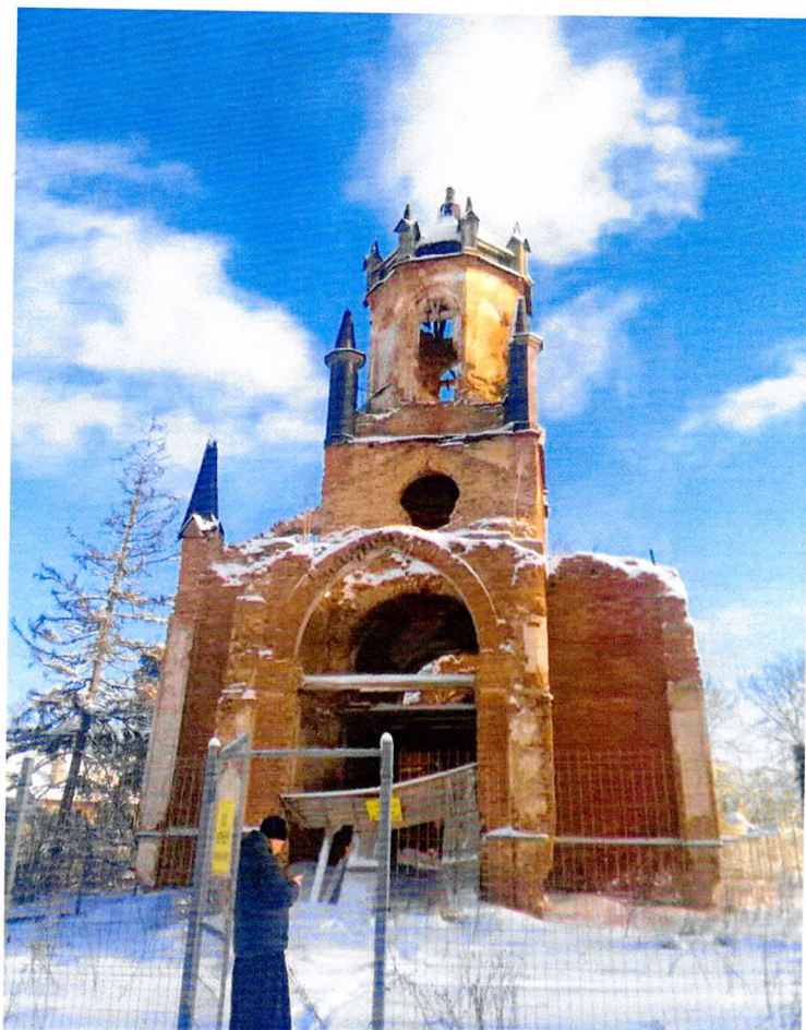
Фото 3. Западный фасад здания.
