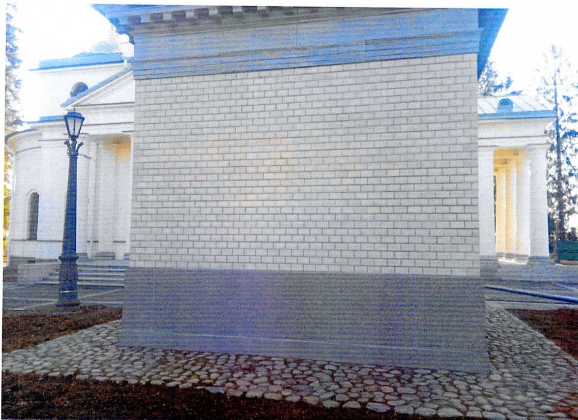
Фото 3. Общий вид северного фасада.
