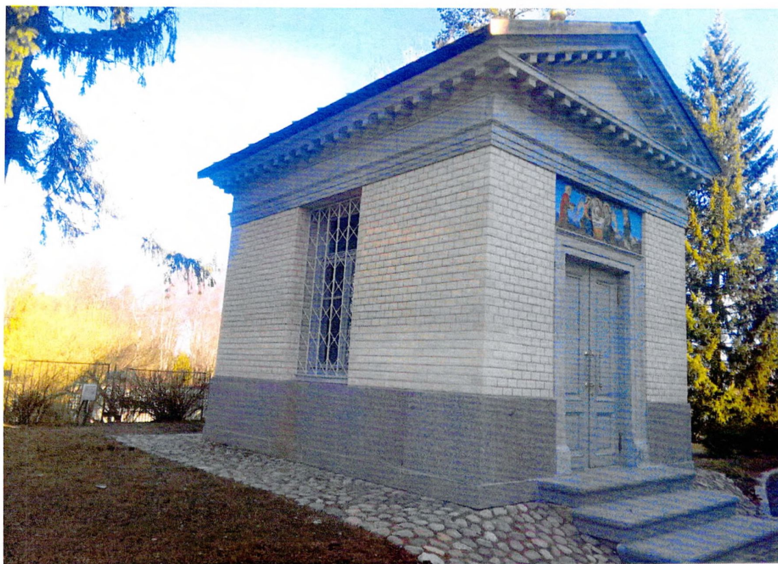
Фото 4. Общий вид западного фасада.
