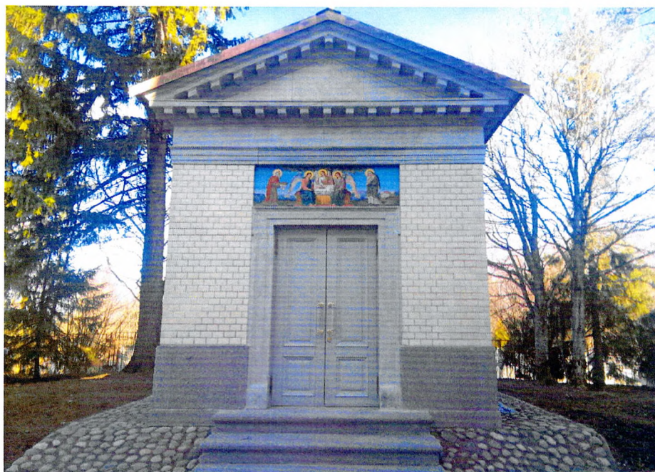
Фото 1. Общий вид южного фасада.
