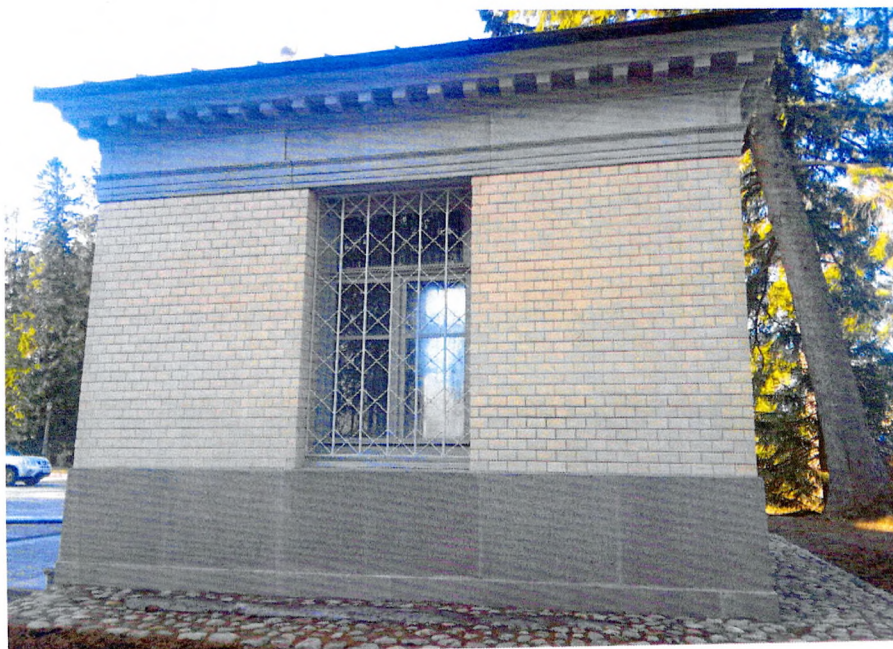
Фото 2. Общий вид восточного фасада.
