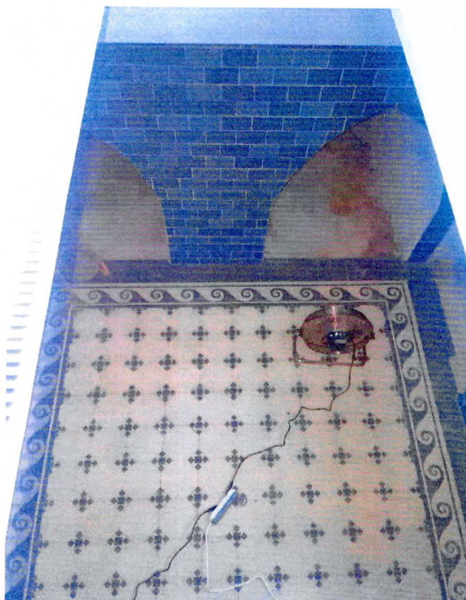
Фото 8. Общий вид крипты с погребальными помещениями. Полы крипты выполнены с покрытием из метлахской плитки.
