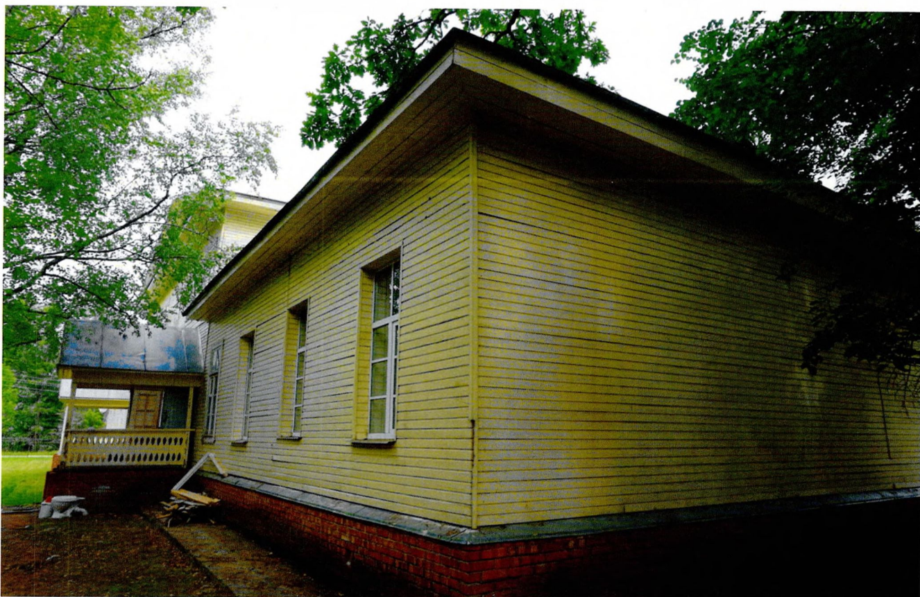
Фото 3. Угол юго-западного и торцевого юго-восточного фасадов. Вид с юга.
