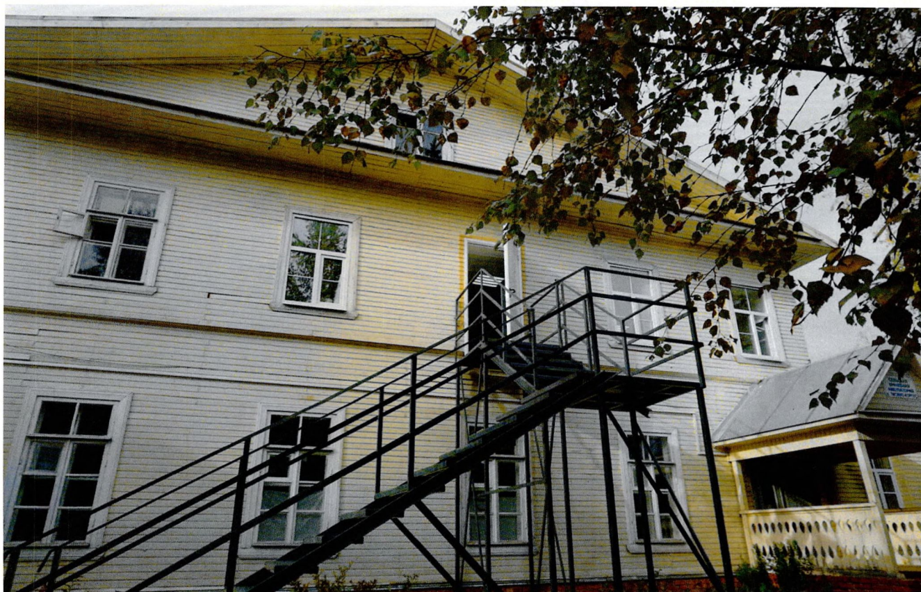
Фото 4. Центральная часть северо-восточного фасада. Преобразование оконного проема в пожарный выход. Вид с северо-востока.
