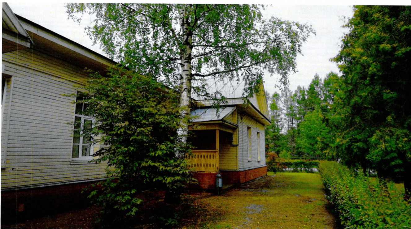
Фото 5. Вид на правую часть северо-восточного фасада с юго-востока. Более поздний пристроенный объем в 2 оси, с крыльцом.
