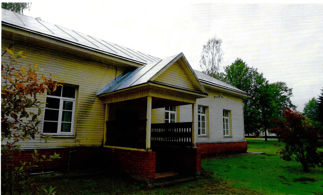
Фото 6. Северо-западный фасад – более поздний пристроенный объем. Вид с севера.
