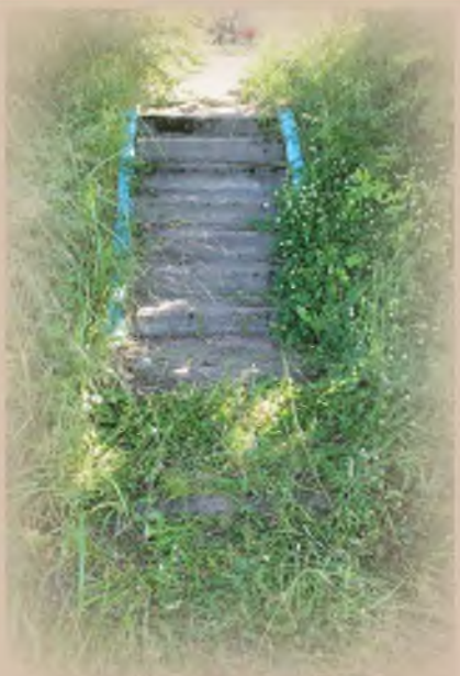
Существующая лестница, фото 2025 г.
