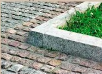
Установка гранитного бордюрного камня
