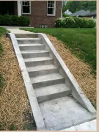
Устройство железобетонной лестницы
