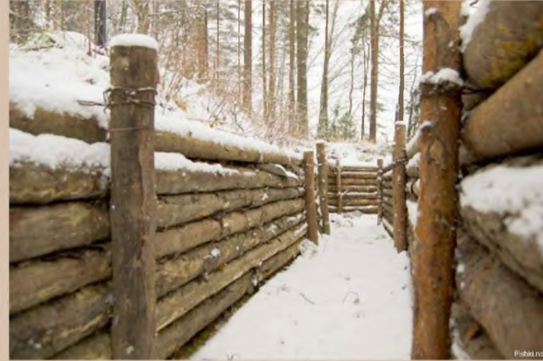
Устройство траншеи окопа (аналог)
