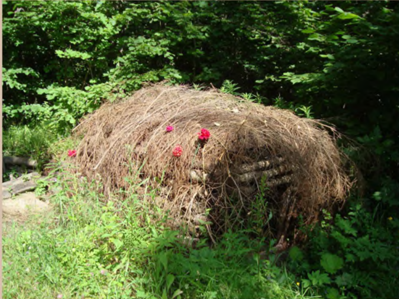
Текущее состояние блиндажа
