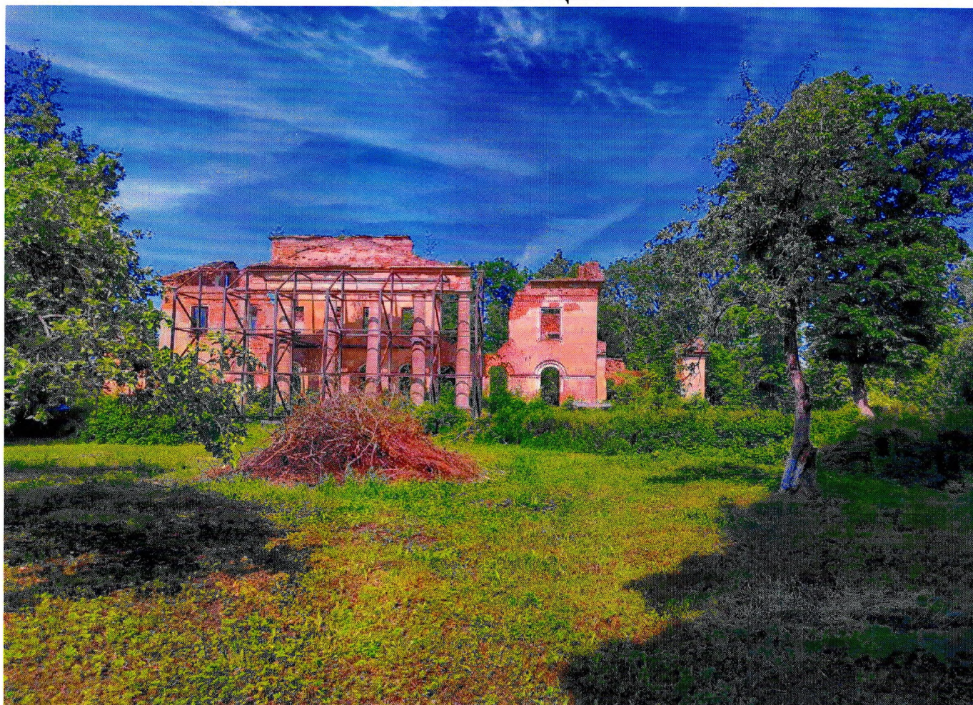
Фото 1. «Усадьба Альбрехта» Усадебный дом, общий вид на здание со стороны сада
