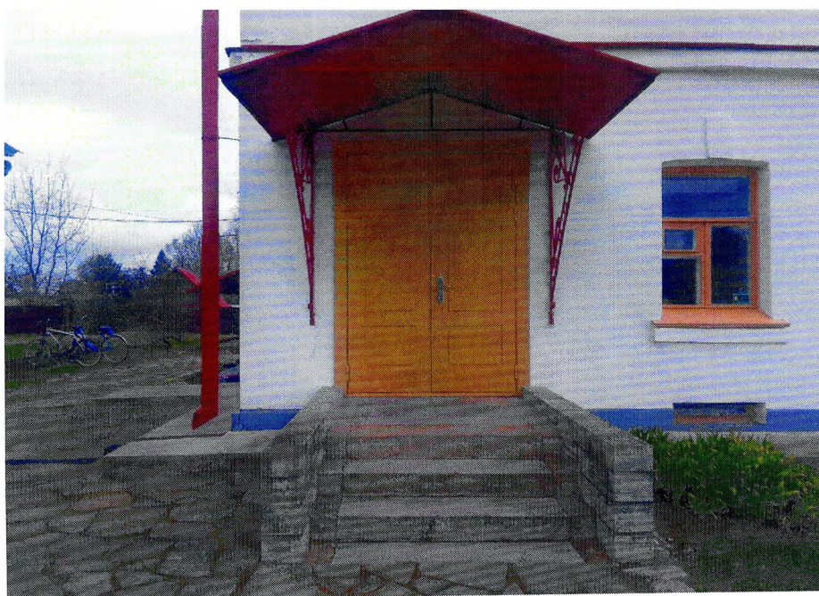
Фото 2. Фрагмент южного фасада. Крыльцо главного входа имеет металлический навес на кованых чугунных кронштейнах.
