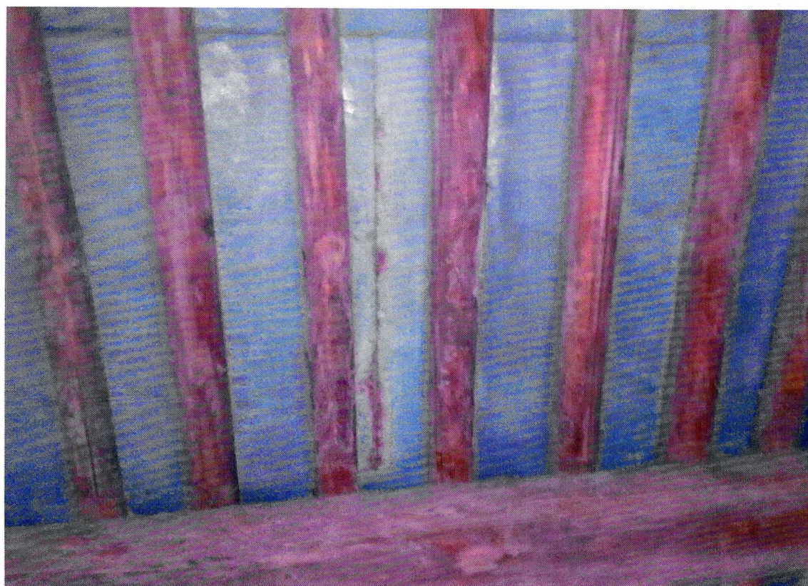
Фото 20. Следы коррозии металлической кровли.
