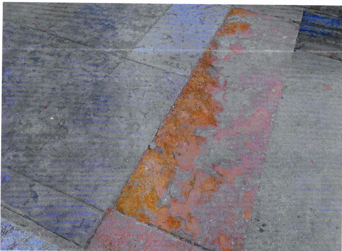
Фото 3. Фрагмент южного фасада. Деструкция ступеней крыльца главного входа.
