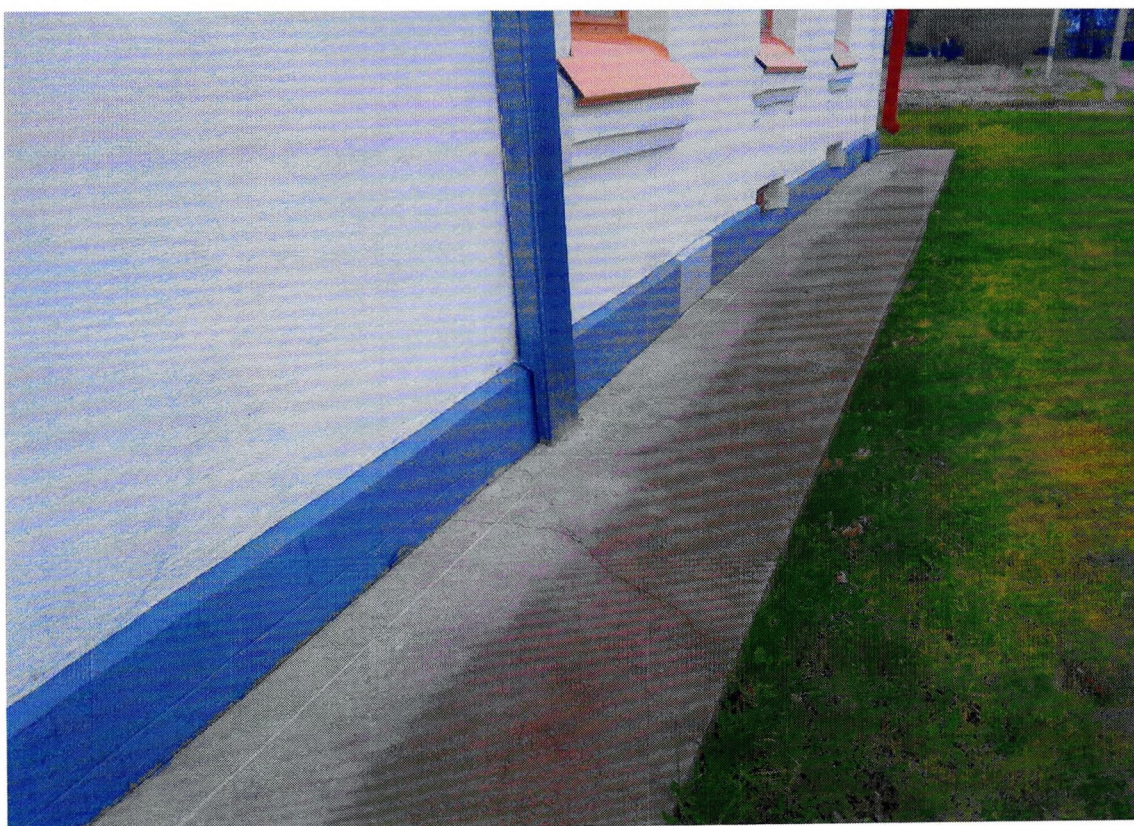
Фото 8. Фрагмент восточного фасада. Трещины в бетонной отмостке.
