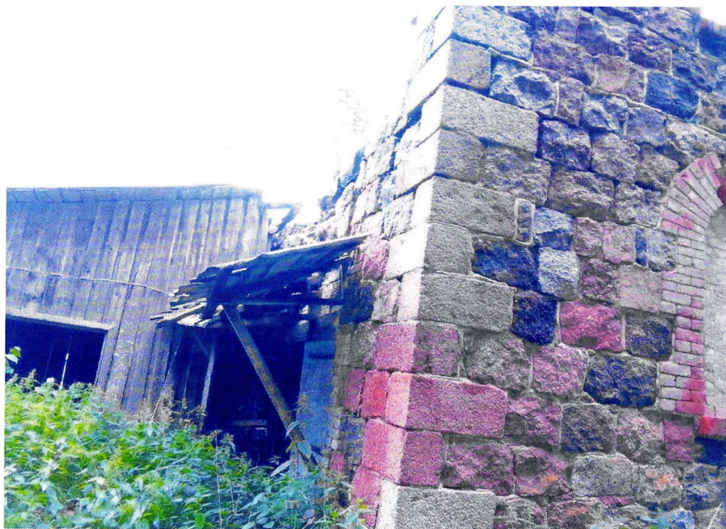
Фото 17. «Хозяйственный корпус (двухэтажный)». Западный фасад. Поздний деревянный козырек над входом.
