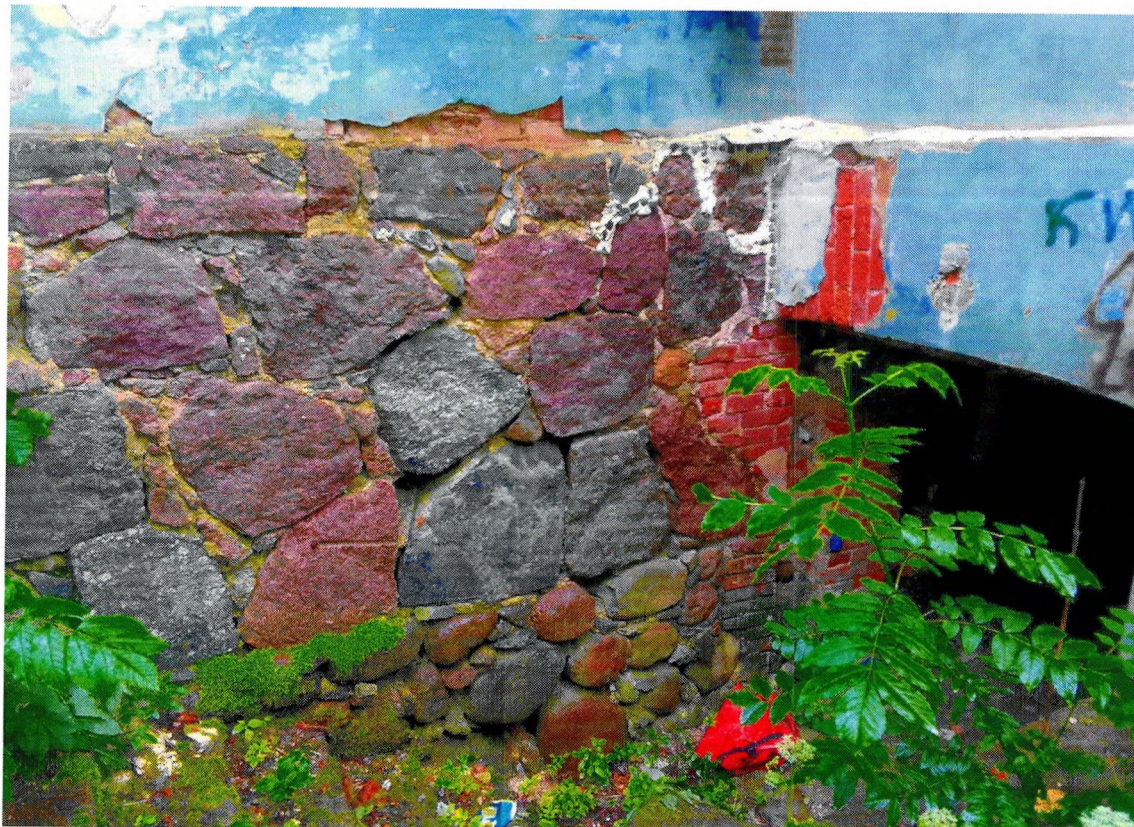
Фото 9. «Главный дом». Фрагмент северного фасада. Вход в цокольный этаж. Биоповреждения цоколя и ступеней.
