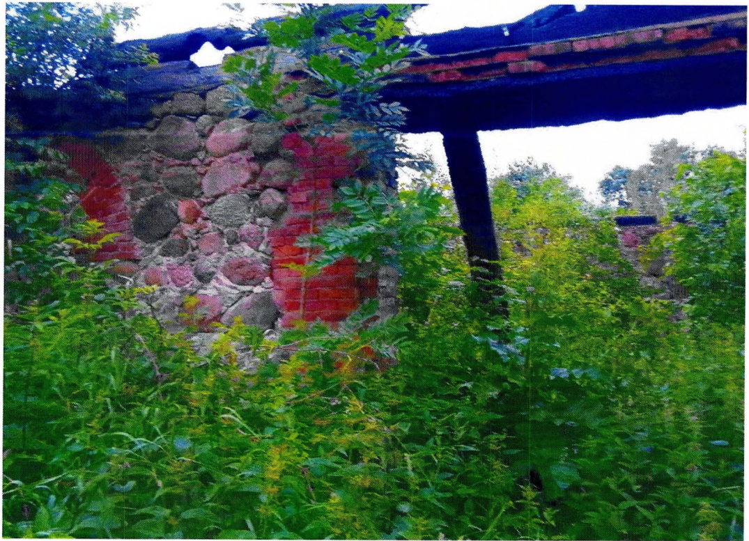
Фото 13. «Хозяйственный корпус одноэтажный». Южный фасад. Утрата конструкций крыши, следы обугливания сохранившихся стропильных конструкций. Прорастание растений вдоль фасада и в интерьере.
