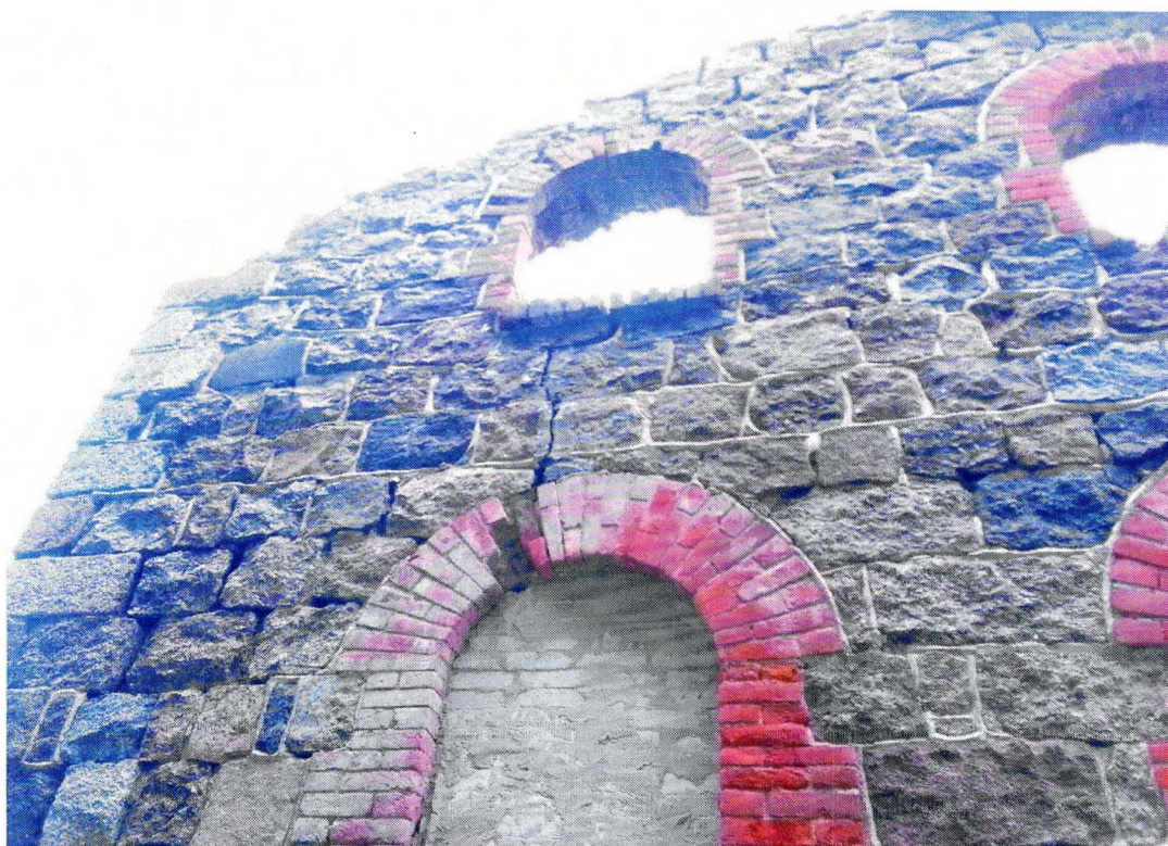
Фото 16. «Хозяйственный корпус (двухэтажный)». Южный фасад. Трещина над оконным проемом первого этажа. Утраты шовного раствора каменной кладки.
