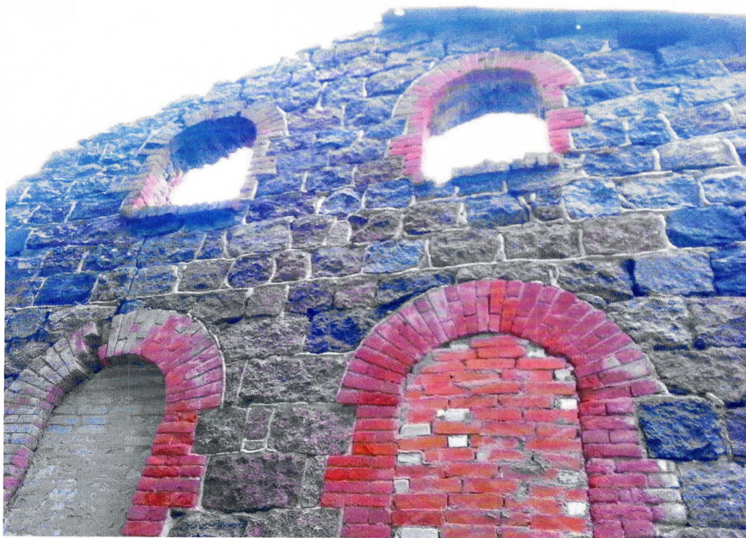
Фото 15. «Хозяйственный корпус (двухэтажный)». Южный фасад. Утрата конструкций крыши. Оконные проемы первого этажа заложены силикатным и керамическим кирпичом.
