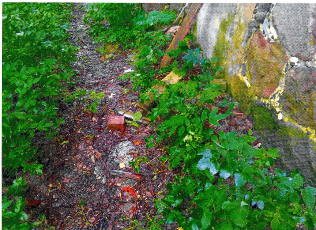
Фото 6. «Главный дом». Фрагмент северного фасада. Прорастание растений в зоне отмостки.
