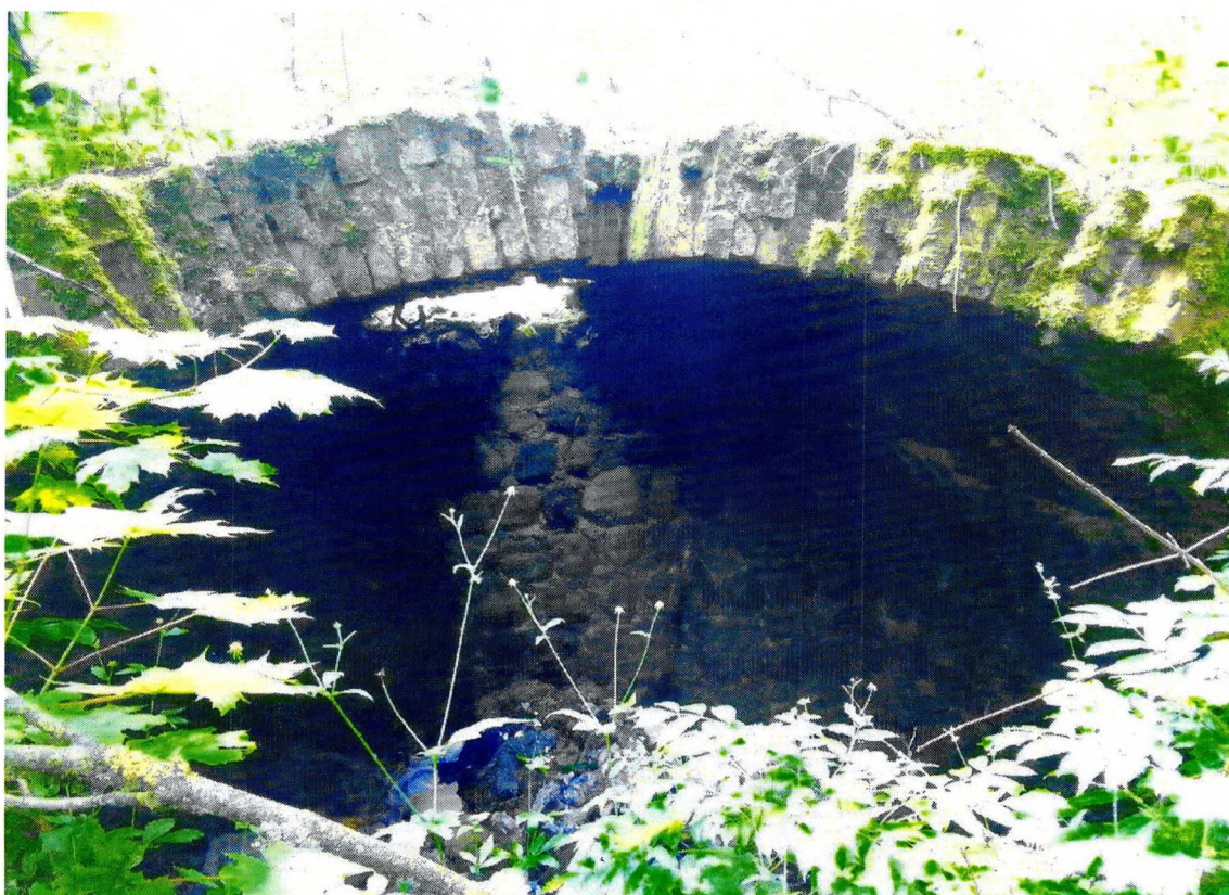
Фото 20. «Каменный погреб (ледник)». Биоповреждение сводчатого перекрытия, выпадение кирпичей из кладки.
