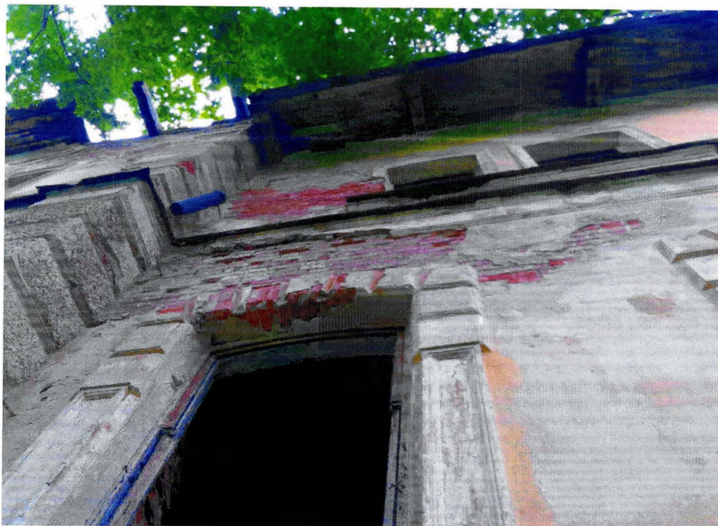
Фото 7. «Главный дом». Фрагмент северного фасада. Утраты штукатурного слоя, деструкция кирпичной кладки, сохранившийся фрагмент трубы наружного водостока.
