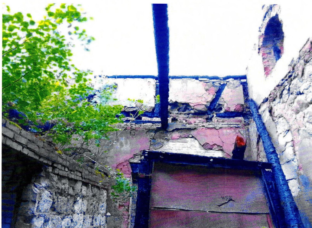
Фото 18. «Хозяйственный корпус (двухэтажный)». Интерьер. Фрагменты деревянных балок утраченного междуэтажного перекрытия. Прорастание растений в кладке внутренней стены.
