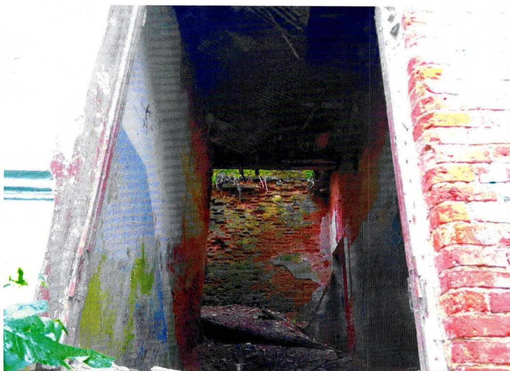
Фото 8. «Главный дом». Интерьер. Разрушение полов. Утраты отделочного слоя внутренних стен, биоповреждения, деструкция кладки, прорастание растений. Обрушение отделочного слоя и дранки сохранившегося деревянного перекрытия, гнилостные повреждения древесины.
