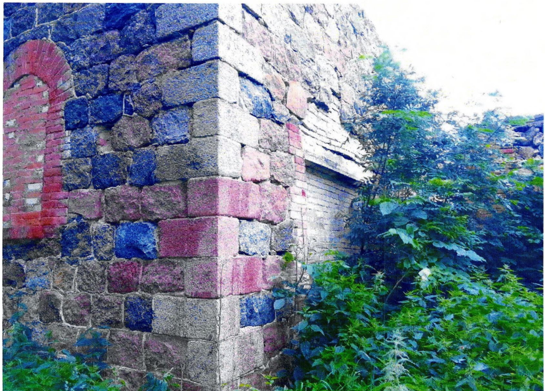
Фото 14. «Хозяйственный корпус (двухэтажный)». Юго-восточный фасад. Дверной проем восточного фасада заложен силикатным кирпичом.
