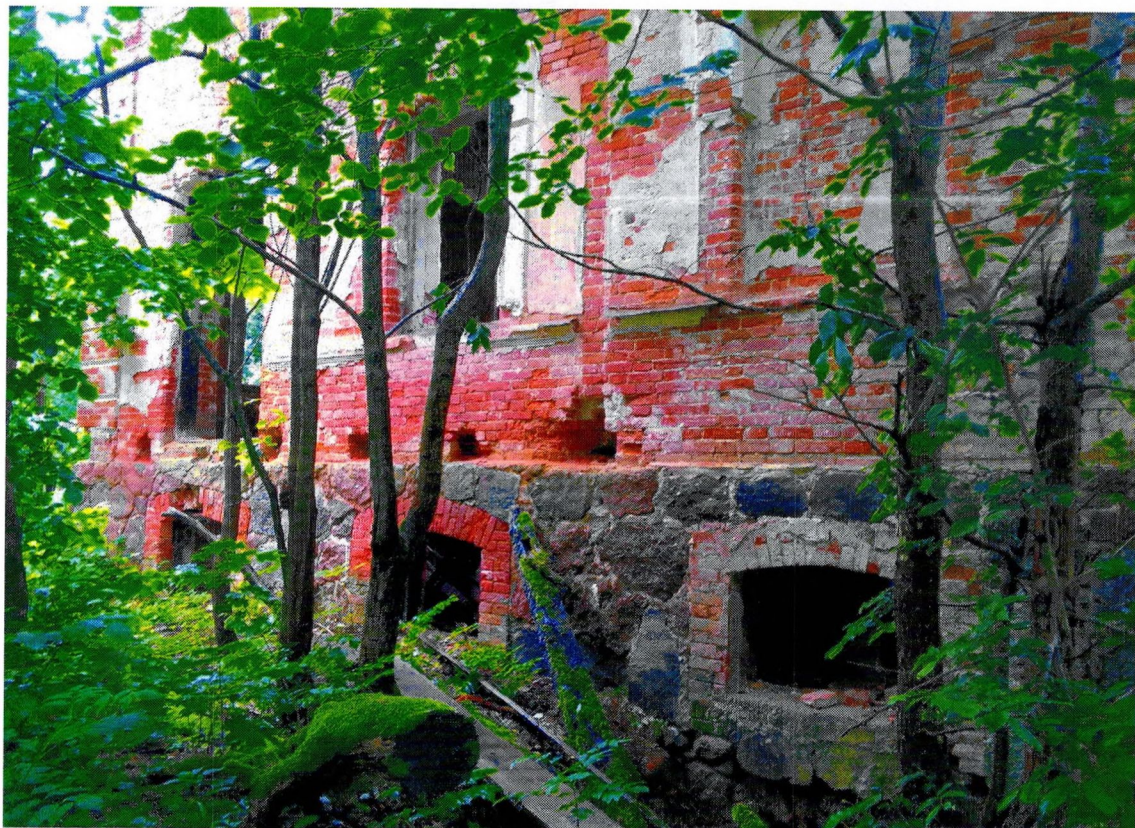
Фото 11. «Главный дом». Фрагмент восточного фасада. Механические повреждения кладки, утраты штукатурного слоя.
