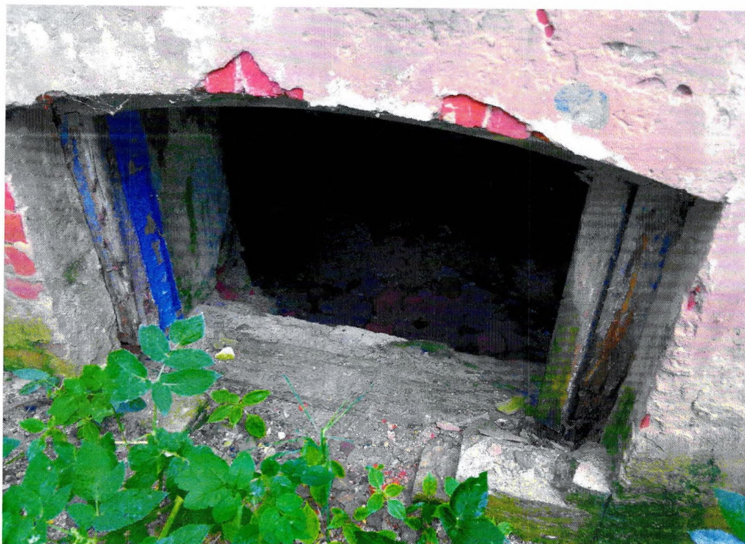
Фото 5. «Главный дом». Фрагмент северного фасада. Оконный проем цокольного этажа с лучковой перемычкой. Разрушение полов цокольного этажа.
