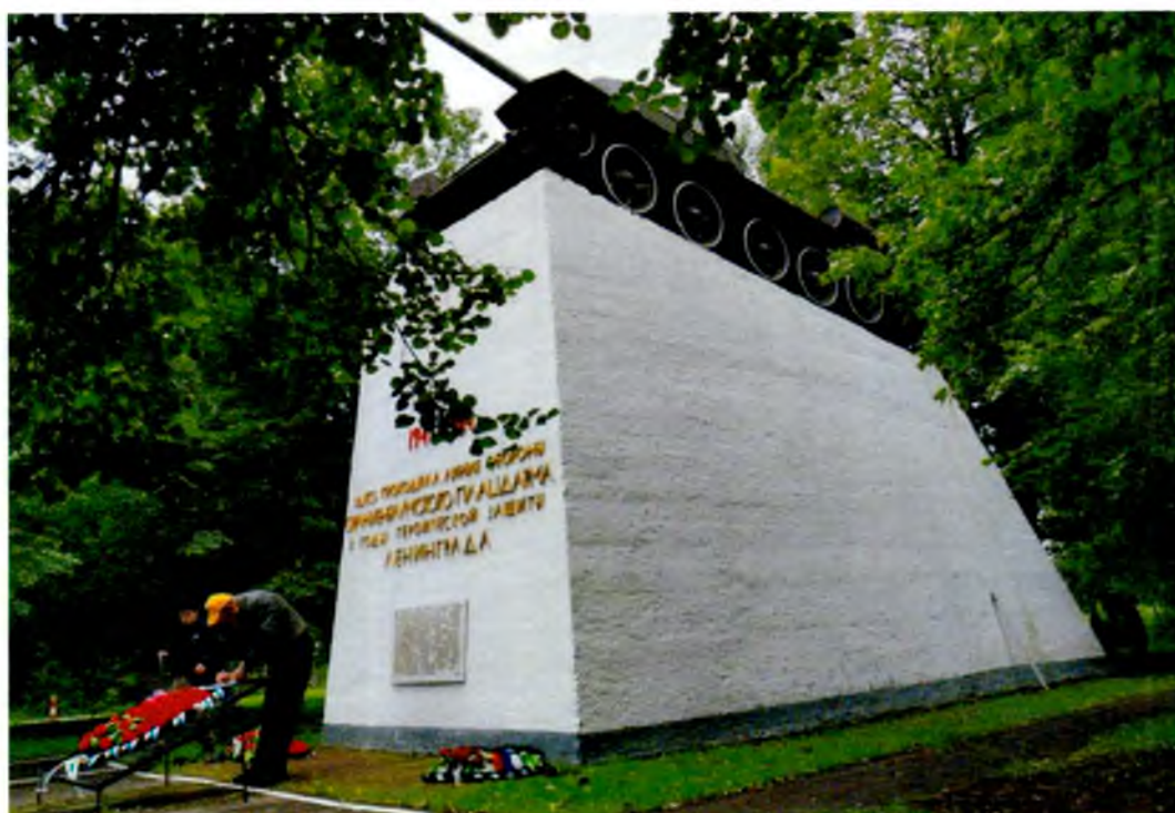
Фото 6. Вид на северо-восточный фасад памятника.
