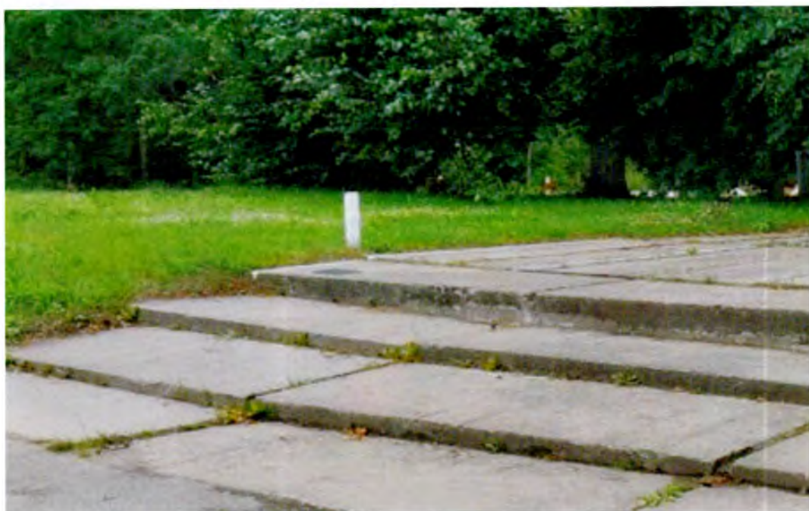
Фото 3. Вид на бетонный ступопандус с юго-восточной стороны.
