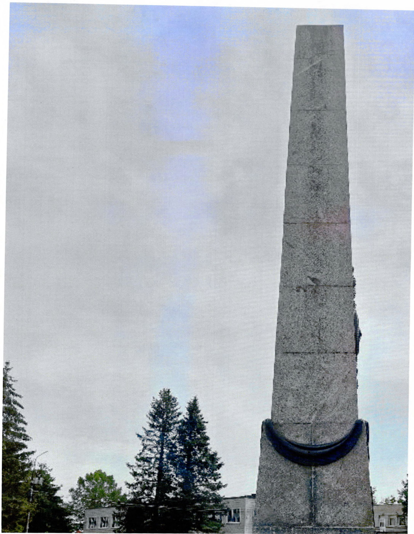
Фото 4. Северо-западной фасад обелиска.
