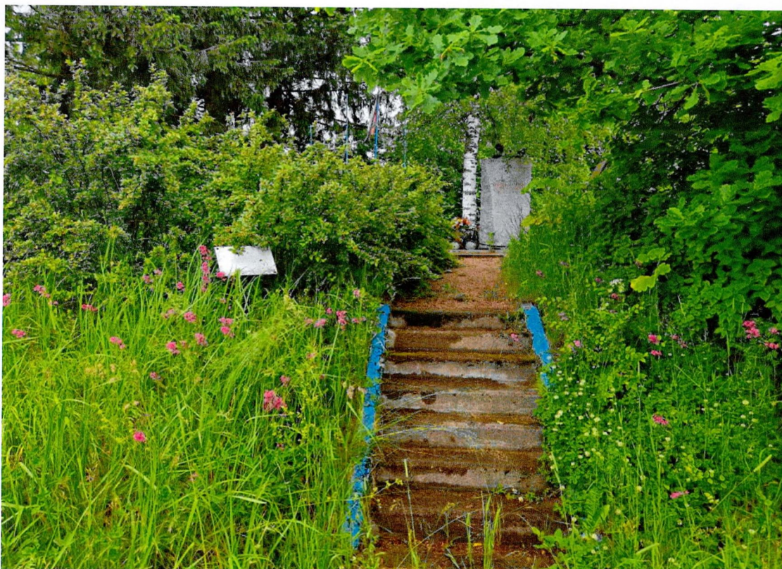
Фото 5. Железобетонная лестница, ведущая на территорию памятника.
