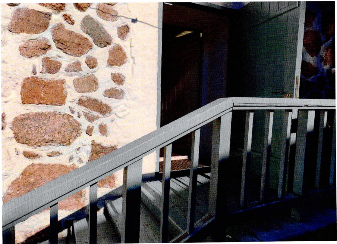
Фото 8. «Дом жилой», крыльцо восточного фасада здания.
