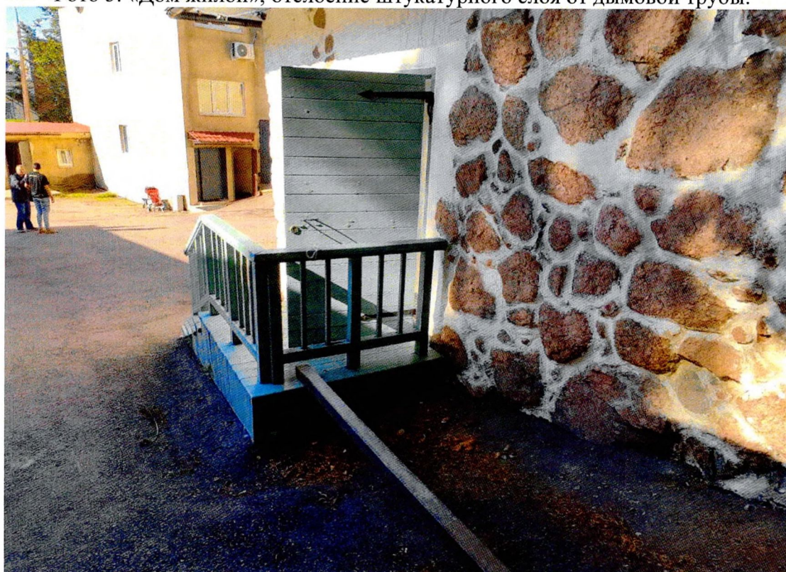
Фото 6. «Дом жилой», северо-восточный фасад здания.
