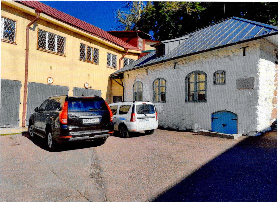
Фото 1. «Дом жилой», общий вид южного фасада здания.
