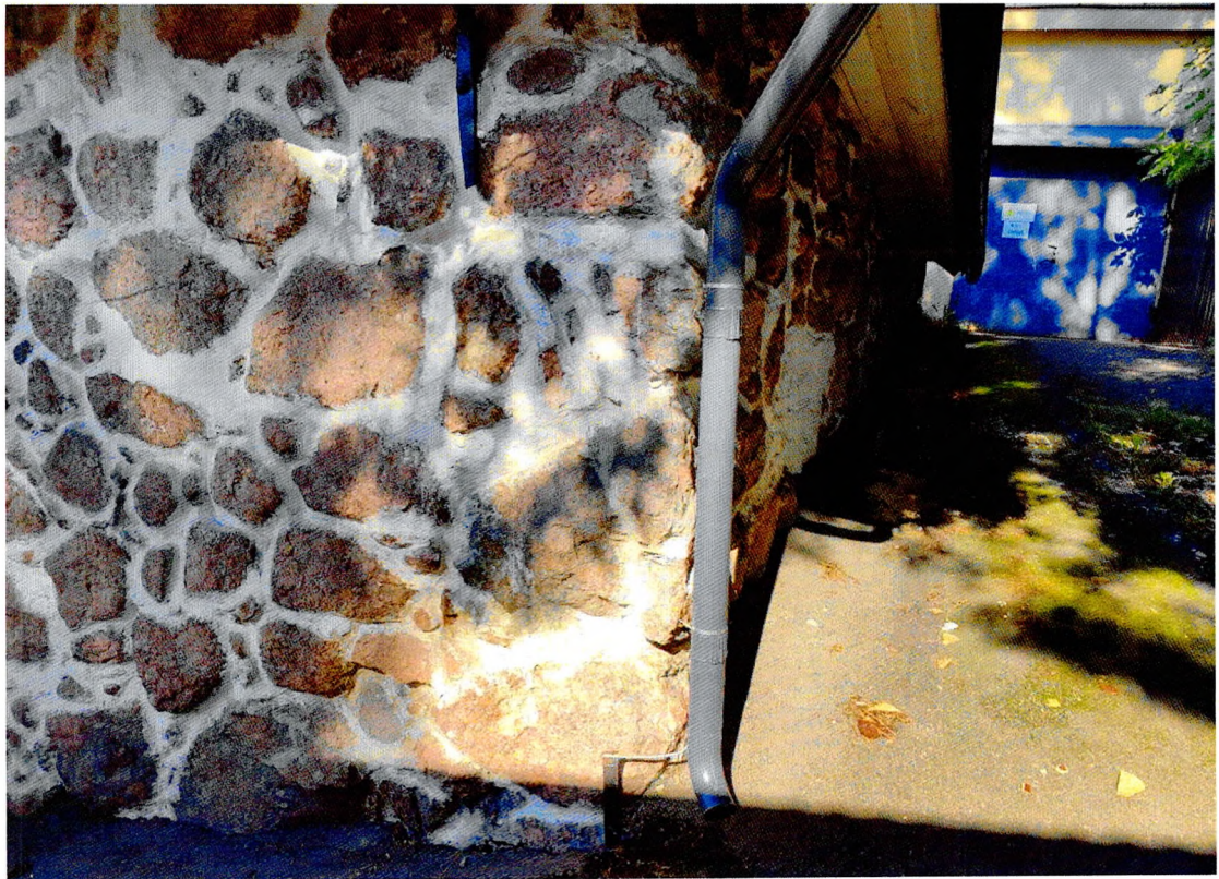
Фото 7. «Дом жилой», северо-восточный фасад здания.
