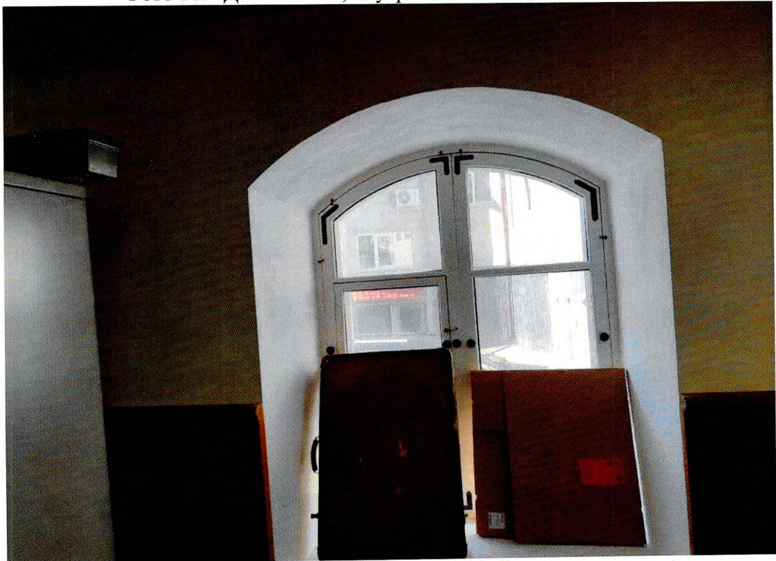
Фото 12. «Дом жилой», оконное заполнение деревянное, состояние удовлетворительное.
