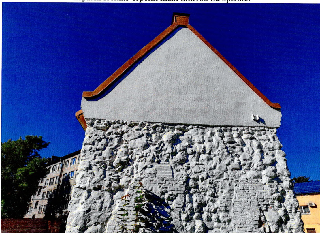
Фото 4. «Дом купеческой гильдии», общий вид восточного фасада здания.
