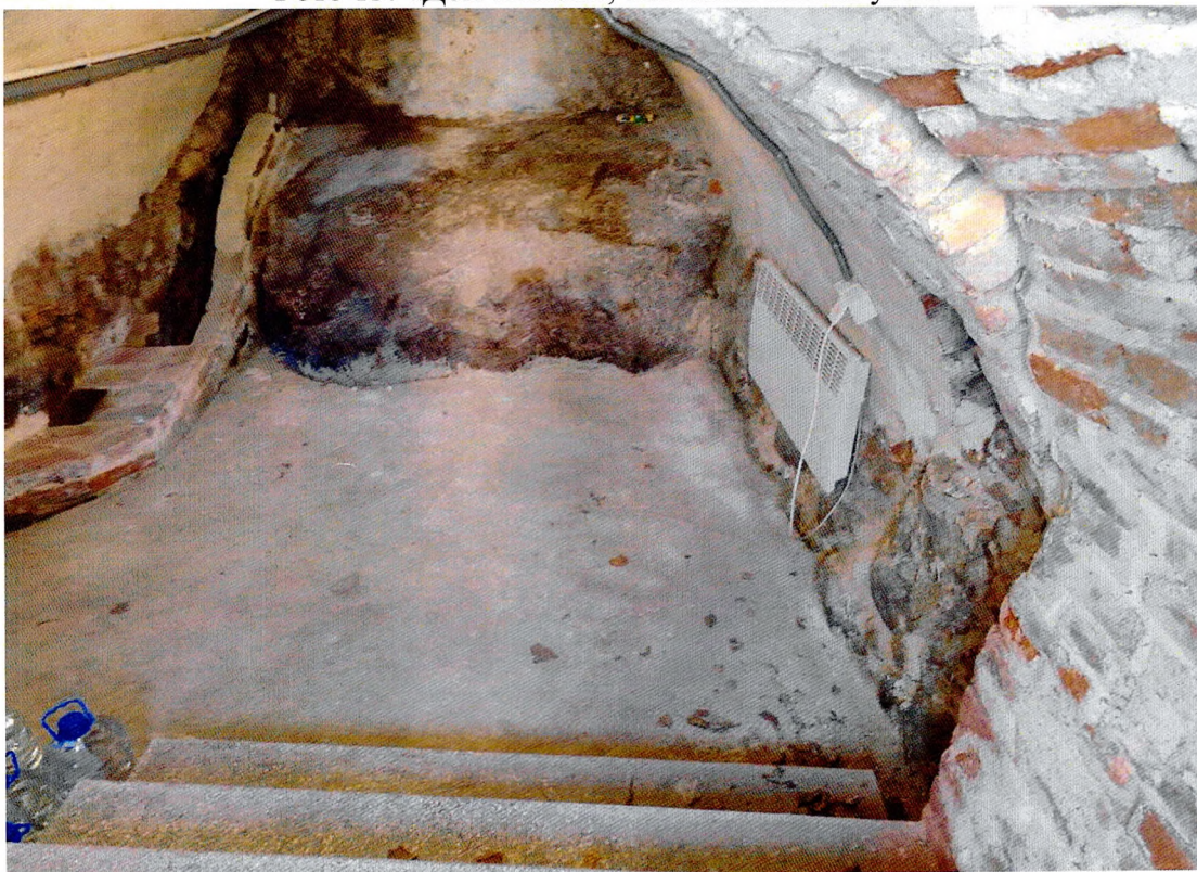
Фото 14. «Дом жилой», подвальное помещение, не наблюдаются протечки, электрика системы в рабочем состоянии.
