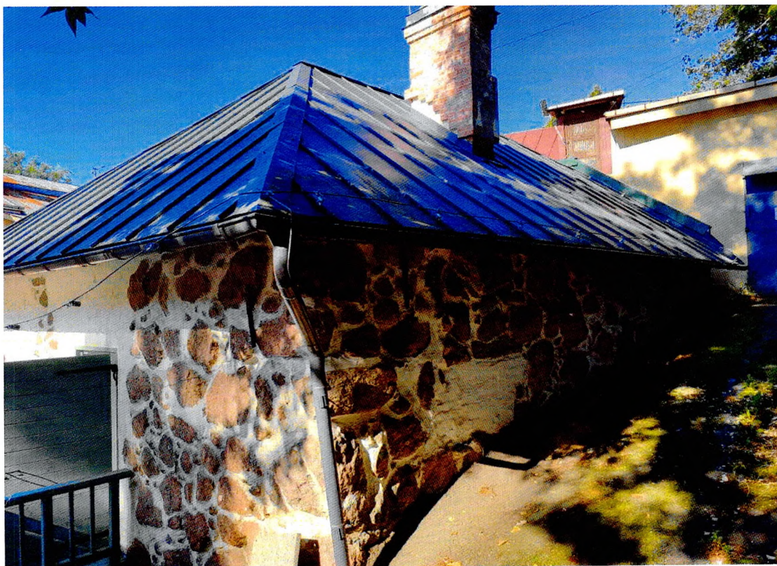
Фото 4. «Дом жилой», северо-восточный фасад здания.
