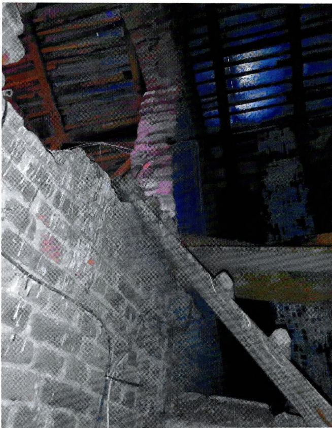
Фото 26, 27. Фрагмент чердачного помещения. Протечки в кровле
