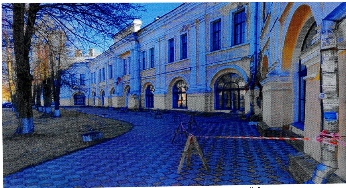
Фото 2. Общий вид на главный юго-западный фасад
