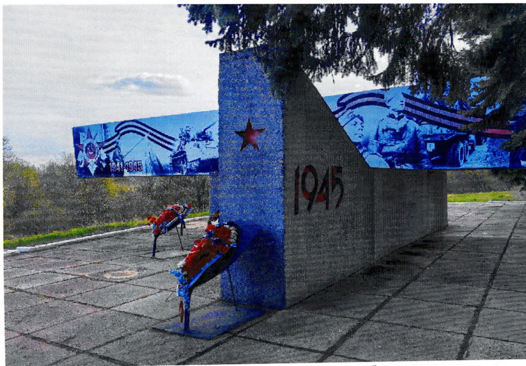
Фото 2. Фрагмент бетонной стелы-балки
