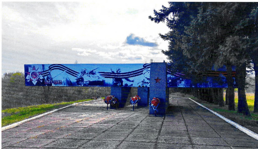
Фото 1. Бетонная стела-балка. Общий вид с северо-востока
