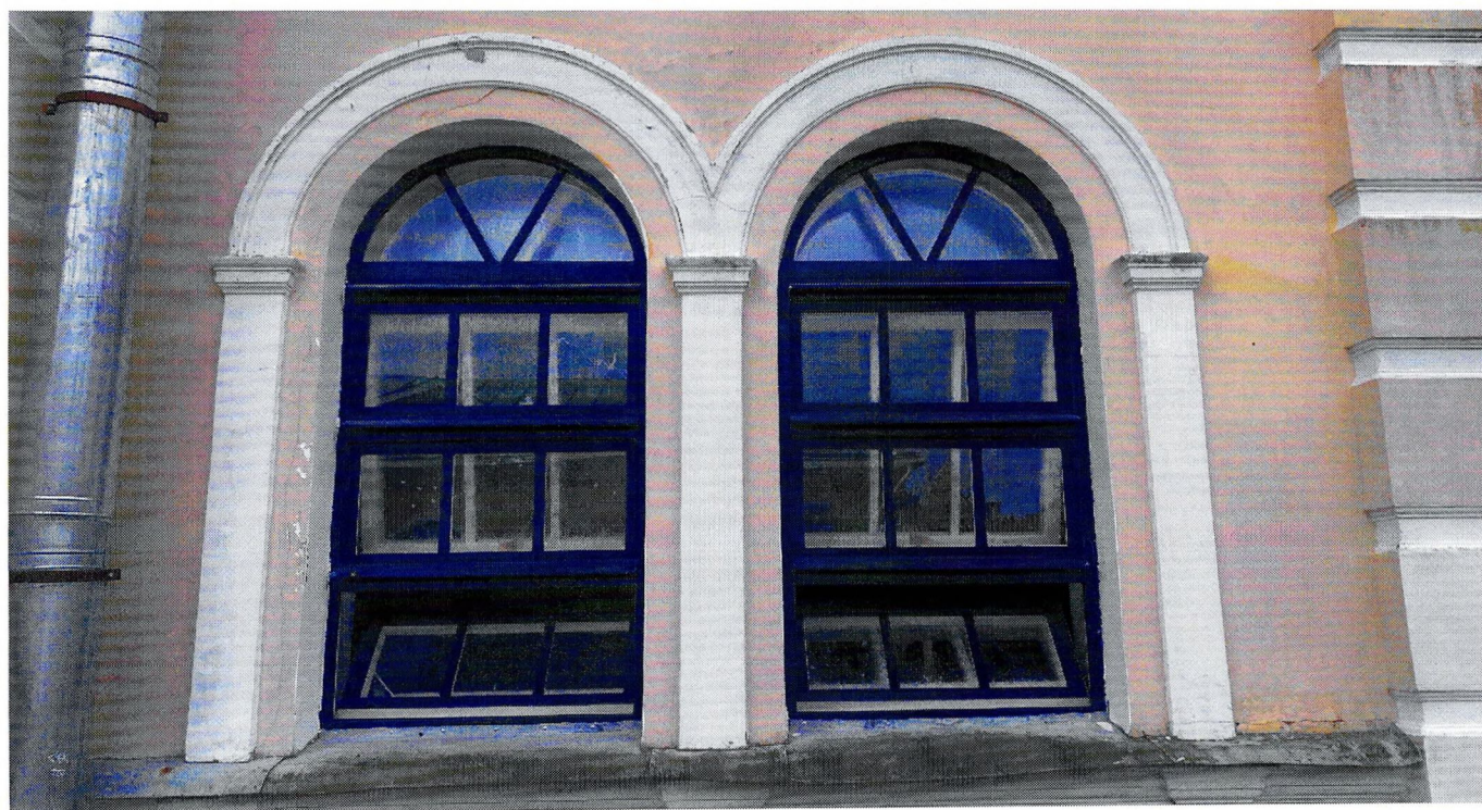
Фото 14. Фрагмент северо-восточного фасада
