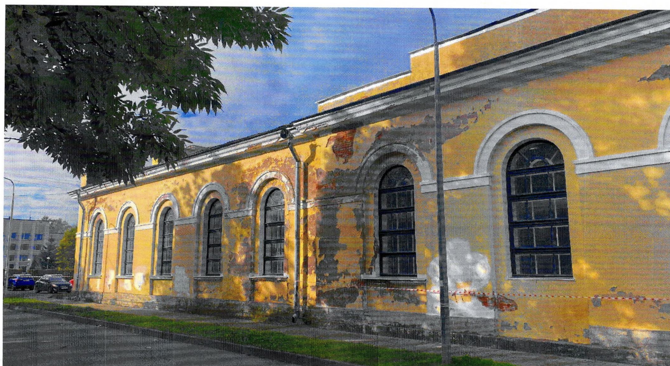
Фото 4. Фрагмент бокового юго-восточного фасада
