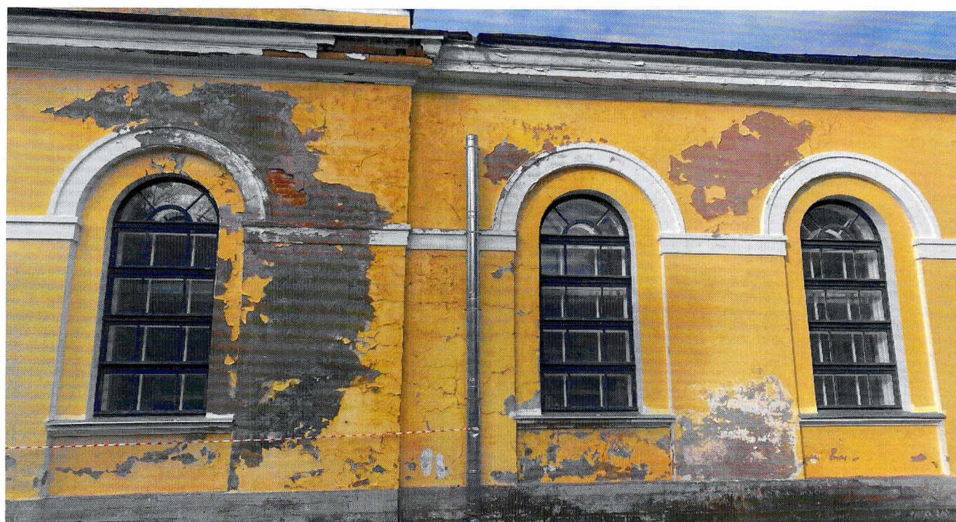
Фото 6. Фрагмент бокового юго-восточного фасада
