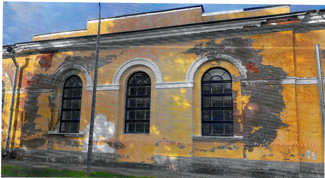
Фото 5. Фрагмент бокового юго-восточного фасада
