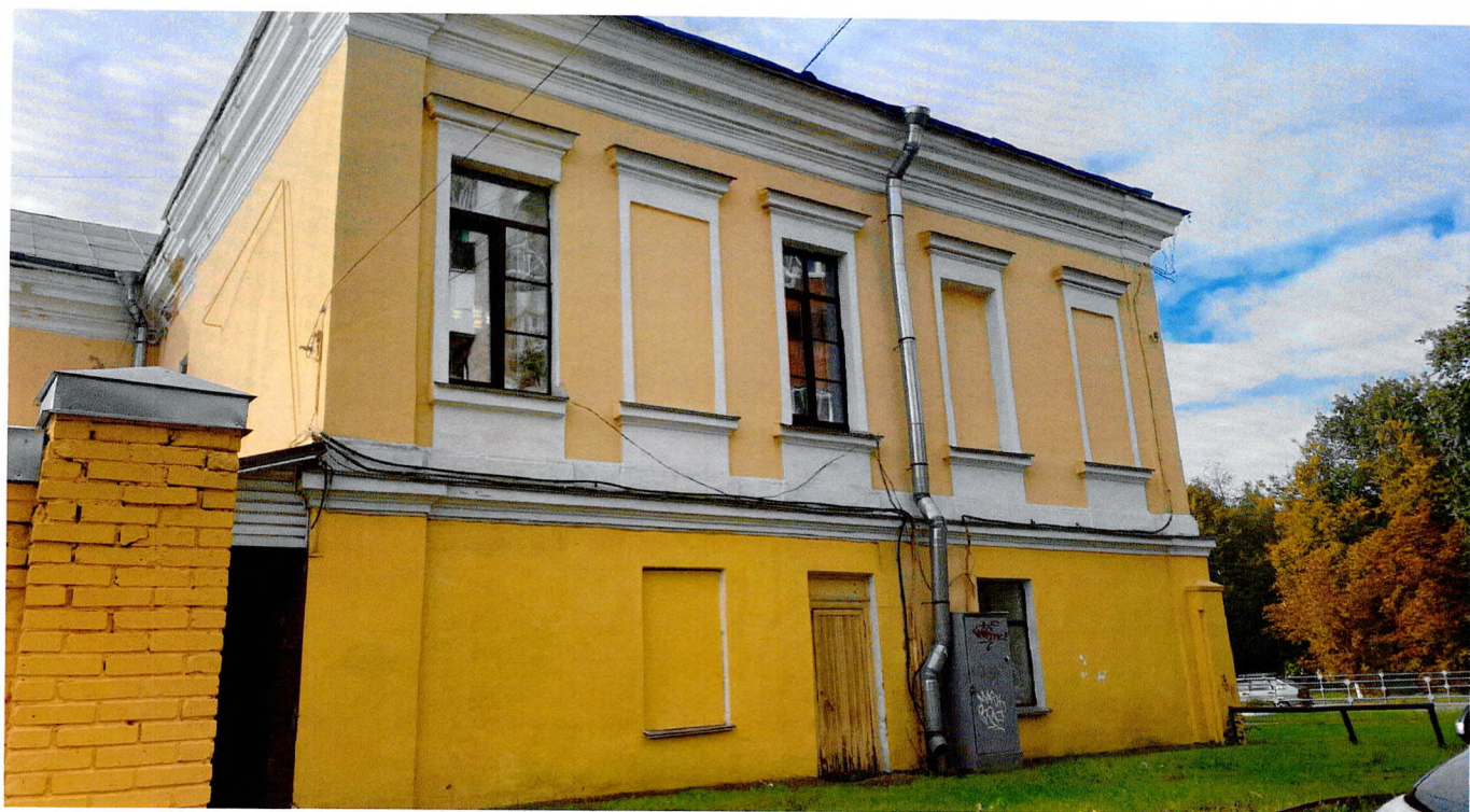
Фото 8. Фрагмент северо-восточного фасада
