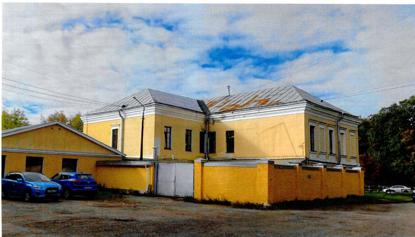
Фото 7. Общий вид с востока
