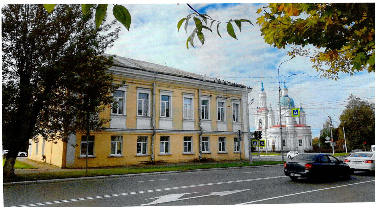
Фото 2. Общий вид с востока
