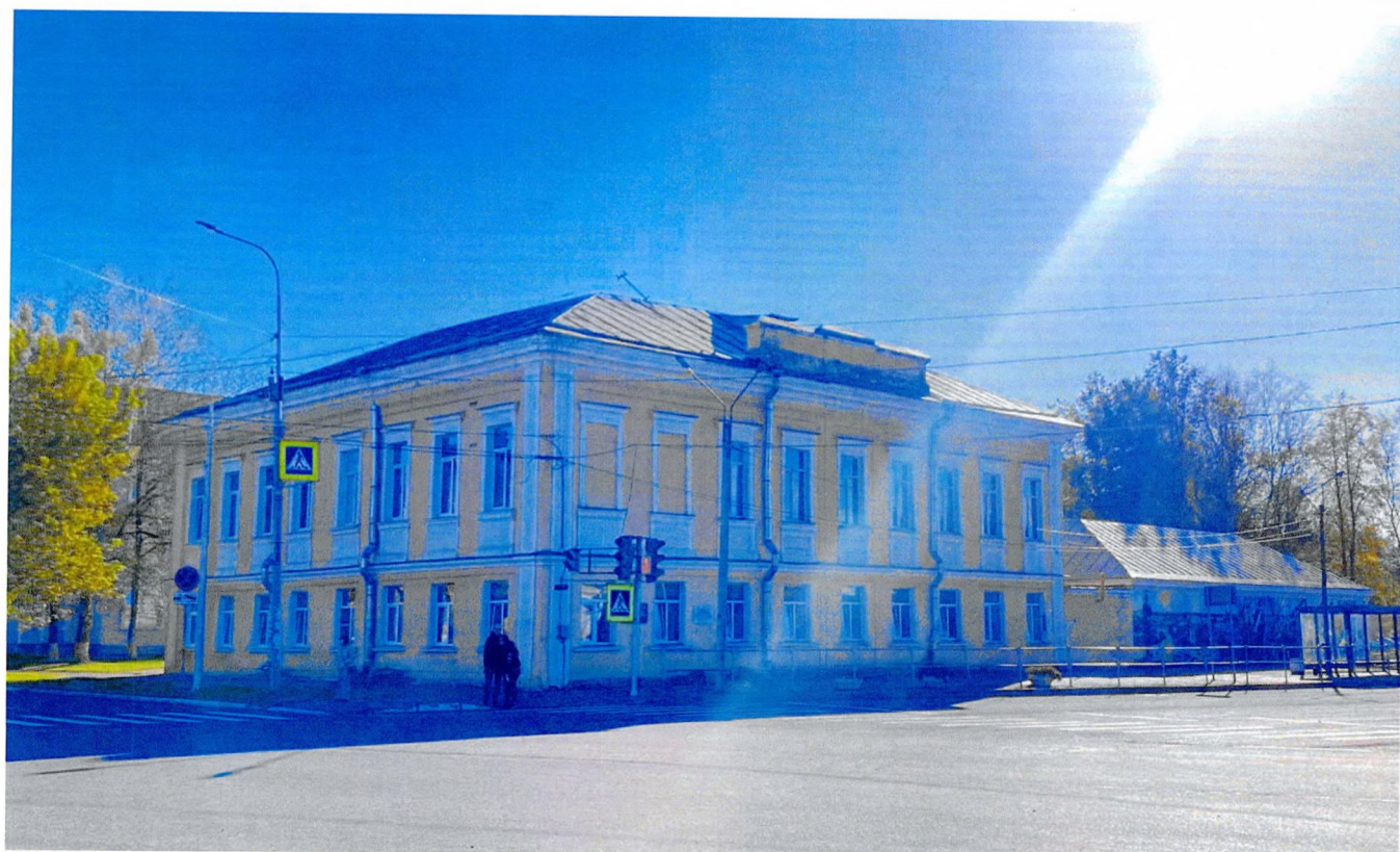
Фото 3. Общий вид с севера
