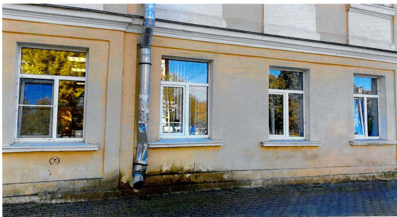
Фото 6. Фрагмент северо-западного фасада
