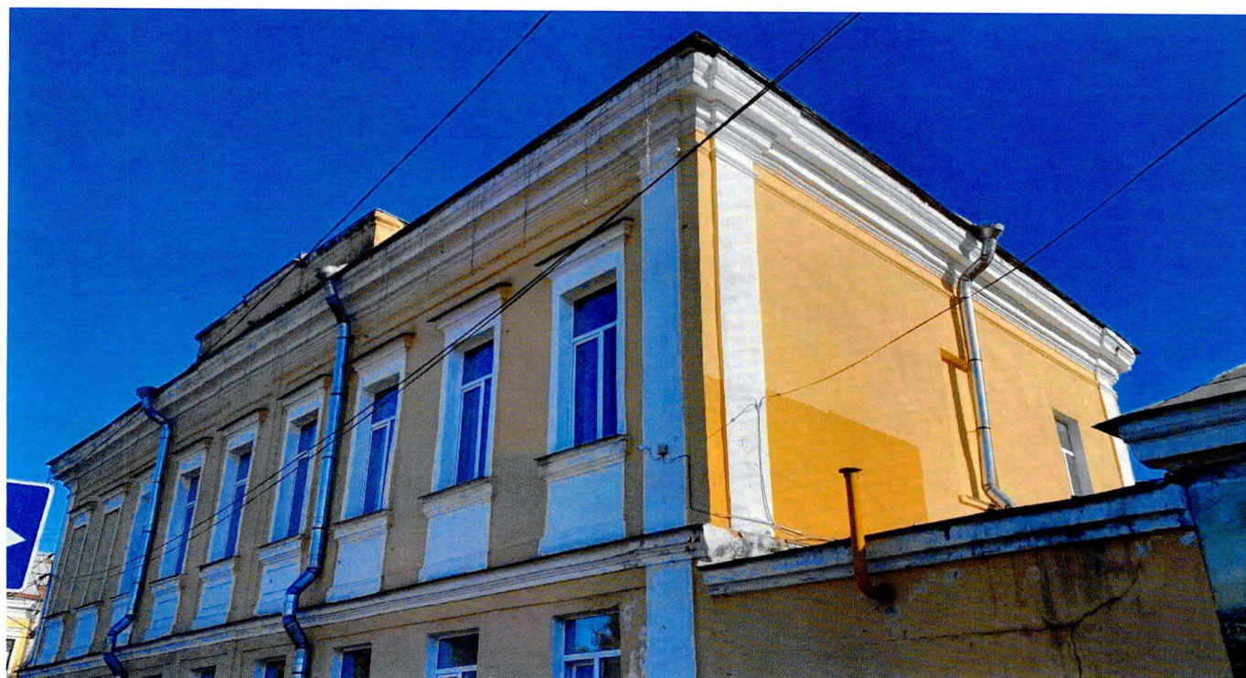
Фото 4. Фрагмент северо-западного фасада
