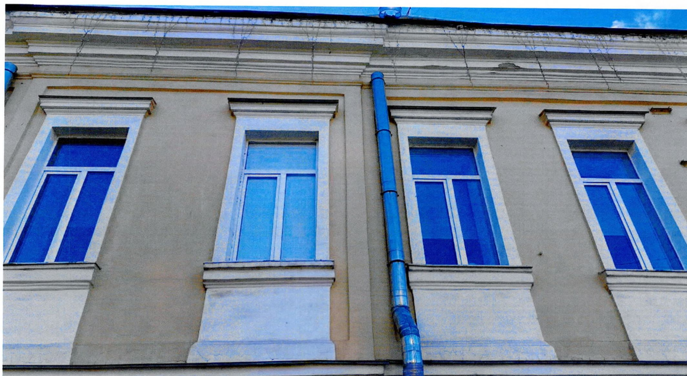
Фото 5. Фрагмент северо-западного фасада
