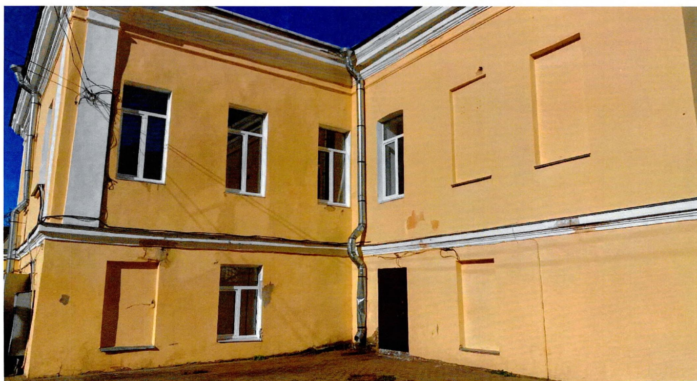
Фото 8. Фрагмент юго-западного фасада
