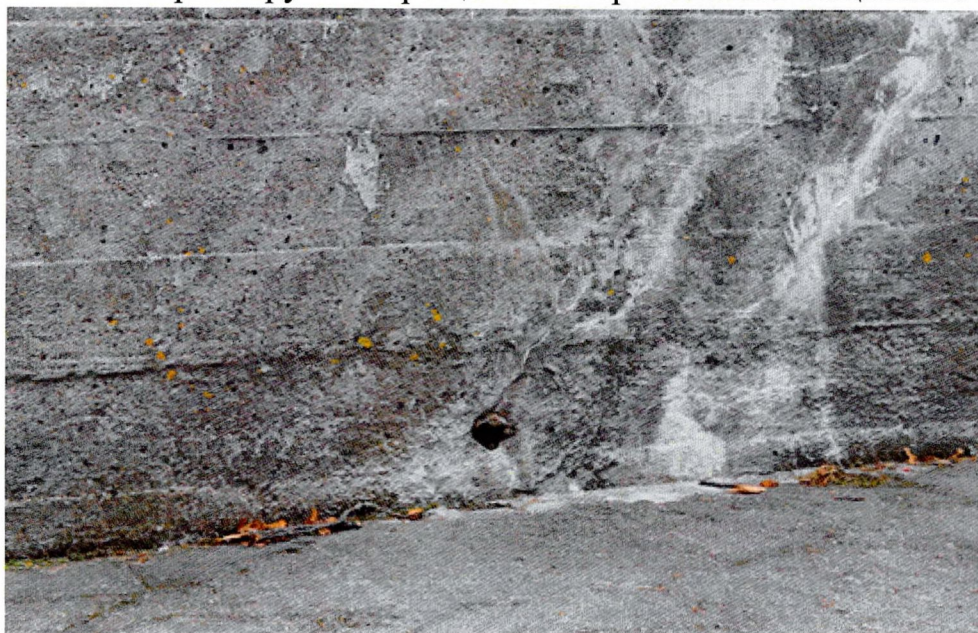
Фото 30. Фрагмент стенки четвертой смотровой площадки. Заделка трещин в бетоне цементным молочком. Также на поверхности присутствуют биопоражения, пылевые загрязнения и подтеки.
