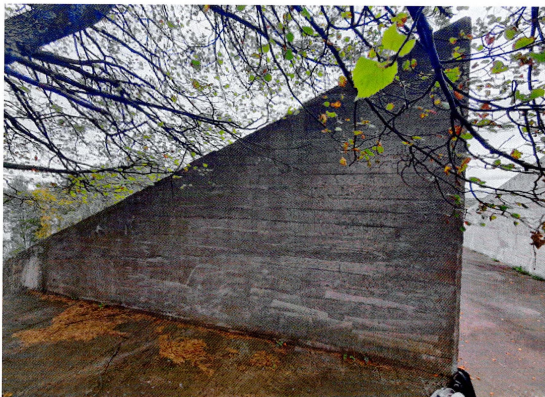
Фото 23. Северо-западная стена на второй смотровой площадке. Поверхность бетона потемнела, в нижней части заметны следы от валика и кисти, вероятно оставшихся после обработки гидрофобизатором. В левой части стены цементная домастиковка поверх трещины в бетоне.
