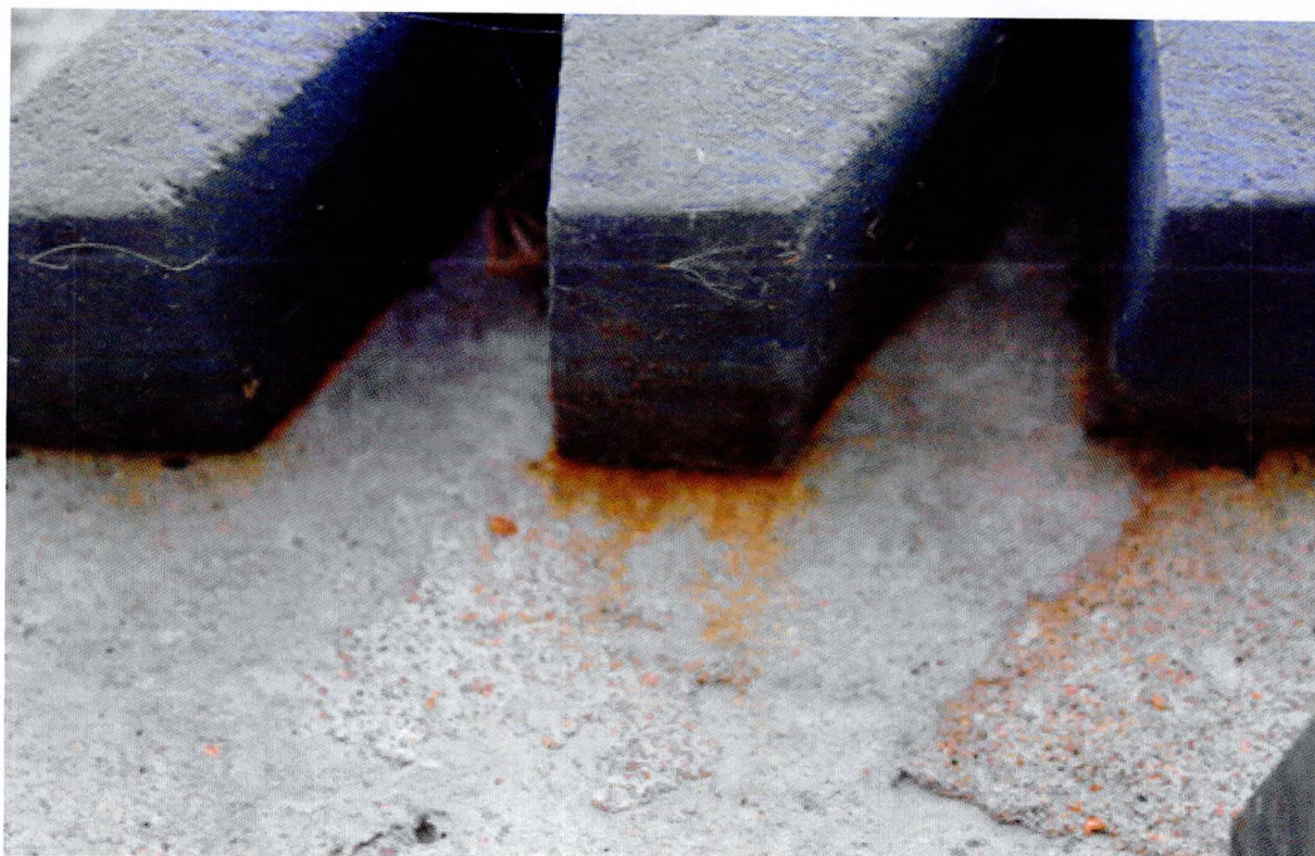
Фото 34. Фрагмент надписи на стене четвертой смотровой площадки. Подтеки ржавчины в местах примыкания металлических букв и бетонной поверхности.
