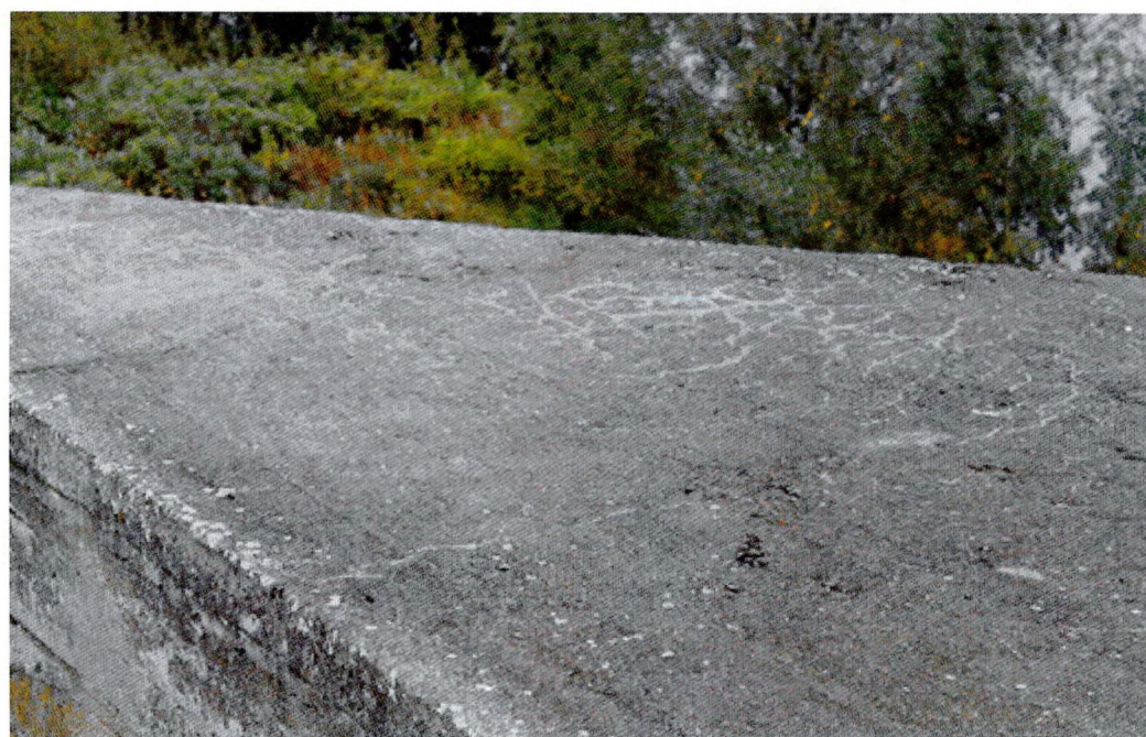
Фото 24. Фрагмент покрытия второй смотровой площадки. Растрескивание защитного слоя бетона, биопоражения, трудные пылевые и антропогенные загрязнения.
