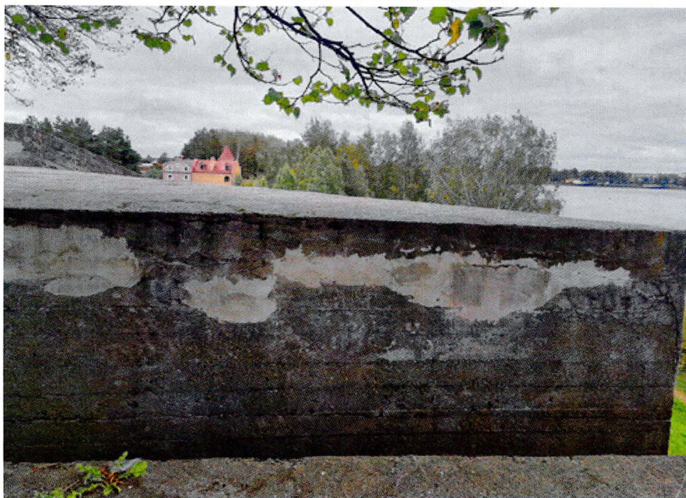
Фото 26. Фрагмент второй смотровой площадки. Горизонтальные трещины в стене, в том числе домастикованные поздними цементными составами. На поверхности бетона высолы, биопоражения, пылевые загрязнения.
