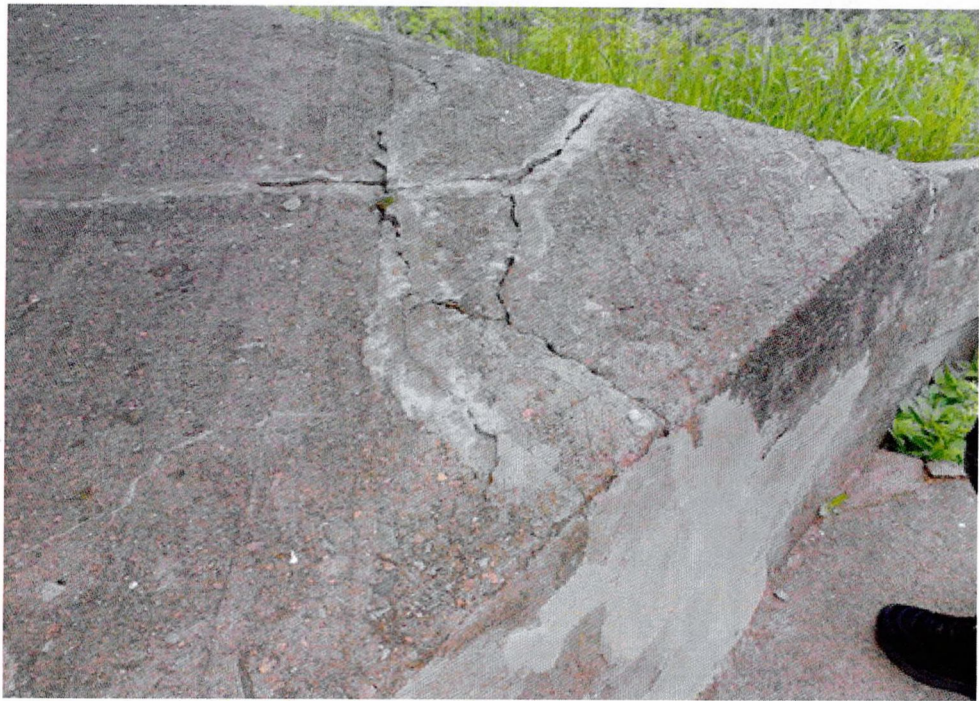
Фото 27. Фрагмент южной части четвертой смотровой площадки. Крупные трещины в бетонном покрытии, шириной раскрытия более 5 мм; порастание самосевом. На боковой стенке участок домастиковки поздними цементными составами. По всей поверхности бетона выступает крупный заполнитель.
