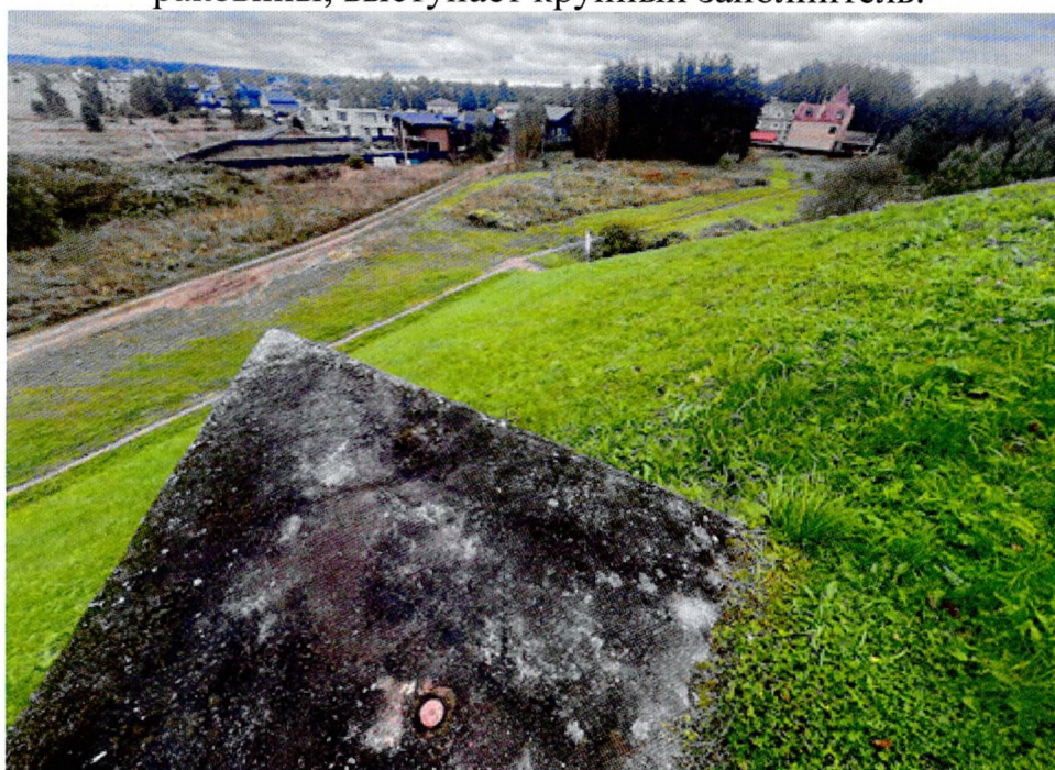
Фото 37. Небольшого бетонного уступа на северной грани пирамиды. Поверхность бетона сильно загрязнена, поражена мхами и плесенью, наблюдаются сетка мелких трещин, сколы по ребрам и высолы на поверхности.
