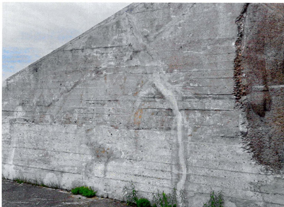
Фото 18. Северо-восточная стена на первой смотровой площадке. Вертикальные и горизонтальные трещины в стене, заделанные цементными растворами разных оттенков и толщины слоя. Присутствуют грязевые подтеки, сетки мелких трещин; поверхность бетона в раковинах и высолах.
