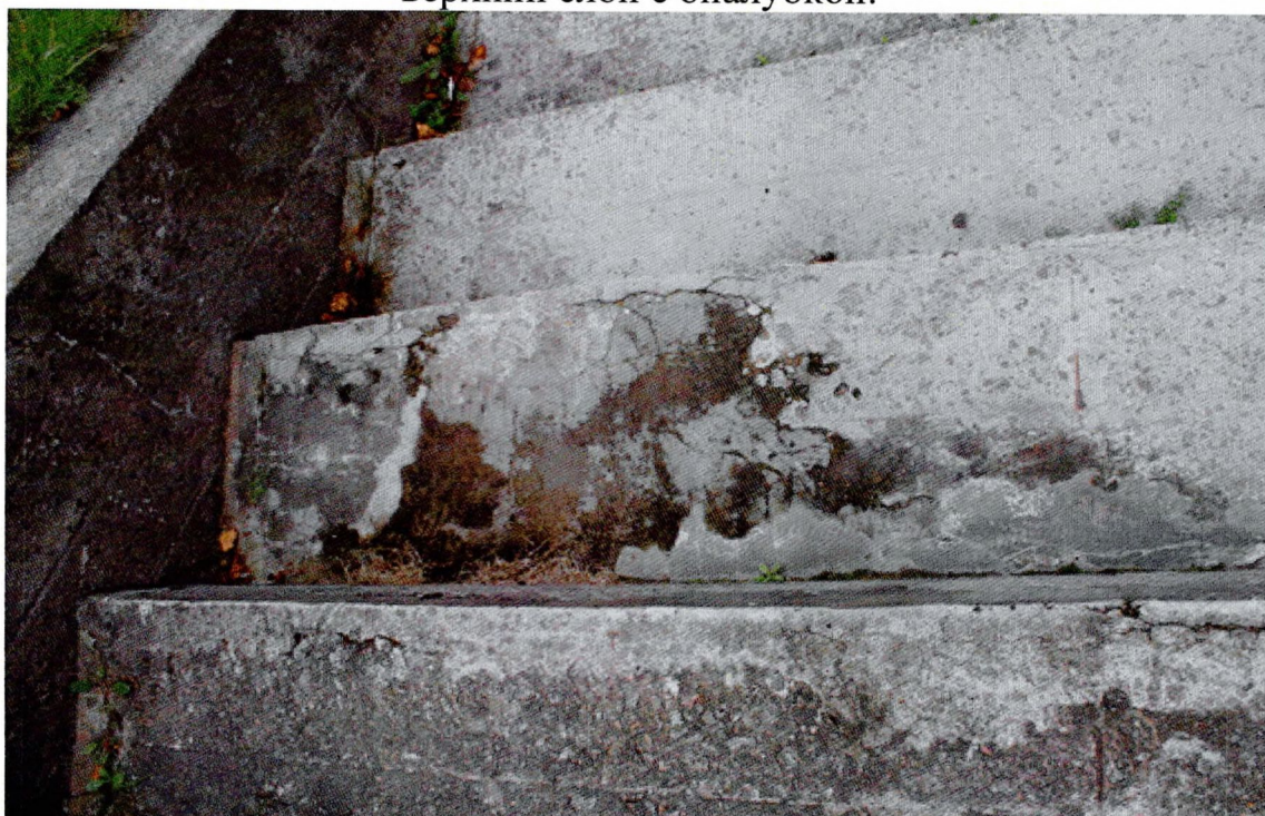
Фото 41. Фрагмент главной лестницы: ступени в средней части марша. Растрескивание и истощение защитного слоя бетона с оголением арматуры. Поверхностные биопоражения, сколы на ребрах ступеней. Поздние цементные домостиковки в швах, трещинах и на ребрах ступеней, порастание самосевом
