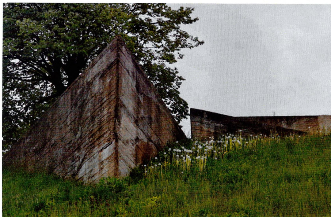
Фото 39. Внешние стенки второй смотровой площадки. Поверхность бетона сильно загрязнена, неоднородна по цвету, имеет продольные трещины и деструкцию защитного слоя бетона.
