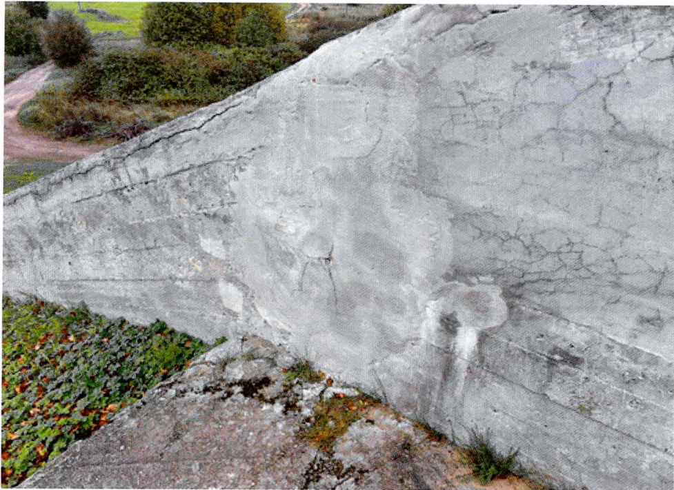
Фото 19. Фрагмент северо-восточной стены на первой смотровой площадке. Вспучивание поздней цементной домастиковки, трещина вдоль верхней кромки стены, шириной раскрытия более 5 мм. Растрескивание бетонного покрытия, биопоражение и порастание самосевом; потемнение бетонного покрытия.
