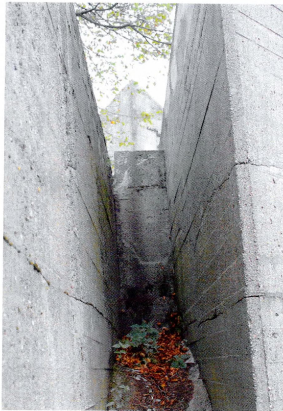
Фото 25. Участок между стенами второй и третьей смотровых площадок. Трещины в бетоне, шириной раскрытия более 3 мм, вдоль опалубки. Поверхность имеет биопоражения, пылевые загрязнения, раковины. По земле залита бетонная подливка с уклоном для стока воды. Засорена сухой листвой, поросла самосевом, на поверхности также присутствуют биопоражения и следы систематического намокания.
