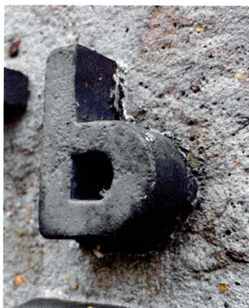
Фото 32-33. Буквы из надписи на стене четвертой смотровой площадки. Буквы металлические поздние; окрашены в несколько слоев черной краской. Красочное покрытие неравномерное с кратерами, имеет плохое отверждение, из-за чего на поверхности остаются следы кисти, а краска легко соскабливается.
