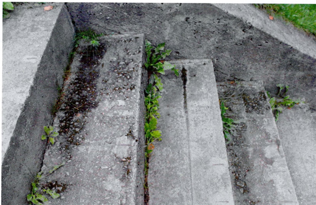
Фото 42. Фрагмент главной лестницы: ступени в верхней части марша. Деструкция защитного слоя бетона с оголением корродированной арматуры, биопоражения на поверхности бетона, порастание самосева. Расхождение сопряжения деталей и образование щелей. На поверхности подпорной стенки присутствуют раковины, биопоражения и высолы.
