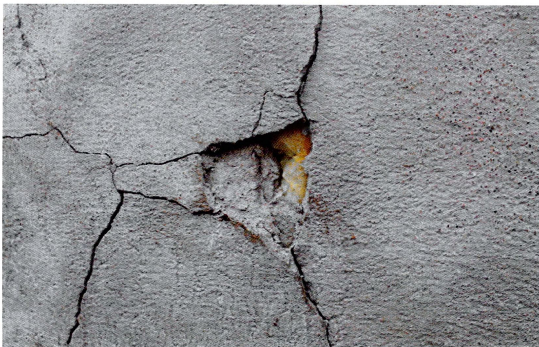
Фото 20. Фрагмент домастиковочного слоя северной стены на первой смотровой площадке. Вспучивание поздней цементной домастиковки поверх сквозной трещины в стене; трещина заполнена монтажной пеной.
