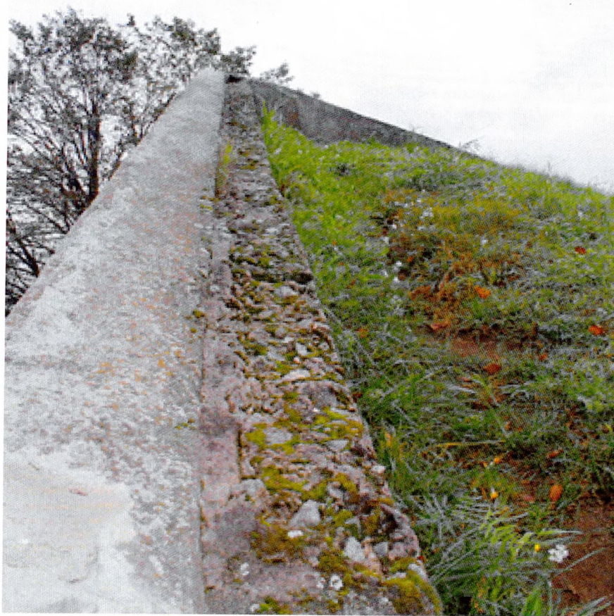
Фото 21. Фрагмент верхней грани южной стены на первой смотровой площадке. Поверхность бетона разрушена, имеет раковины, оголение крупного заполнителя, биопоражение и порастание мхом.
