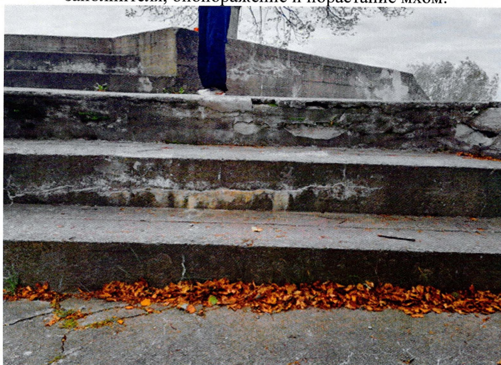
Фото 22. Фрагмент лестницы на третью смотровую площадку. Деструкция и отслоение защитного слоя бетона, горизонтальные трещины, потемнение поверхности. Присутствуют поздние цементные домостиковки, порастание трещин самосевом, высолы.
