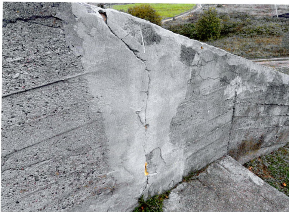
Фото 36. Фрагмент северо-западной стены-ребра четвертой смотровой площадки. Крупная вертикальная трещина в стене и трещина вдоль верхней грани заделаны цементными составами разных цветов. В месте сквозного разрыва вертикальная трещина заделана монтажной пеной. На поверхности бетона также присутствуют раковины, выступает крупный заполнитель.
