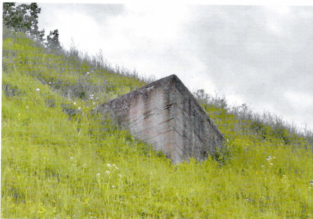
Фото 38. Стенки небольшого бетонного уступа на северной грани пирамиды. Поверхность бетона сильно загрязнена, имеет биопоражения и продольные трещины.
