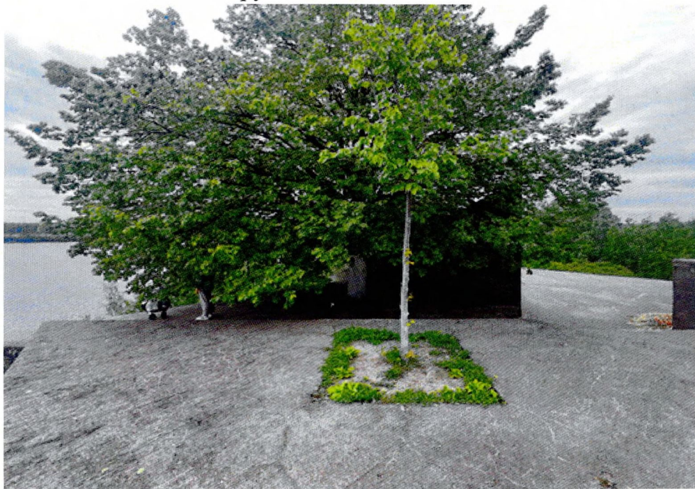
Фото 28. Фрагмент третьей смотровой площадки. Растрескивание защитного слоя бетона, потемнение поверхности, пылевые загрязнения. Клумба с проплешинами и поросла самосевом, газон отсутствует.
