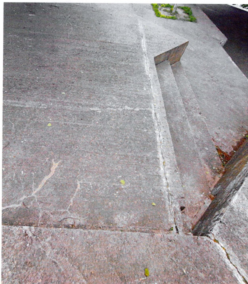
Фото 29. Фрагмент четвертой смотровой площадки. Вдоль лестничного марша крупная трещина. Растрескивание защитного слоя бетона
