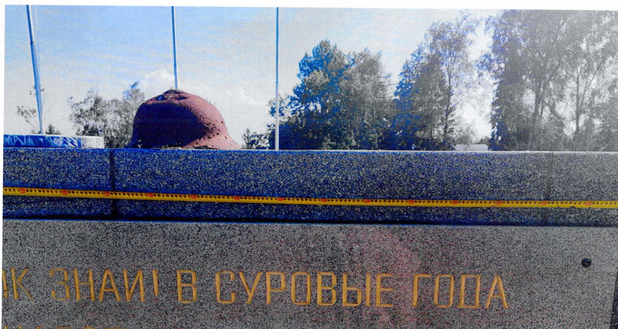
Фото 29. Вид на мемориальную плиту. Выветривание шовного раствора.
