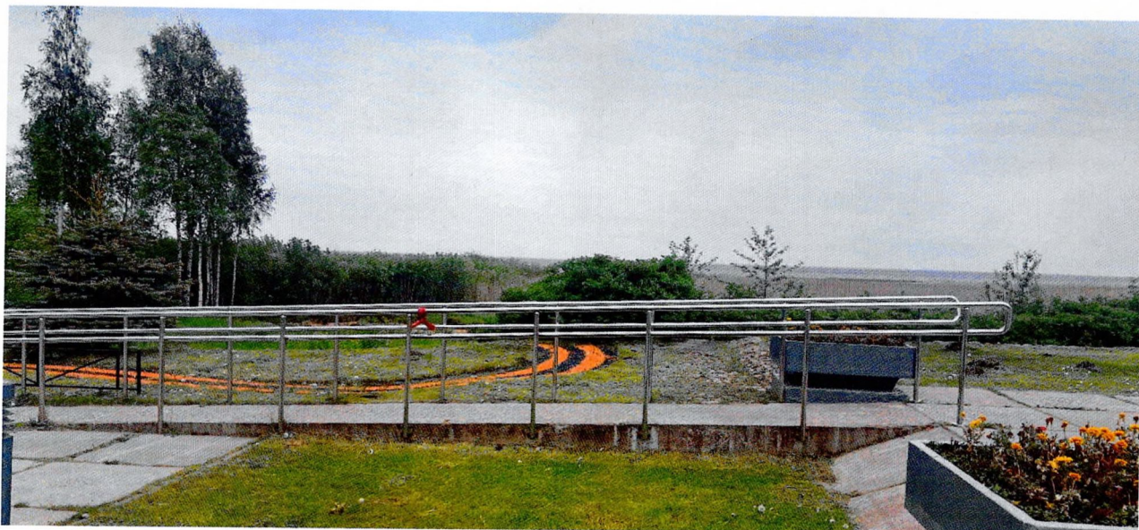
Фото 41. Вид на пандус севернее мемориала «Разорванное кольцо». Следы антропогенных загрязнений, систематичного намокания, коррозии металла ограждений, мелкие сколы железобетонной конструкции.
