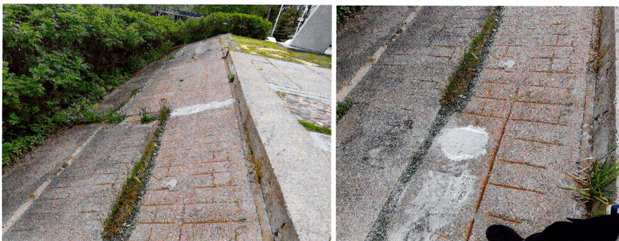
Фото 45. Вид на железобетонные плиты на склоне на восточной части территории. Следы антропогенных загрязнений, поздних ремонтов, биопоражений, оголение арматурной сетки.
