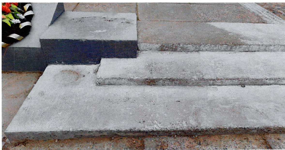
Фото 40. Вид на лестницу перед мемориалом «Разорванное кольцо» западное мемориала. Мелкие сколы железобетонной конструкции.
