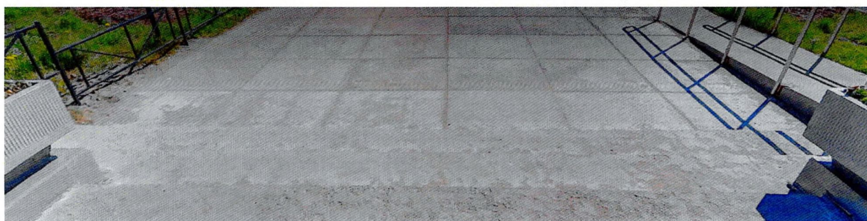
Фото 35-36 Вид на лестницу у главного входа на территорию в западной части. Следы антропогенных загрязнений, шелушения красочного слоя, мелкие сколы железобетонной конструкции.
