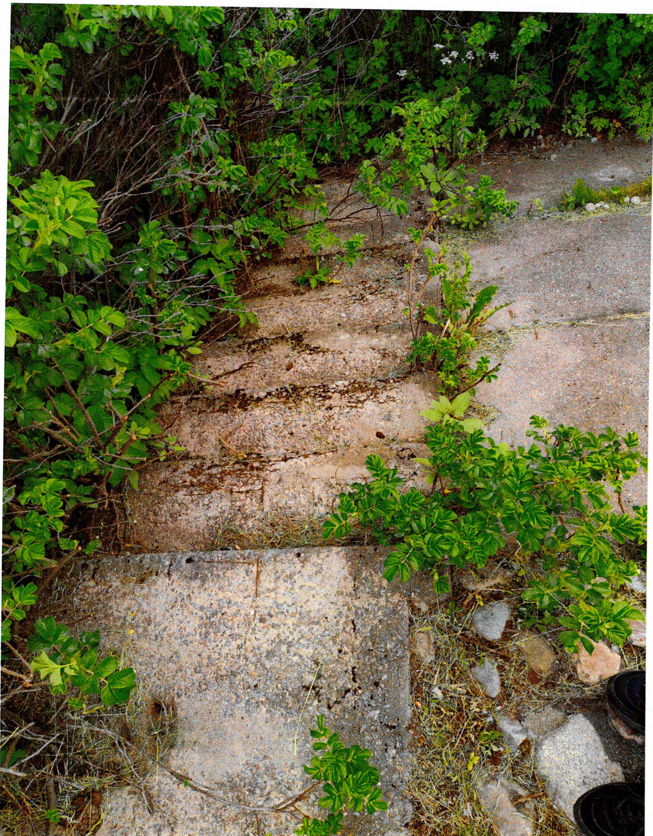
Фото 46. Вид на железобетонную лестницу на склоне в восточной части территории. Следы антропогенных загрязнений, биопоражений, поздних ремонтов, мелкие сколы железобетонной конструкции, оголение арматурной сетки.
