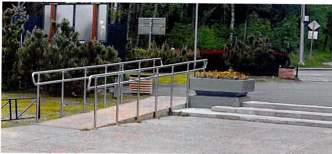
Фото 37. Вид на пандус у главного входа на территорию с западной стороны. Следы антропогенных загрязнений, мелких сколов, коррозии металла ограждений.
