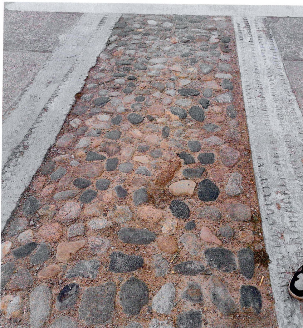
Фото 44. Вид на след протектора грузовика. Следы антропогенных загрязнений, шелушения красочного слоя.
