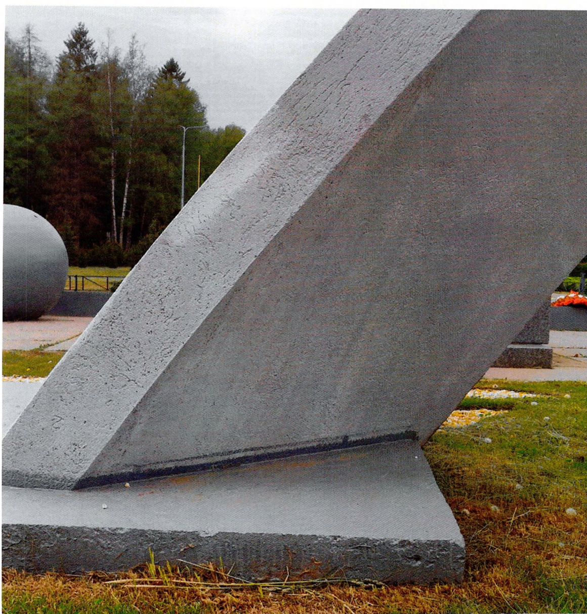
Фото 24. Вид на мемориал. Следы отслоения красочного слоя.
