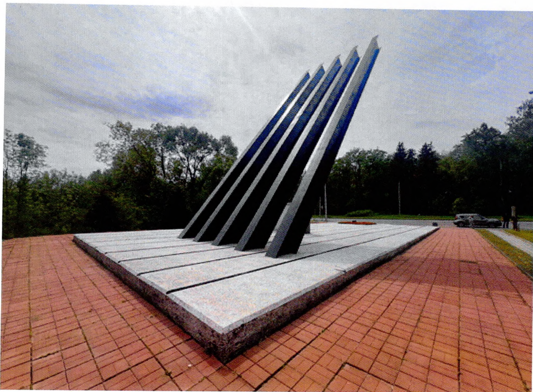
Фото 3. Вид с северо-востока на двутавровые балки памятника.
