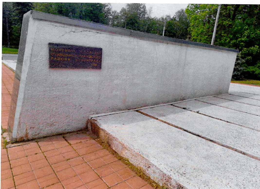
Фото 5. Обратная сторона мемориальной плиты с табличкой. Плита оштукатурена и побелена. Заметны трещины в отделке, локальные утраты штукатурки у основания плиты, подтеки.
