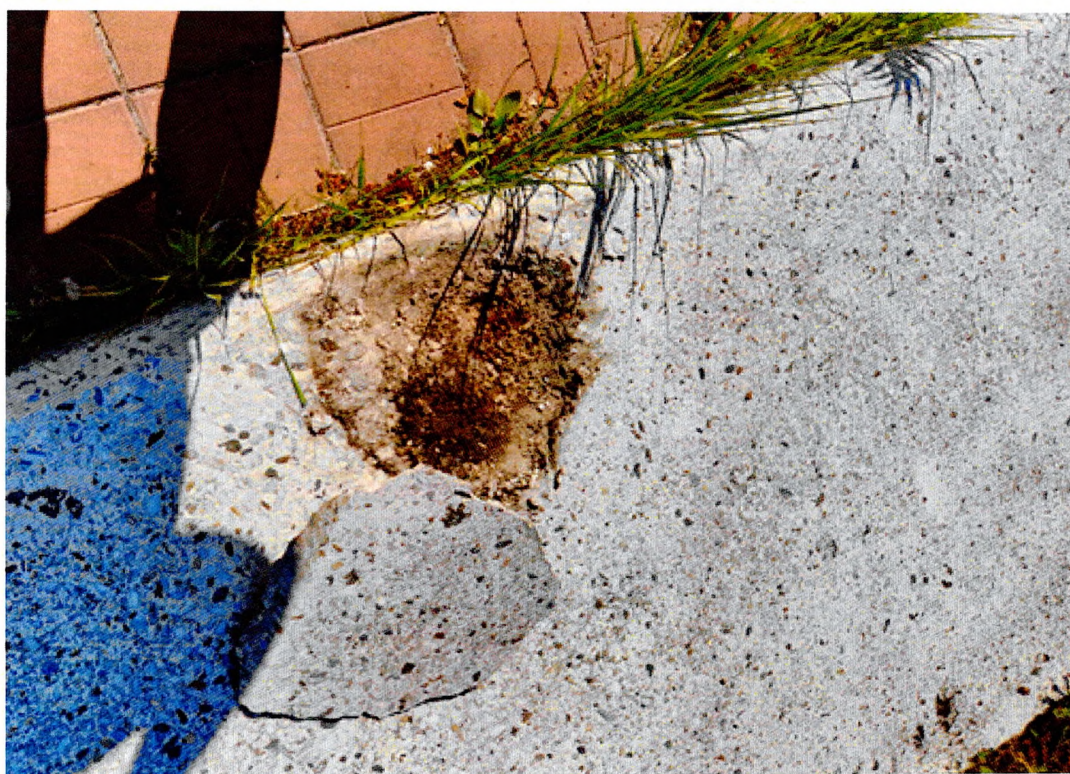
Фото 6. Фрагмент бетонной плиты стилобата с покрытием «терраццо» (с юга).
