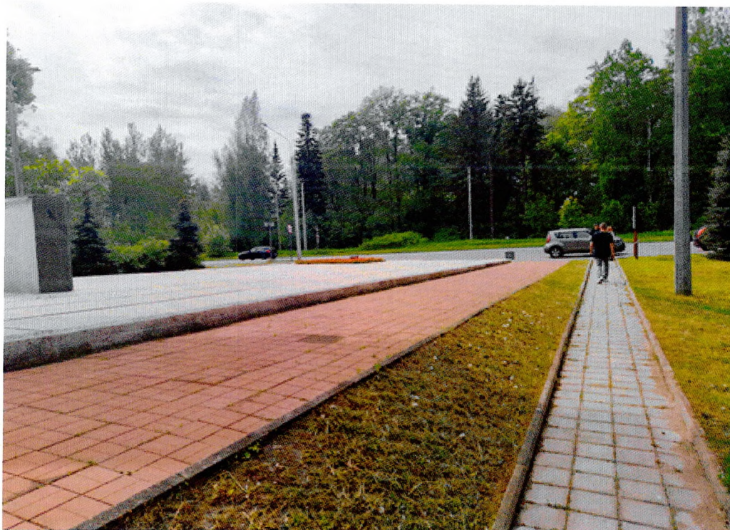
Фото 13. Территория вокруг памятника с площадкой, газоном и дорожкой, вид с востока на запад. Газон уложен по бетонной георешетке и имеет проплешины, потемнения. Мощение площадки из красной кирпичной плитки имеет неровности покрытия, в местах примыкания к памятнику и в швах поросла самосевом, швы также имеют пустоты. Покрытие из бетонной серой плитки дорожки имеет те же дефекты.
