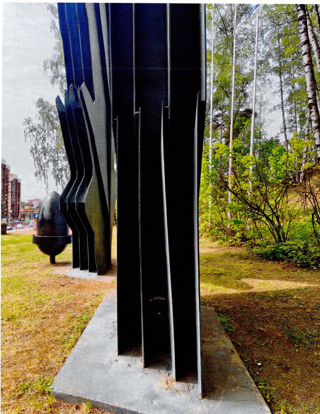
Фото 18. Вид на лавровый лист. Искривление металлического листа.
