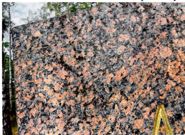
Фото 23-24. Вид на мемориальную плиту. Следы биопоражений.
