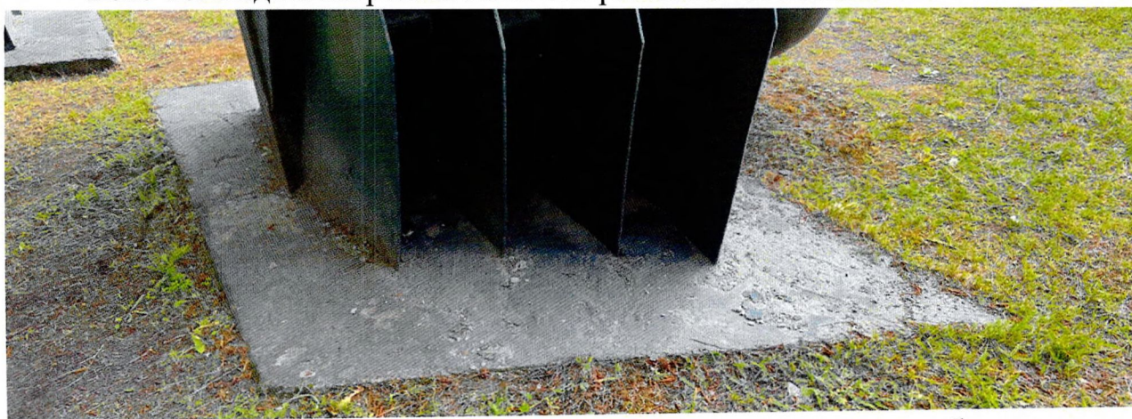
Фото 19. Вид на дубовый лист. Следы бипоражений на железобетонном.
