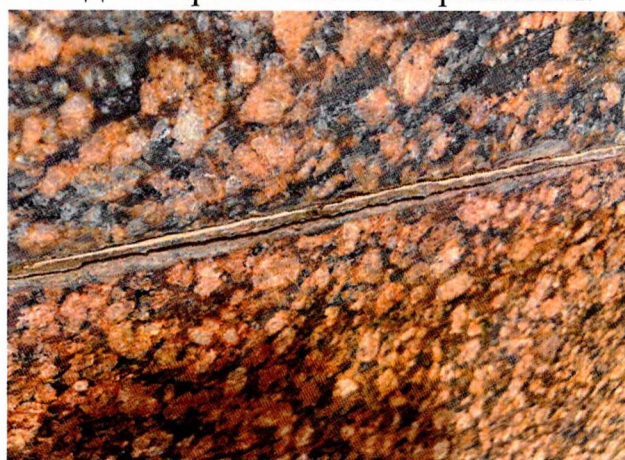
Фото 21-22. Вид на мемориальную плиту. Выветривание шовного раствора.
