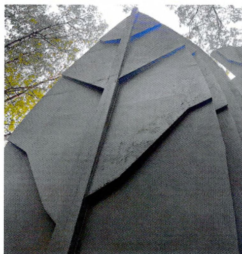
Фото 16-17. Вид на лавровый лист. Следы шелушения красочного слоя на металле и основании.
