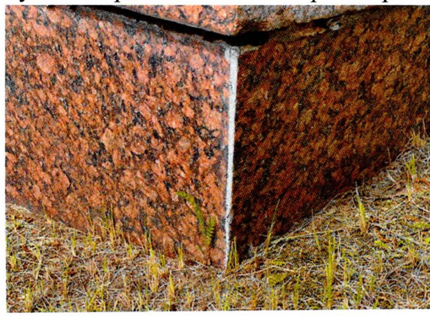
Фото 23-24. Вид на мемориальную плиту. Следы биопоражений.
