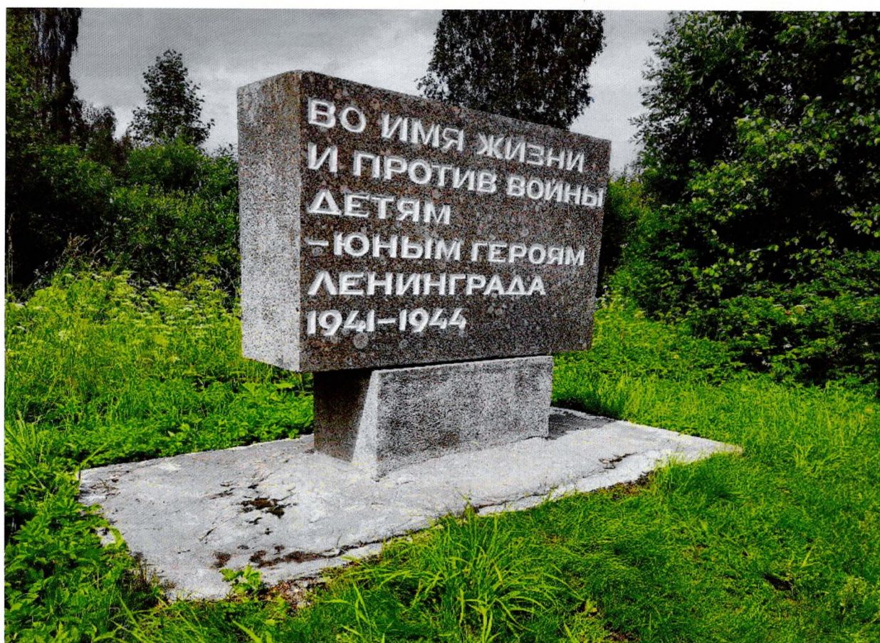
Фото 17. Общий вид мемориальной плиты 2. Пылеватые и сажистые загрязнения поверхностей. Растрескивание и повреждение поздней мастиковки, выполненной поверх фундамента мемориальной плиты.
