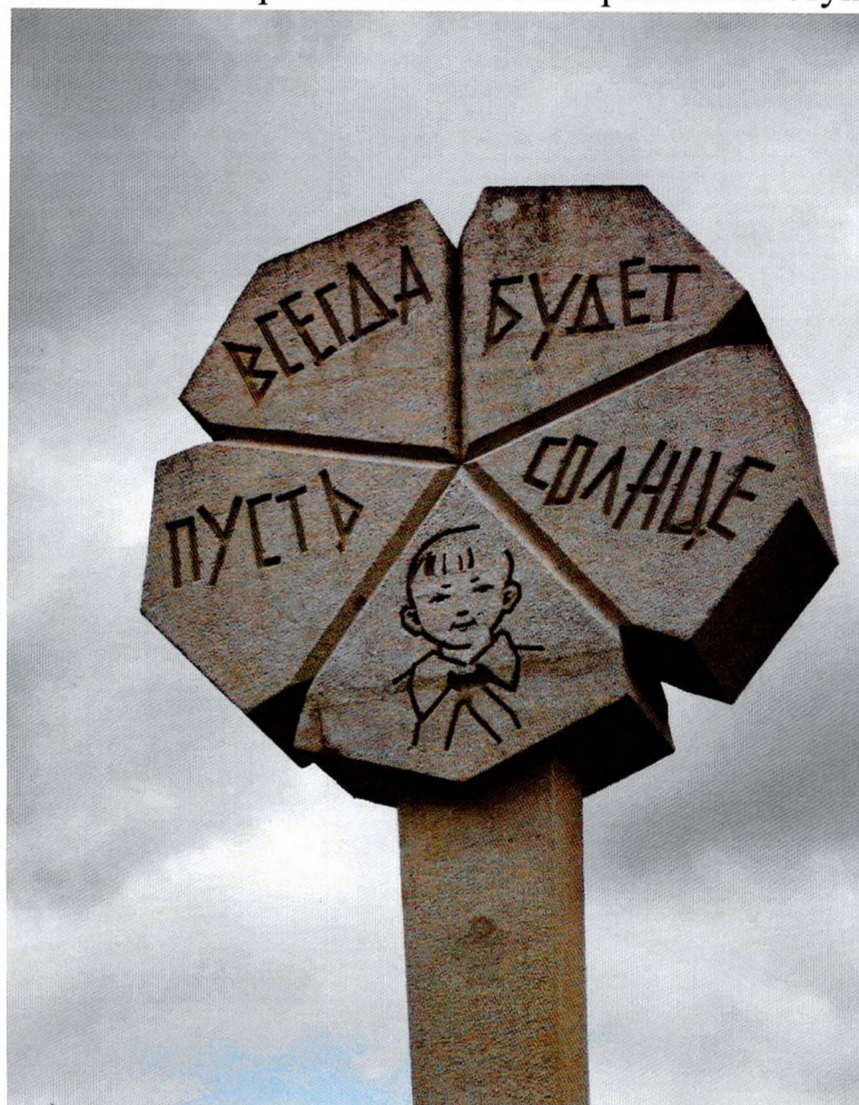
Фото 31. Цветок доминанты «Каменный цветок». Биопоражения и поверхностные пылеватые (сажистые) загрязнения по элементу. Трещины по отделочному слою монумента.
