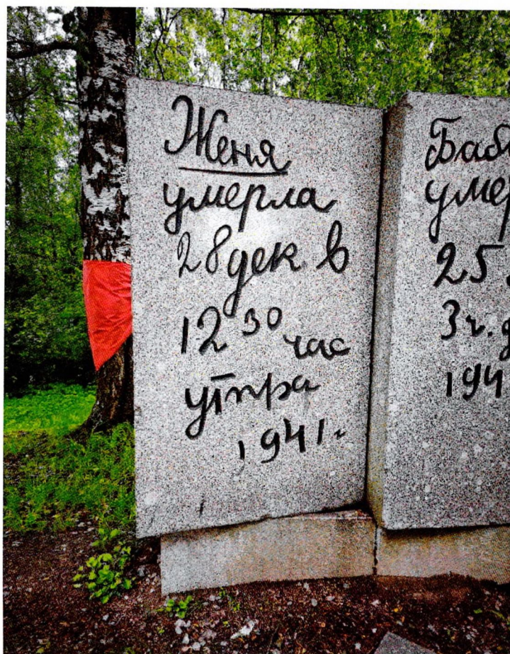
Фото 45. Мемориальные плиты «Дневник Тани Савичевой». Участки биопоражения по элементам монумента. Локальные участки сколов плит. Участки поновлений
