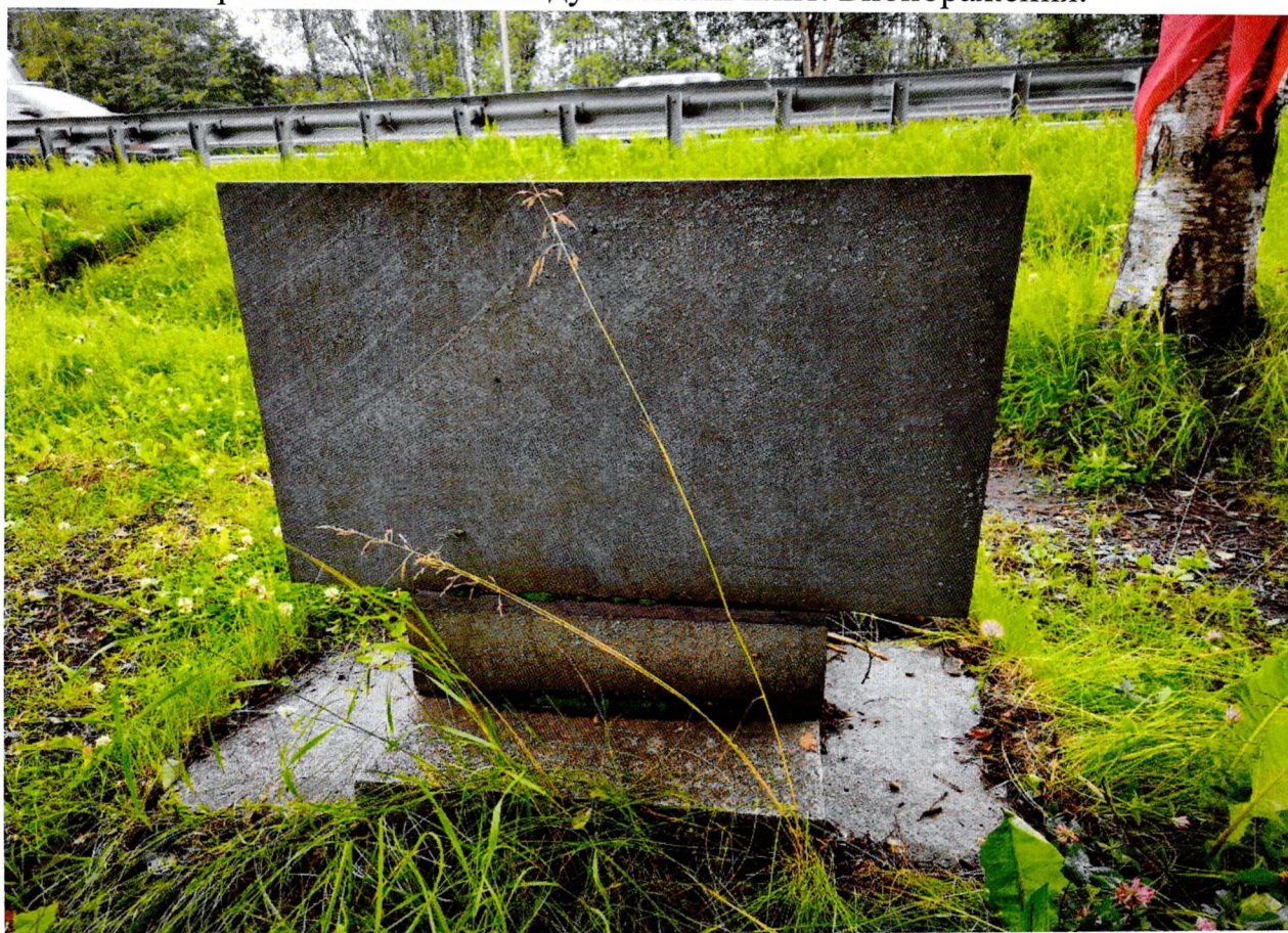
Фото 11. Общий вид памятной плиты Левенкову А.Д. Произрастание растительности между блоками плит. Биопоражения
