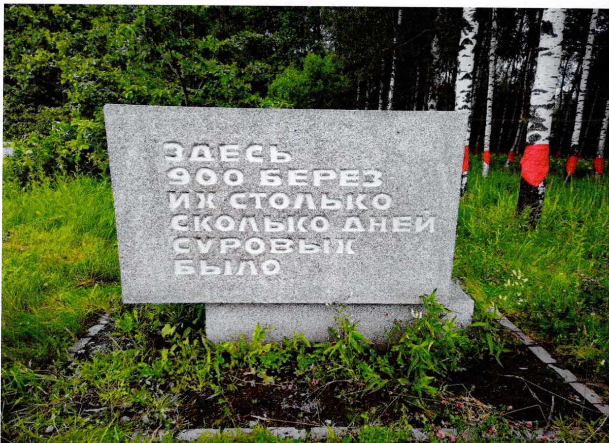
Фото 3. Общий вид мемориальной плиты 1. Образование трещин и зазоров по швам между блоками
