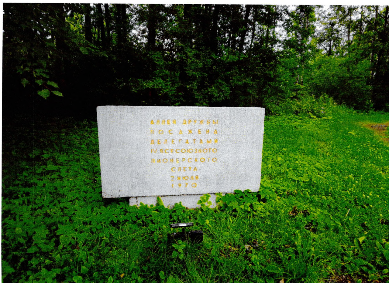
Фото 39. Мемориальная плита «Аллея дружбы». Трещины по отделочному слою. Повреждение раствора в швах между блоками плиты и постамента.
