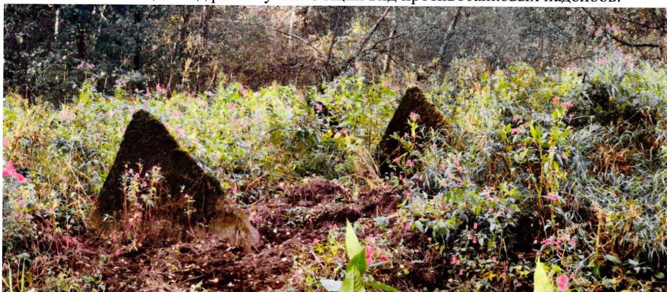
Фото 8. Общий вид противотанковых надолбов. Поверхность загрязнена биопоражениями.
