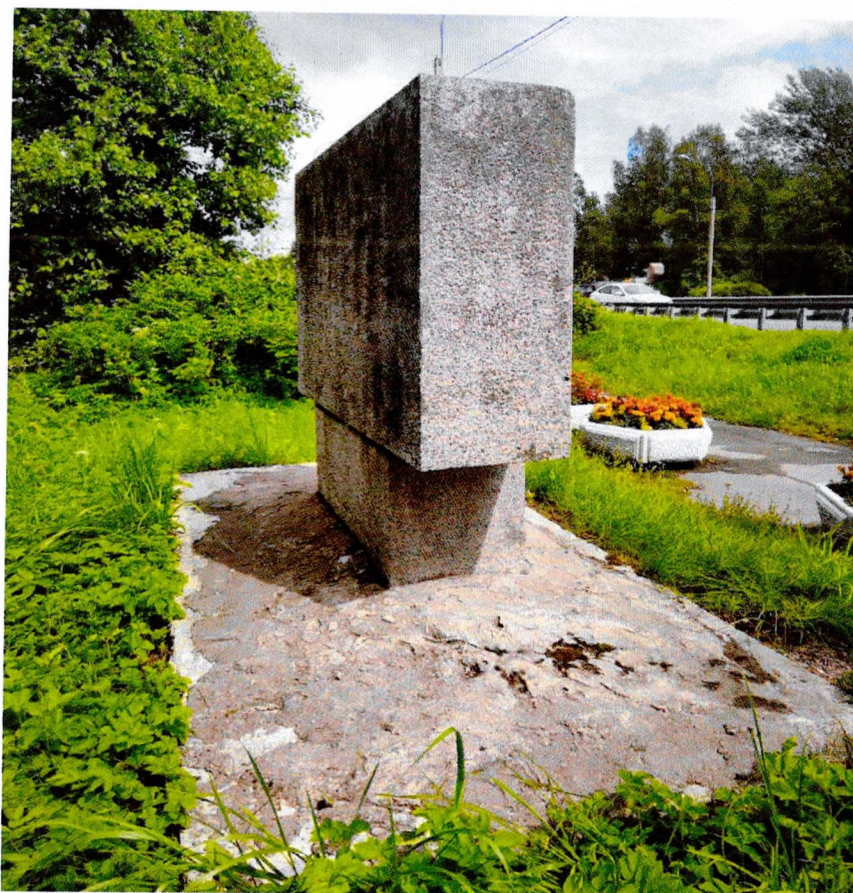
Фото 18. Общий вид мемориальной плиты 2. Пылеватые и сажистые загрязнения поверхностей. Растрескивание и повреждение поздней мастики, выполненной поверх фундамента мемориальной плиты. Следы намокания и биопаражения на гранитных плитах.
