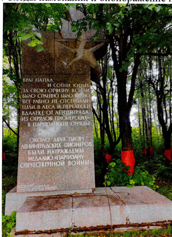
Фото 37. Памятная стела 5. Ремонтные поновления цементными растворами. Поверхностные пылеватые(сажистые) загрязнения. Сколы и трещины гранитных блоков. Образование трещин и зазоров по швам между отдельными блоками постаментов. Следы намокания и биопоражение по монументу.
