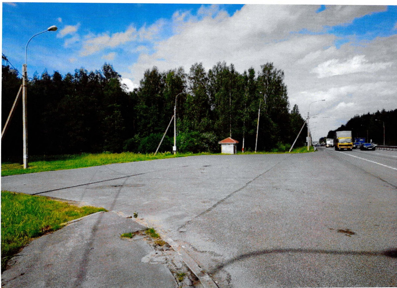
Фото 59. Общий вид на парковку.
