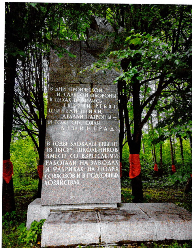
Фото 36. Памятная стела 4. Ремонтные поновления цементными растворами. Поверхностные пылеватые(сажистые) загрязнения. Сколы и трещины гранитных блоков. Образование трещин и зазоров по швам между отдельными блоками постаментов. Следы намокания и биопоражение по монументу.
