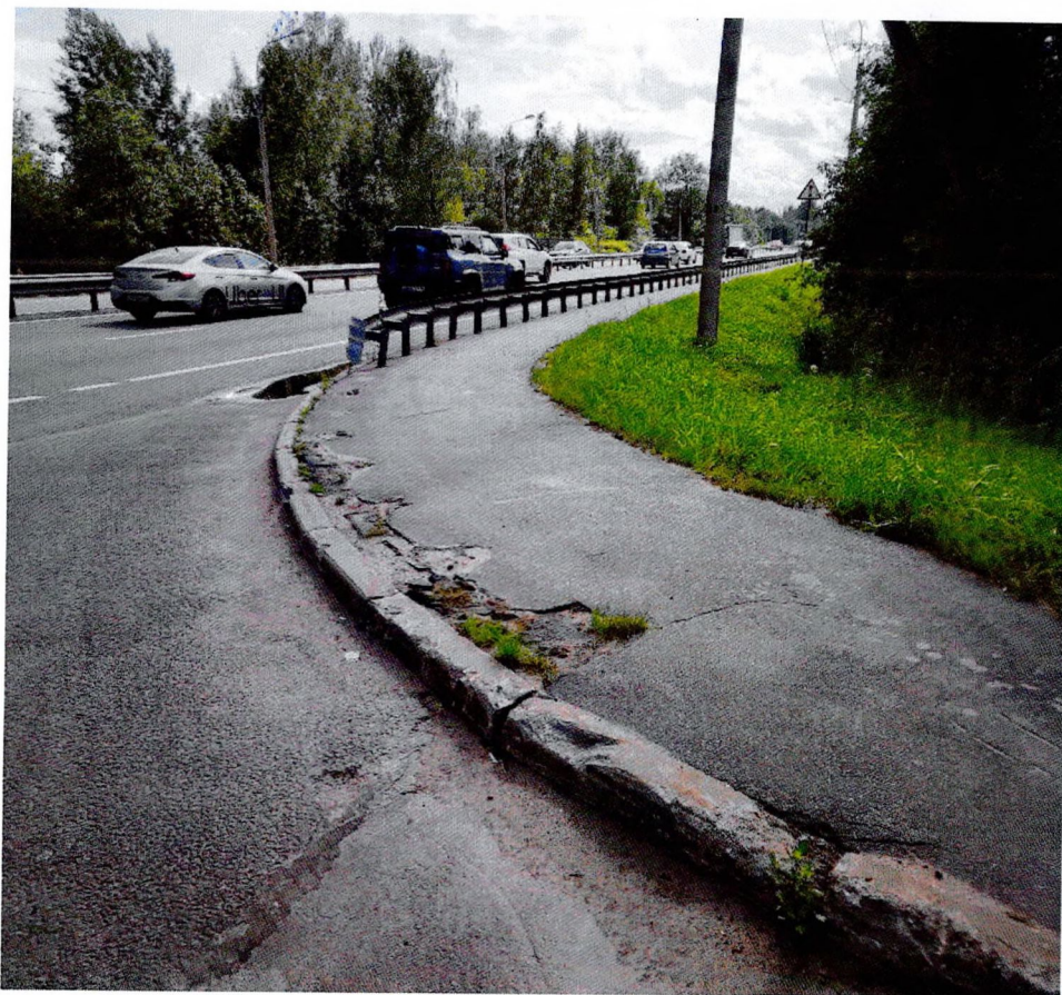
Фото 58. Общий вид бордюрного камня тротуара.
