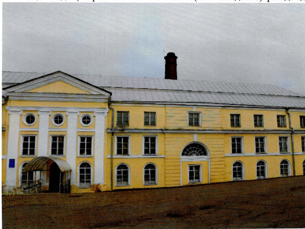
Фото 2. Общий вид. Левая часть главного (юго-западного) фасада здания.
