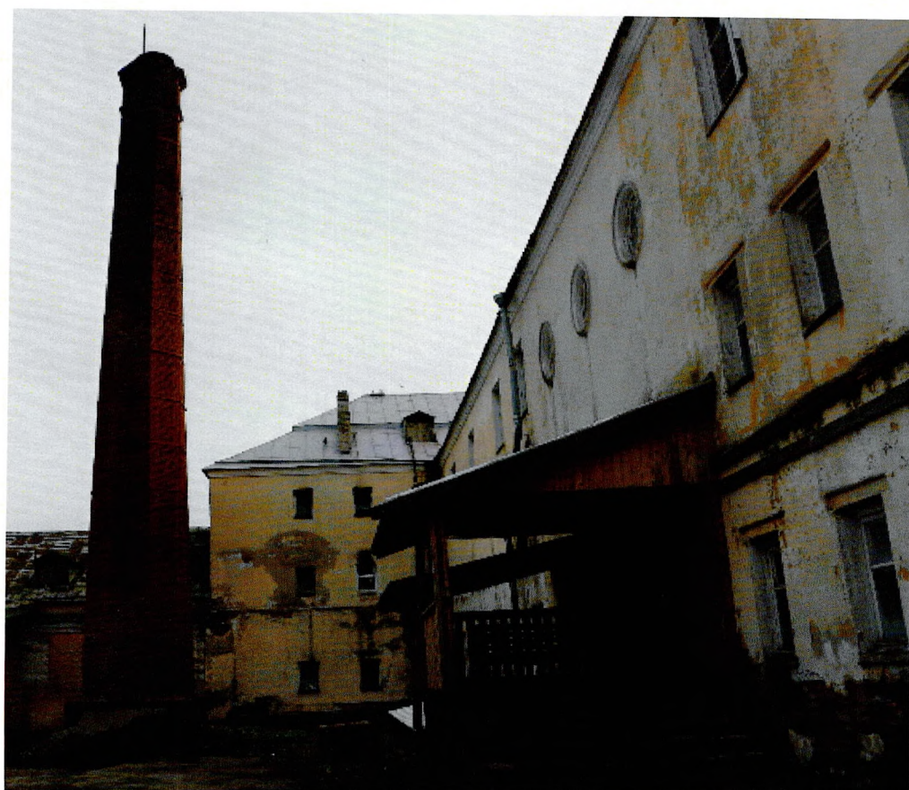
Фото 4. Внутренний двор здания. Вид на дымовую трубу в южной части двора с северо-запада.
