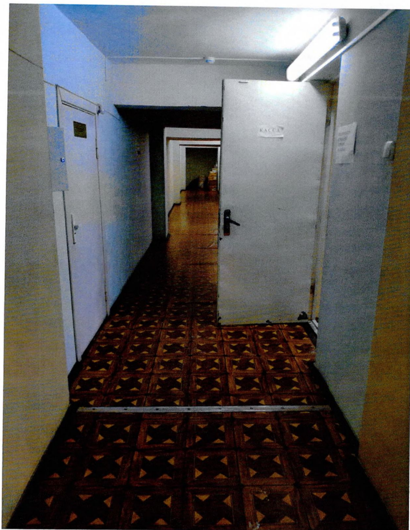
Фото 9. Интерьер, коридор первого этажа.
