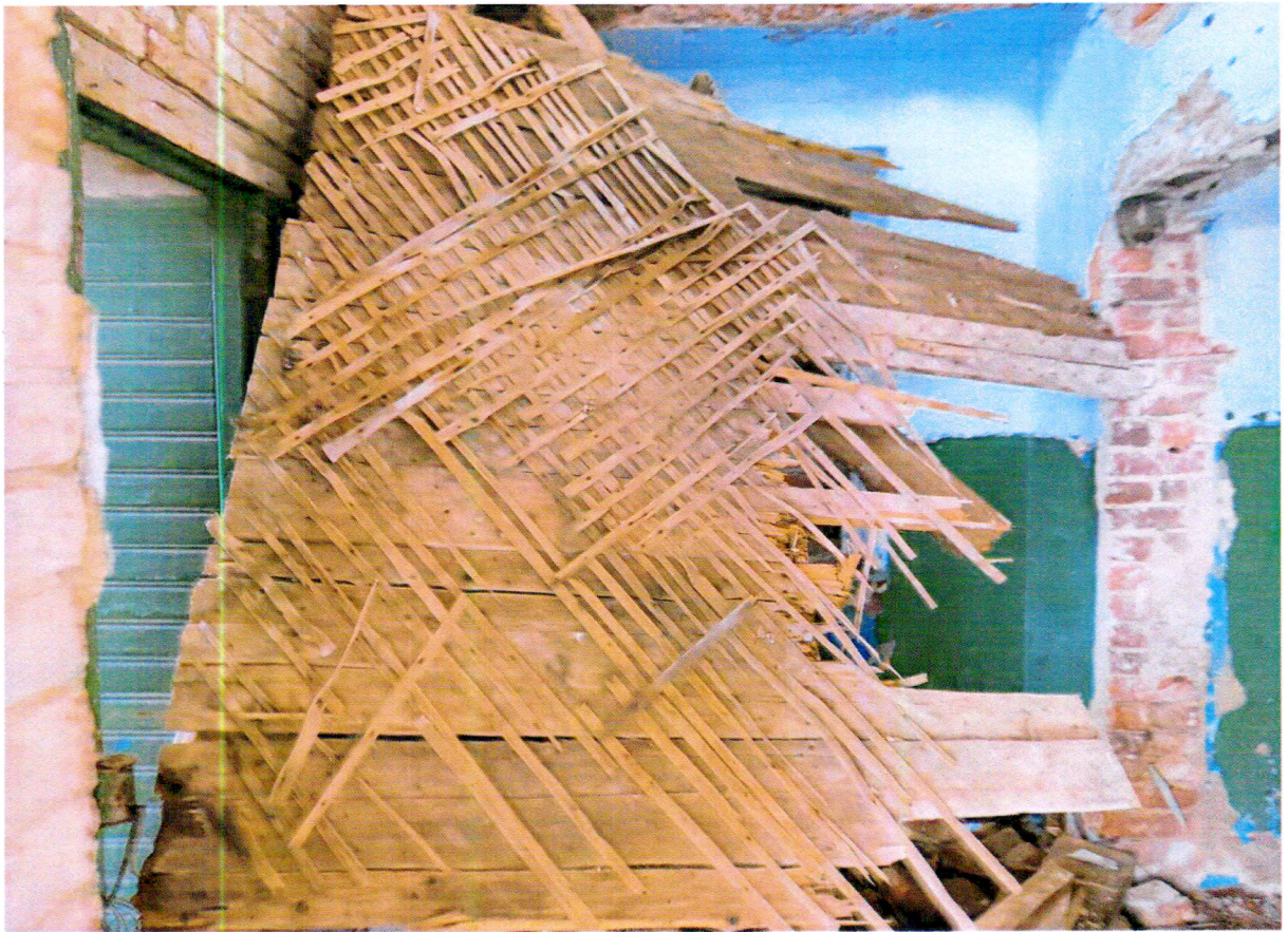
Фото 15. Внутреннее помещение. Часть обрушившегося деревянного перекрытия.
