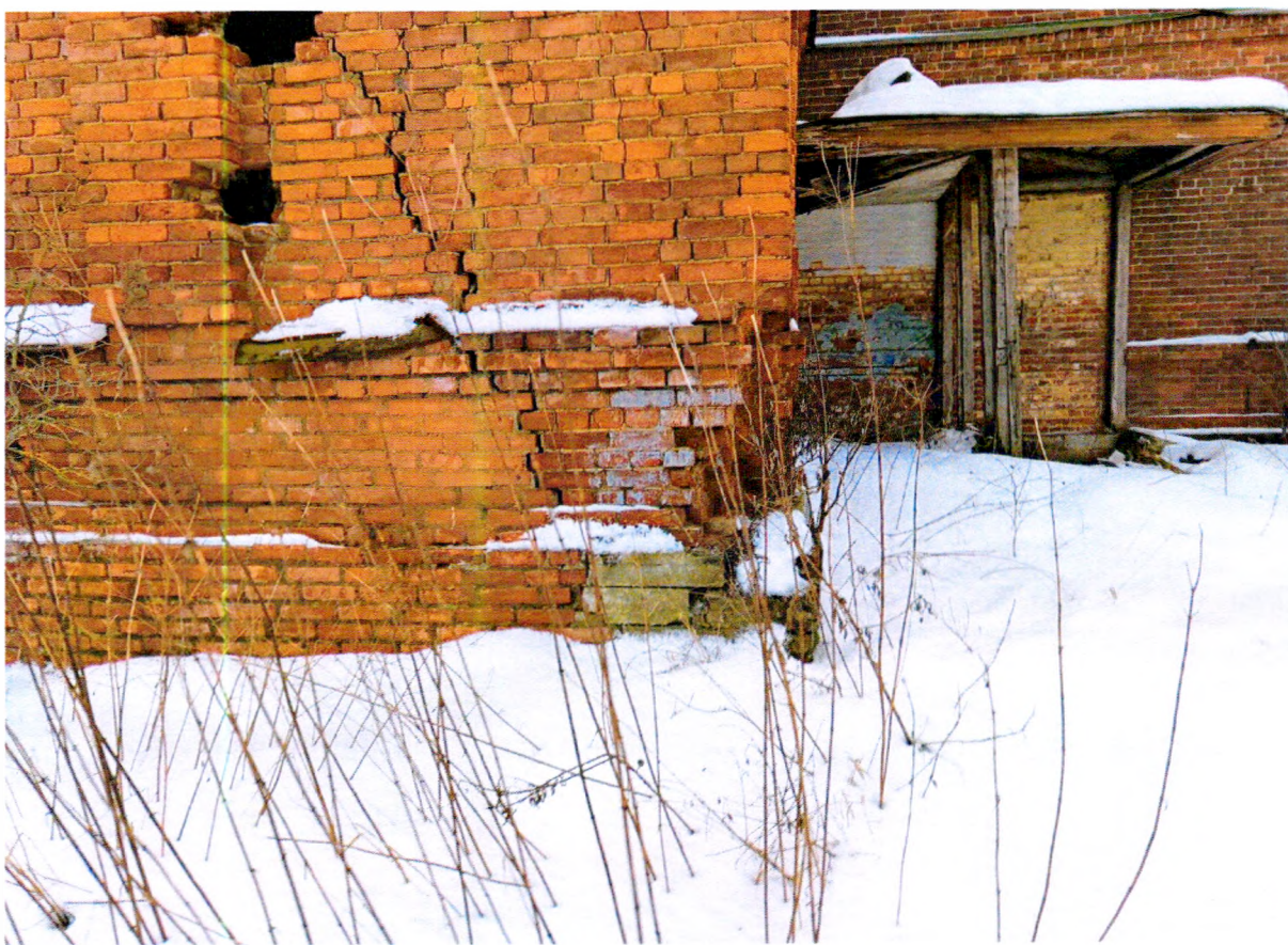
Фото 10. Фрагмент северного фасада. Сквозная наклонная трещина на наружной стене пристройки.
