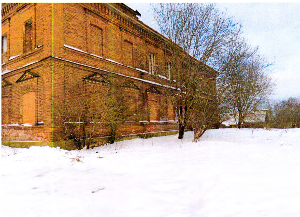
Фото 6. Восточный фасад. Прорастание деревьев и кустарников вплотную к фундаменту.
