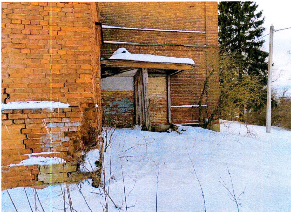
Фото 11. Фрагмент северного фасада. Утрата деревянного навеса входной группы.
