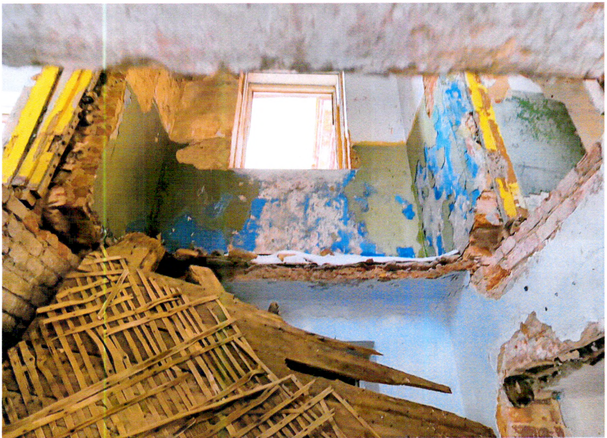
Фото 16. Внутреннее помещение. Часть обрушившегося деревянного перекрытия.
