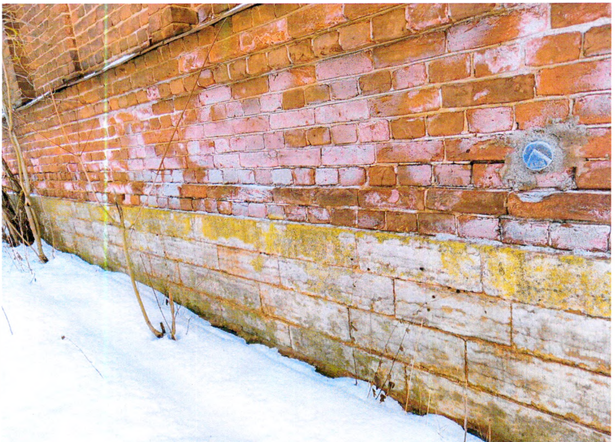
Фото 14. Фрагмент западного фасада. Биоповреждение цоколя.
