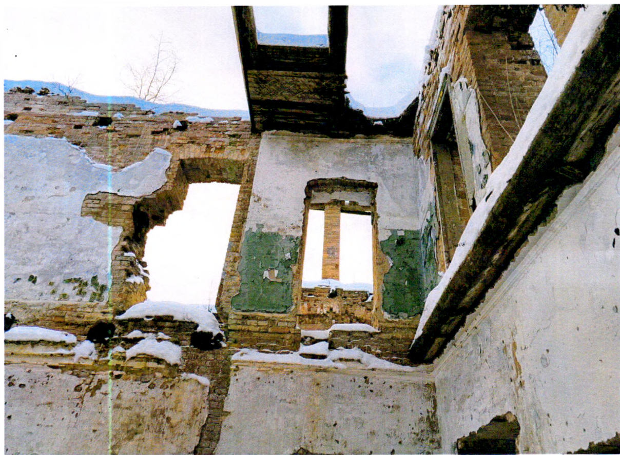
Фото 26. Внутреннее помещение. Разрушение кладки откоса оконного проема второго этажа.
