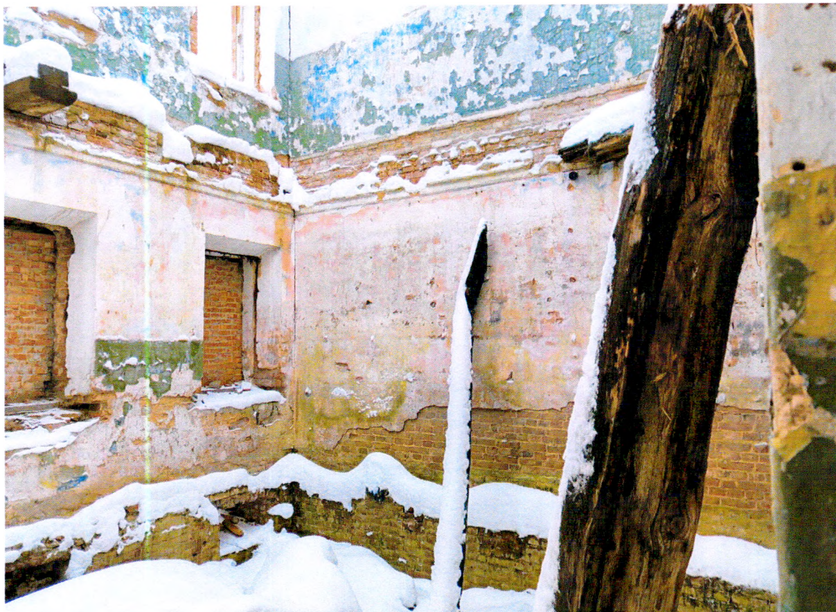
Фото 19. Внутреннее помещение. Фиксируются части деревянных несущих балок утраченного перекрытия.
