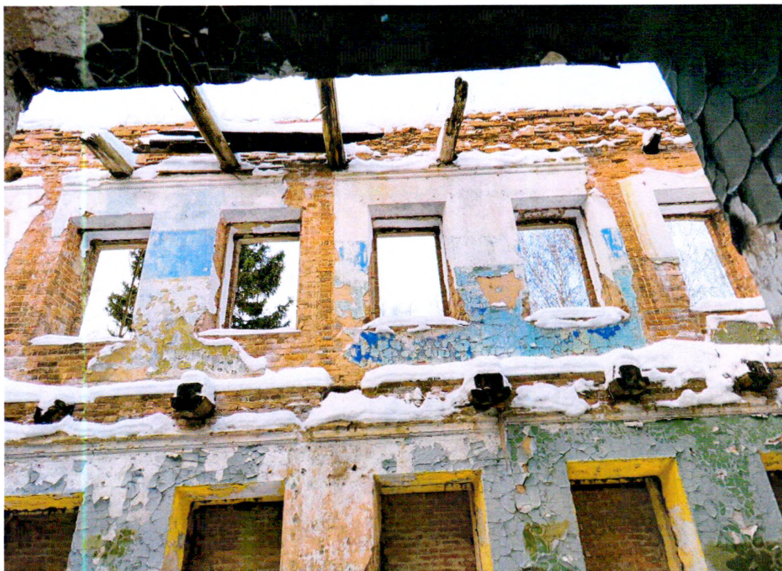
Фото 21. Внутреннее помещение. Фиксируются части деревянных несущих балок утраченного перекрытия.
