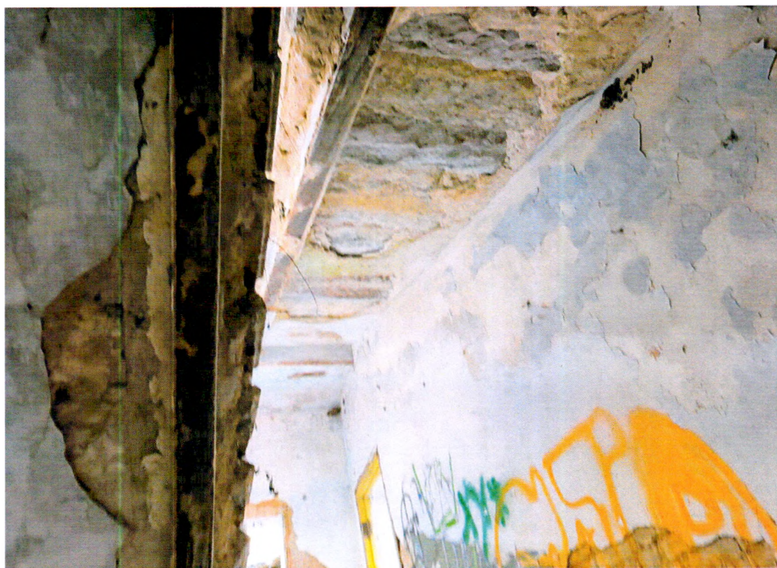
Фото 24. Коррозия металлических косоуров.
