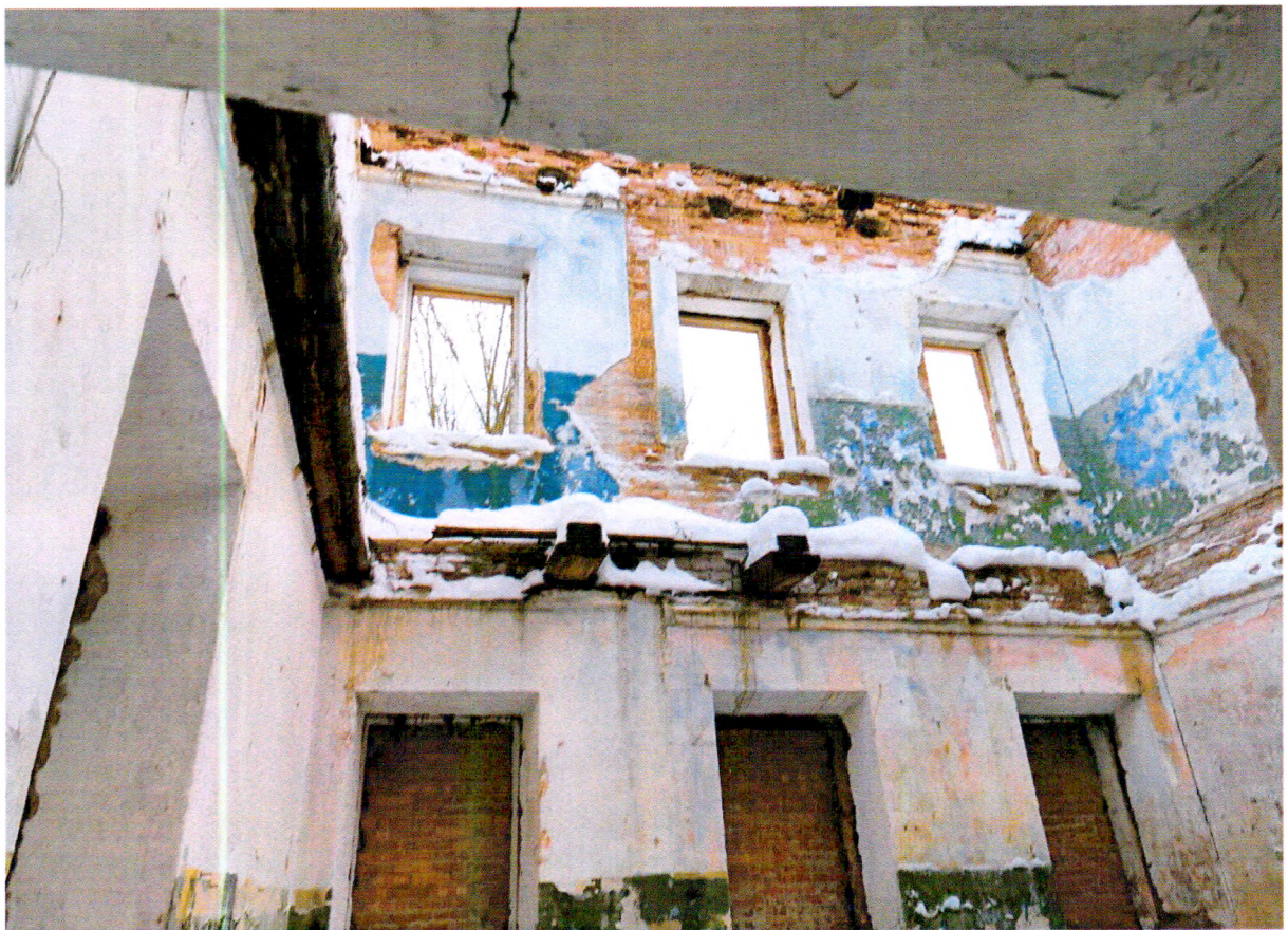
Фото 18. Внутреннее помещение. Фиксируются части деревянных несущих балок утраченного перекрытия.
