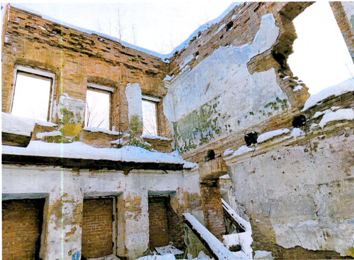
Фото 25. Внутреннее помещение. Вывалы кирпичной кладки на внутренних поверхностях стен.
