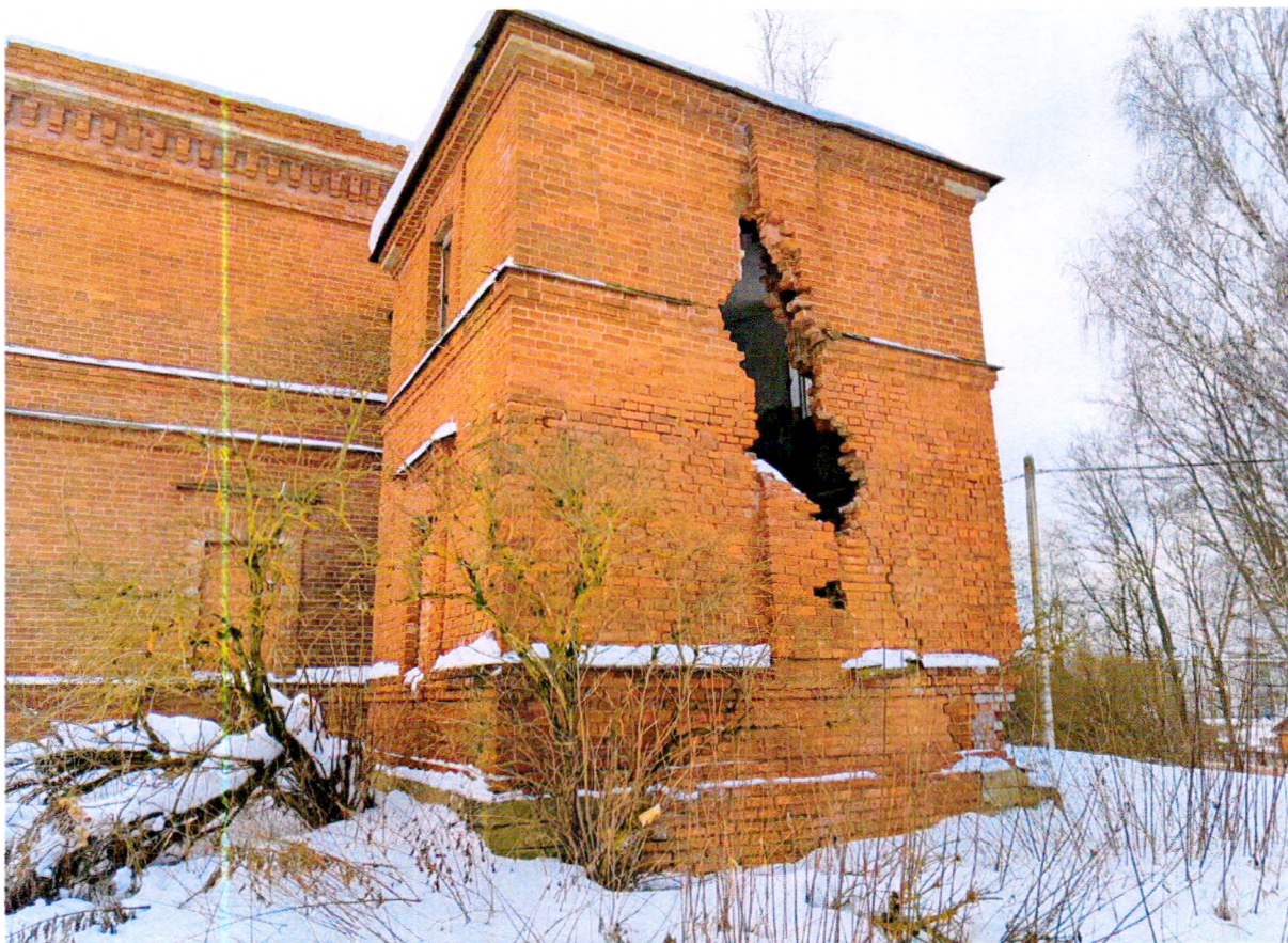
Фото 9. Фрагмент северного фасада. Разрушение кирпичной кладки наружной стены пристройки.
