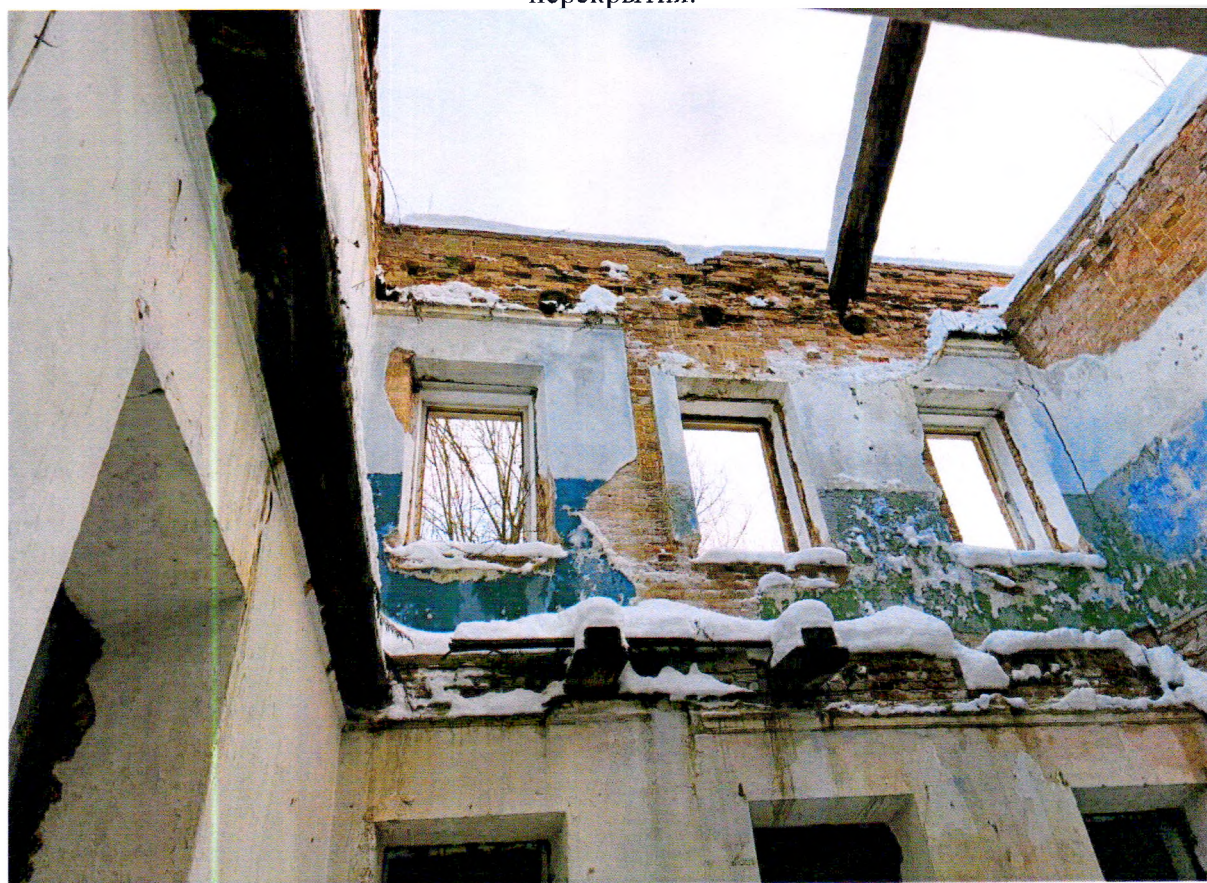
Фото 20. Внутреннее помещение. Утрата конструкций крыши.
