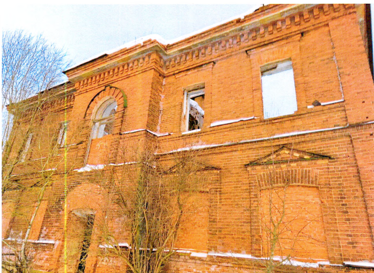
Фото 4. Фрагмент южного фасада. Утраты кирпичей венчающего карниза, оконных заполнений второго этажа. Оконные проемы первого этажа заложены керамическим кирпичом.
