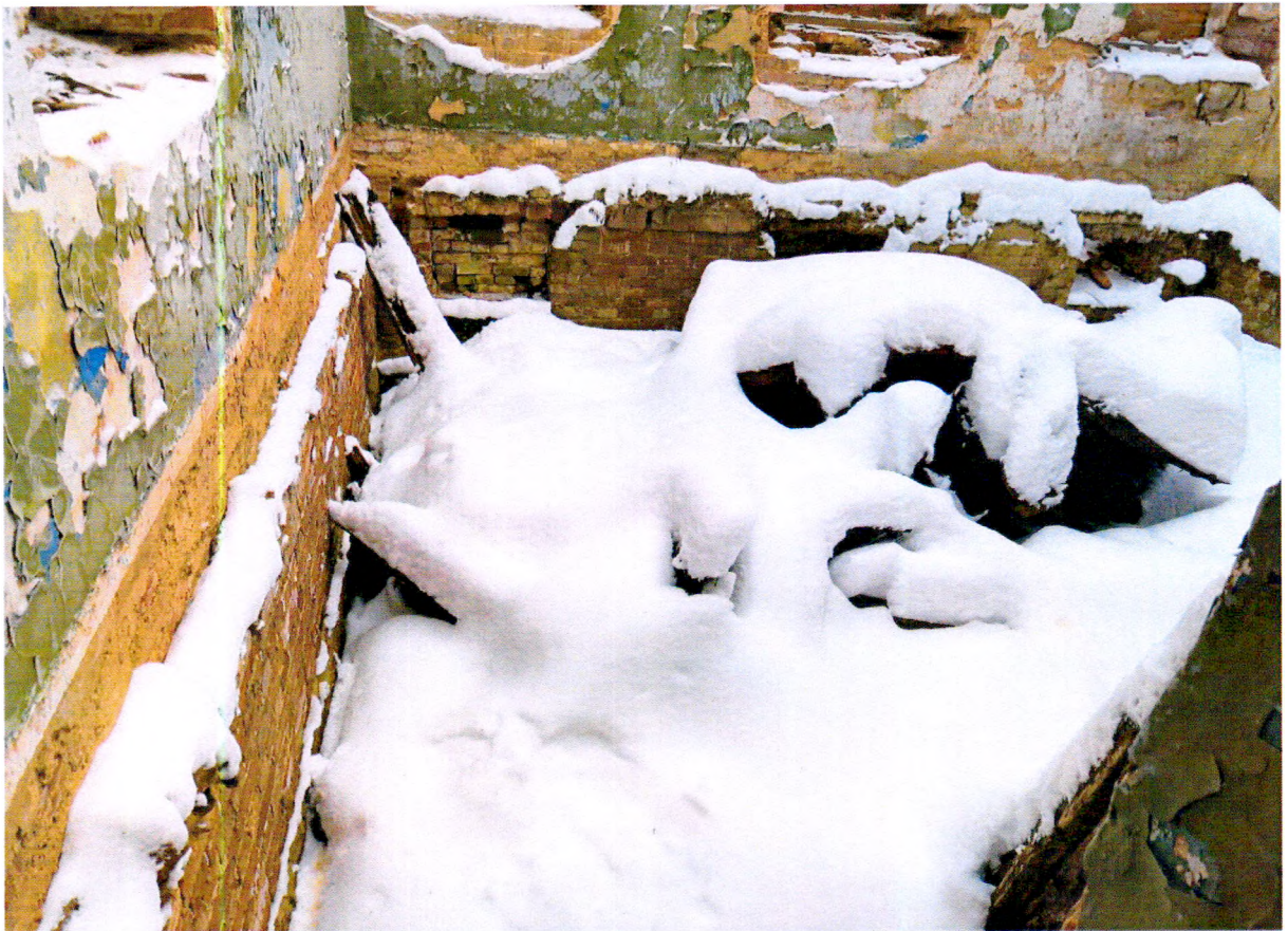
Фото 17. Внутреннее помещение. Утраты отделочного слоя и перекрытия.
