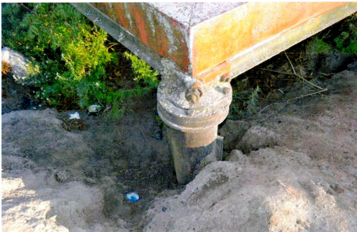
Фото 7. д. Немятово-2, ул. Морская. Двухступенчатый стилобат и крепление к опорам. Вид с юго-запада.
