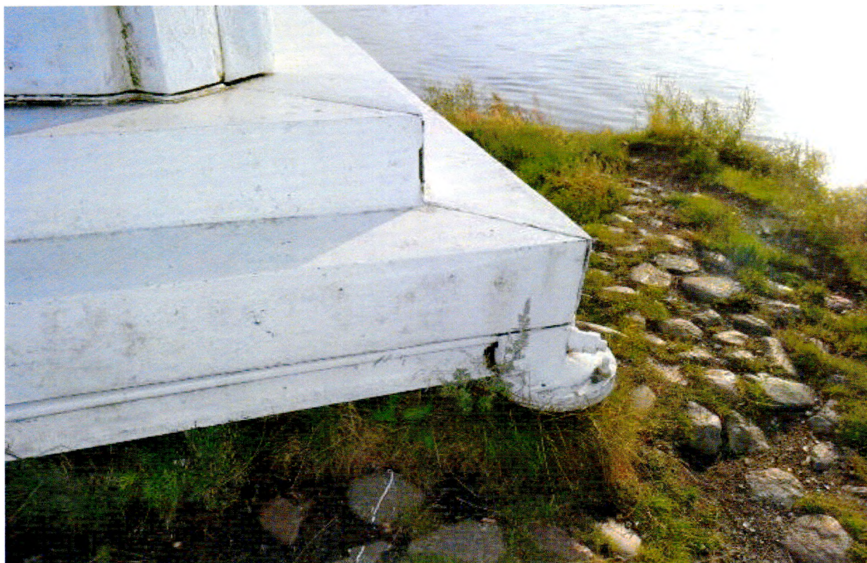
Фото 6. д. Немятово-2, ул. Речная. Двухступенчатый стилобат и крепление к опорам. Вид с юго-востока.
