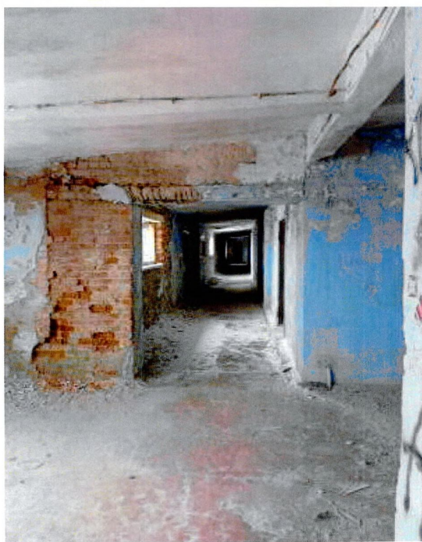
Фото 17. Галерея 2-ого этажа.
