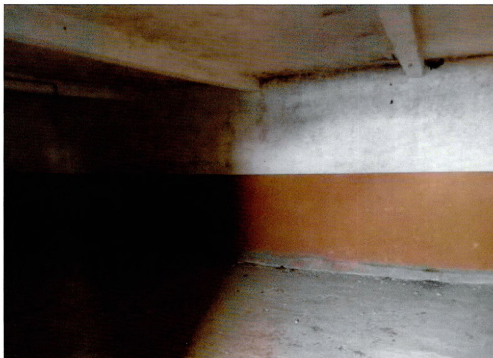
Фото 19. Помещения 2-ого этажа.
