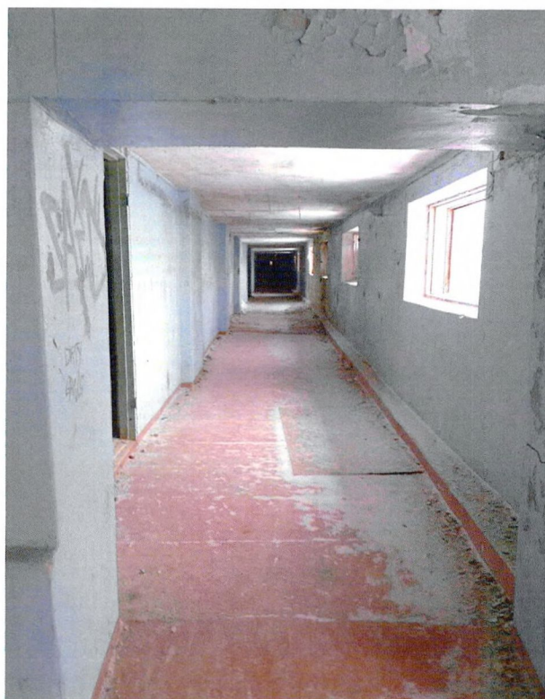
Фото 16. Галерея 2-ого этажа.
