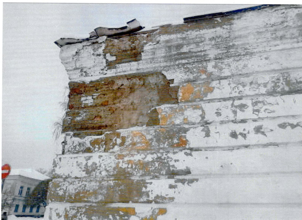
Фото 10. Обрушение фасада. Угол - пересечение набережной р. Волхов и ул. Пионерской.
