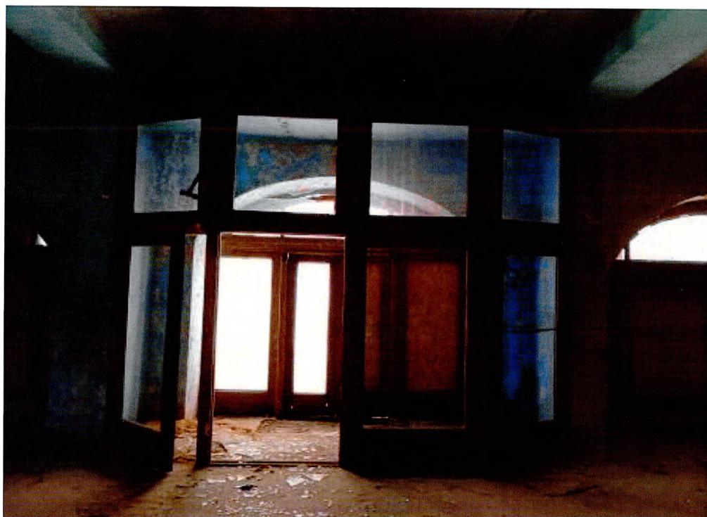
Фото 13. Дверные заполнения 1-ого этажа.
