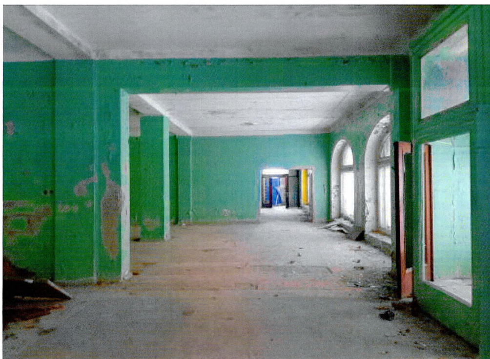
Фото 11. Галерея 1-ого этажа.
