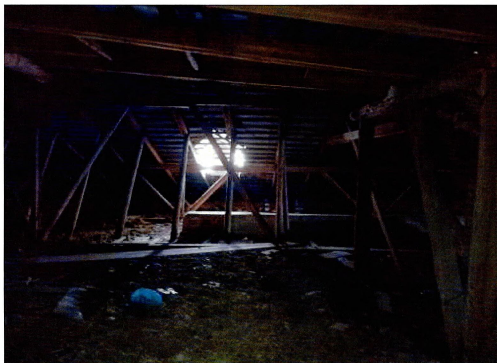
Фото 21. Чердак. Стропильная система.
