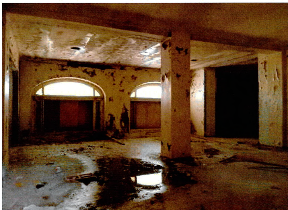
Фото 14. Помещения 1-ого этажа.
