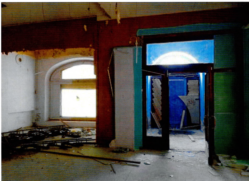
Фото 12. Оконные и дверные заполнения 1-ого этажа.
