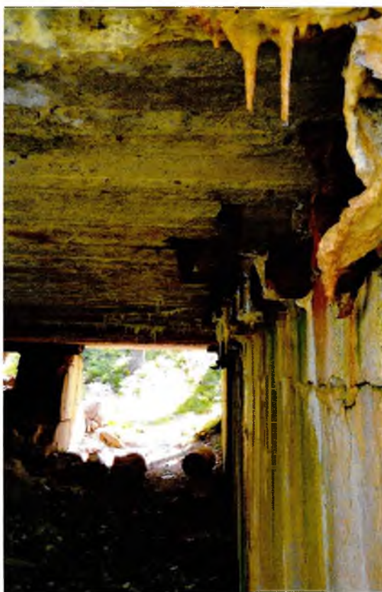
Фото 2. ОП-8. Убежище для противотанковых пушек № 12. Перекрытие с противооткольной одеждой.
