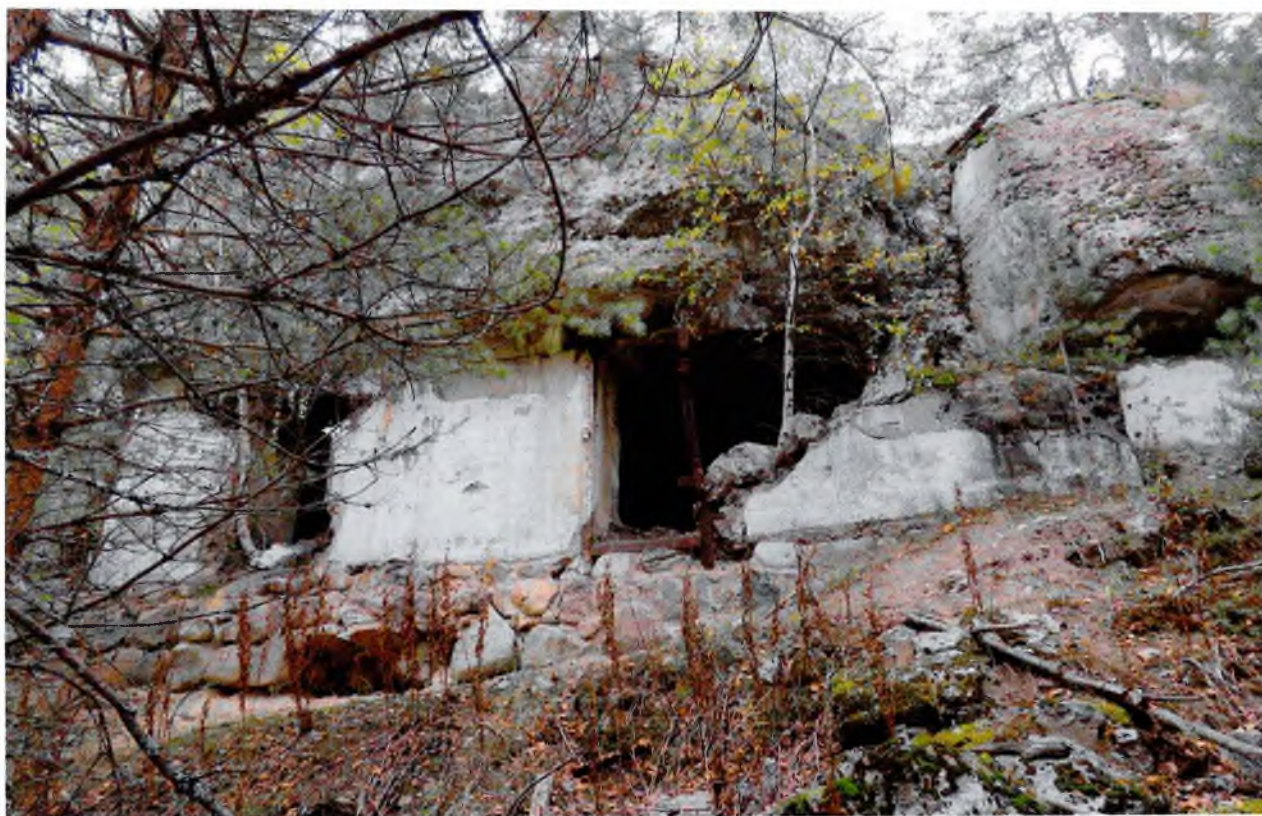
Фото 8. Батарея В на 4 6'' пушки Канэ. Раскрытые казематы после взрыва. Фото с юга.
