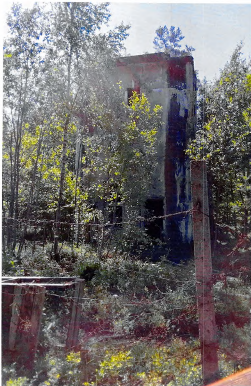
Фото 2. БКП 6. Видимая часть. Отсутствие оконных и дверных заполнений.
