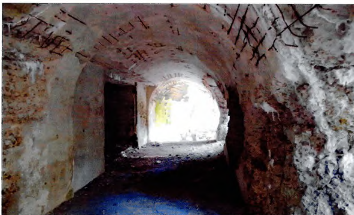
Фото 4. «Убежище для противотанковых пушек и 30 человек пехоты № 6». Внутренние помещения. Видны остатки арматуры.
