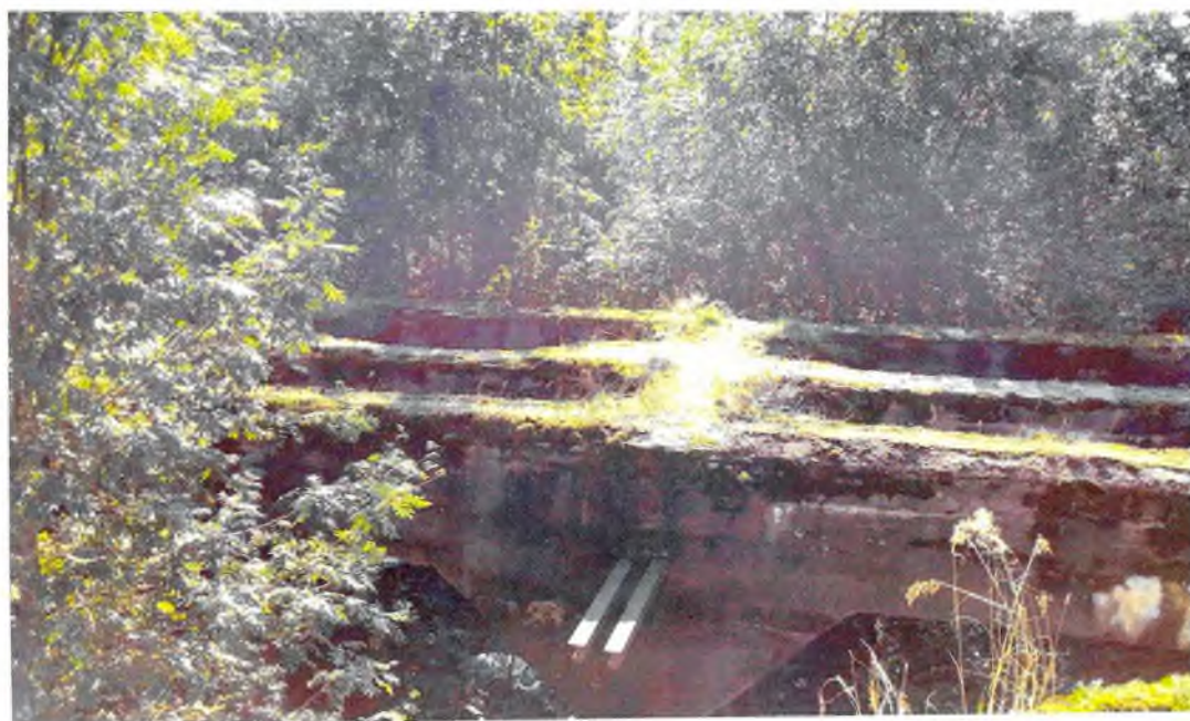
Фото 4. Башенная батарея А на 4 12'' орудия. Бетонное основание с арками для ж.-д. полотна и парового козлового крана (фрагмент). Фото с северо-запада.
