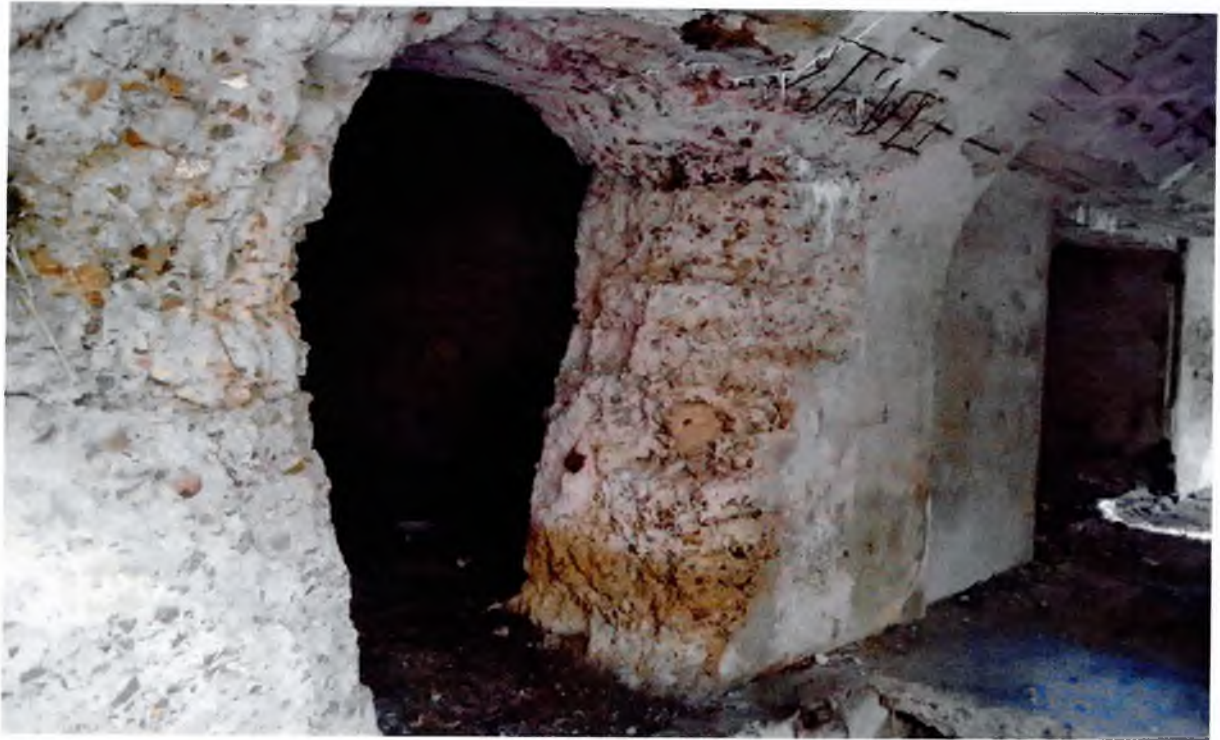
Фото 6. «Убежище для противотанковых пушек и 30 человек пехоты № 6». Внутренние помещения. Видны следы протечек и высолы в виде сталактитов.
