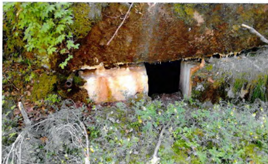
Фото 2. ОП-8. Убежище для противотанковых пушек № 12. Перекрытие с противооткольной одеждой.
