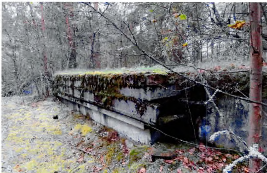
Фото 4. БКП 3. Бронебетонная крыша. Надстроенный фрагмент.
