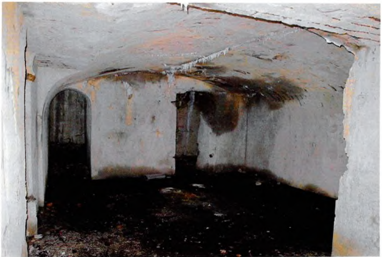
Фото 6. «Убежище для противотанковых пушек и 30 человек пехоты № 6». Внутренние помещения. Видны следы протечек и высолы в виде сталактитов.
