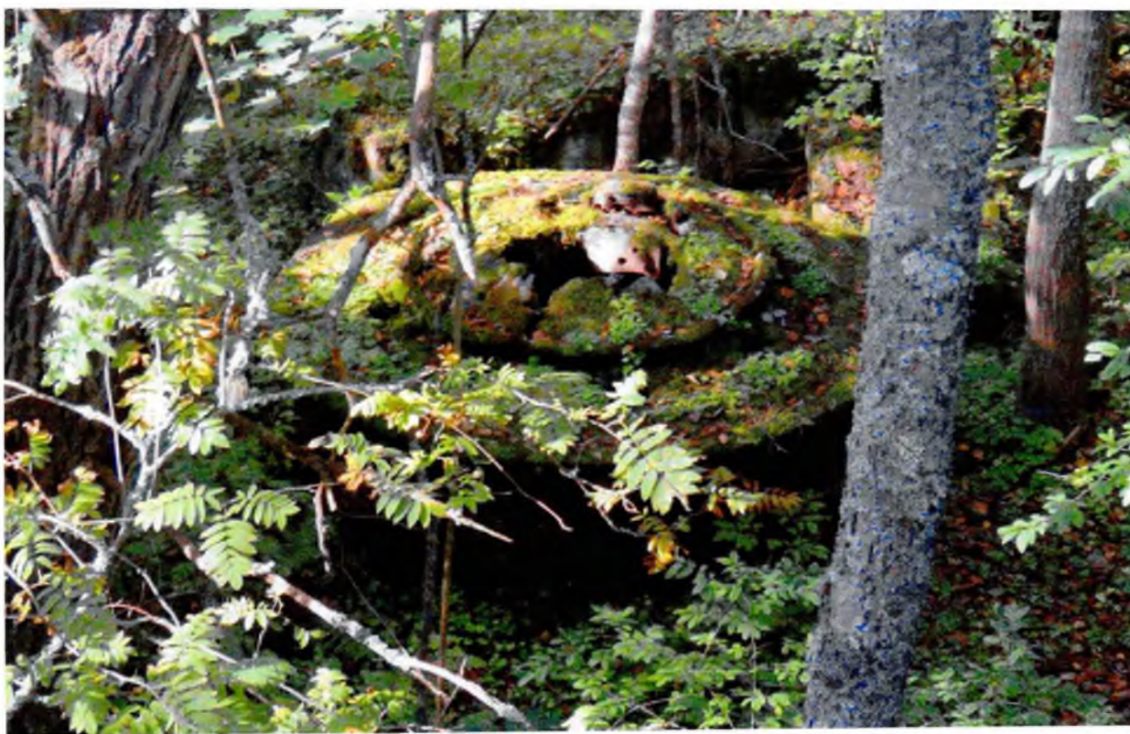
Фото 6. Открытая батарея Б на 4 12'' орудия. 3-ий орудийный дворик. Жесткий стальной барабан орудийного основания.
