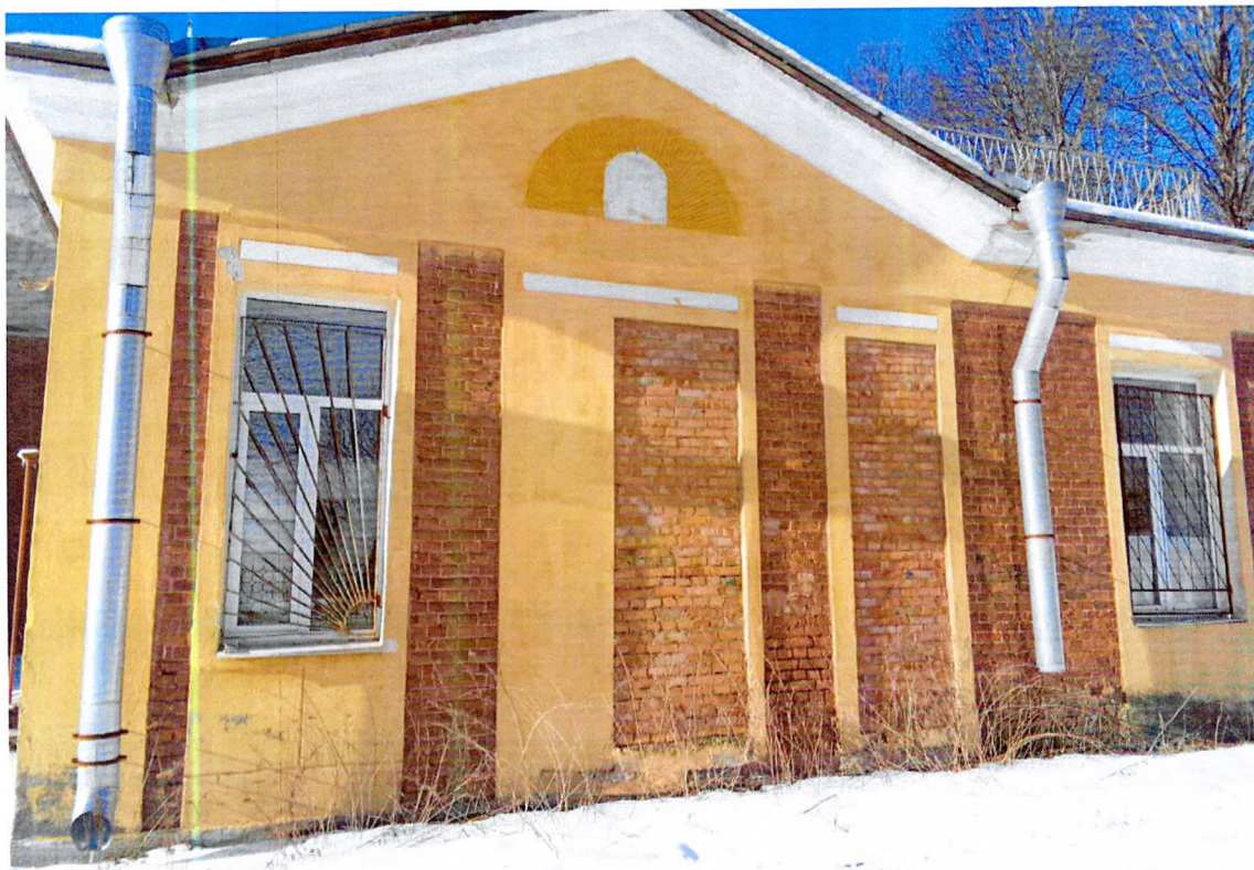
Фото 24. Восточный фасад, центральная часть.
