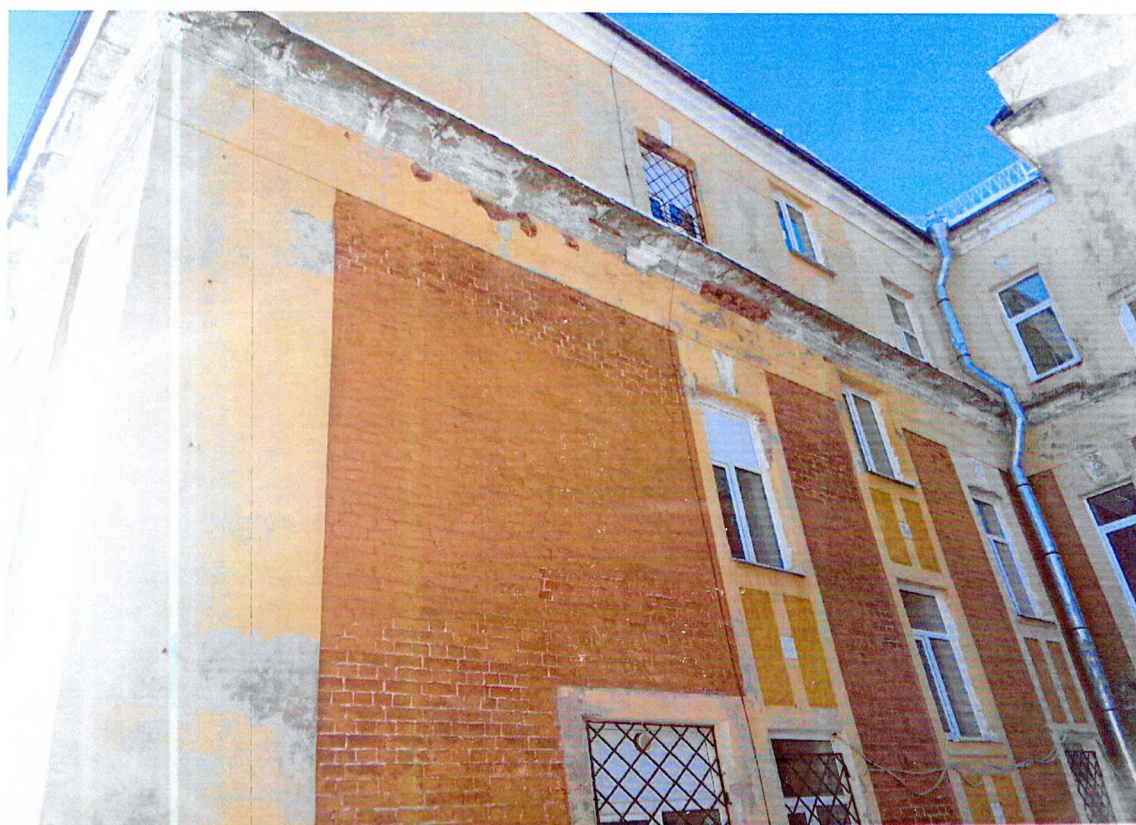
Фото 20. Восточный фасад, западная часть.
