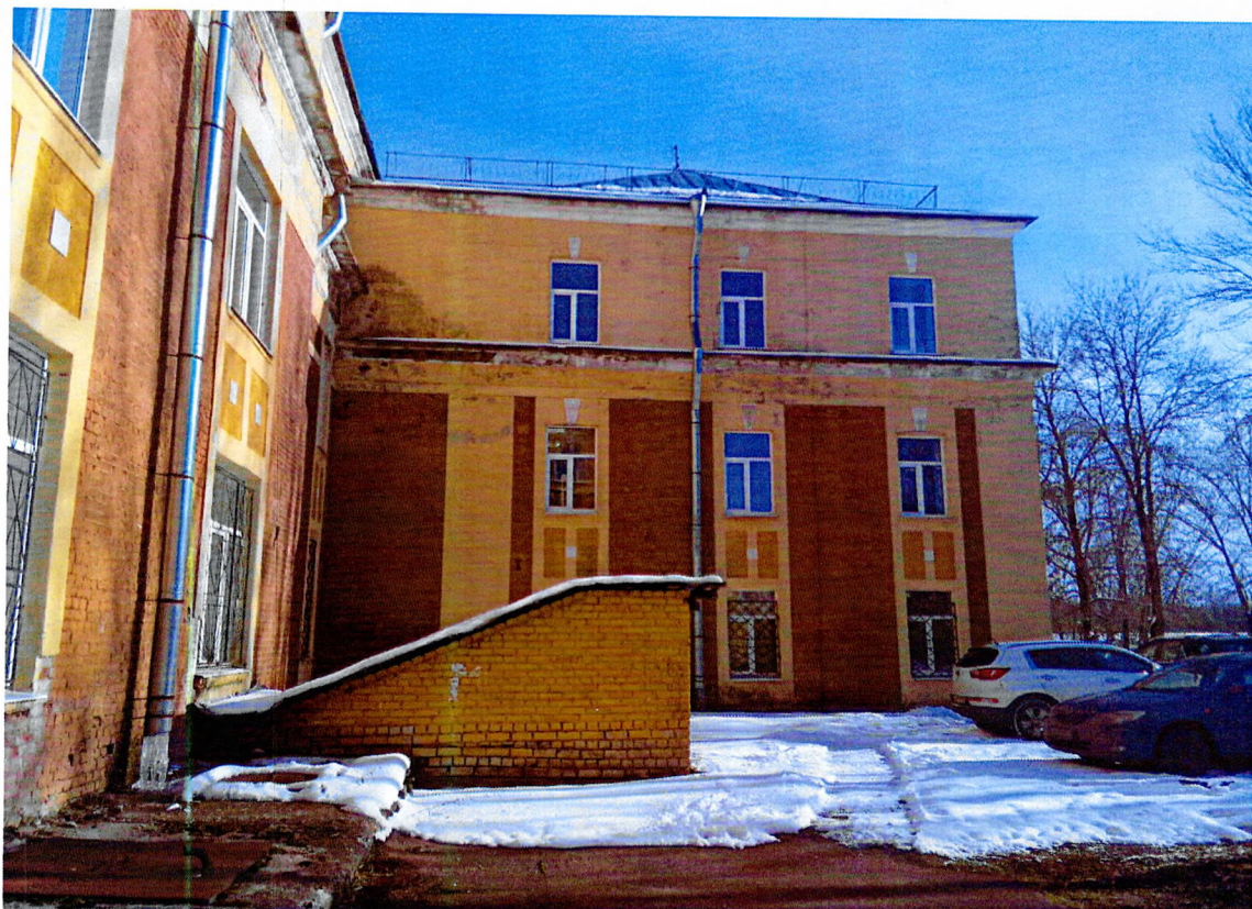
Фото 15. Юго-восточный фасад, западная часть.
