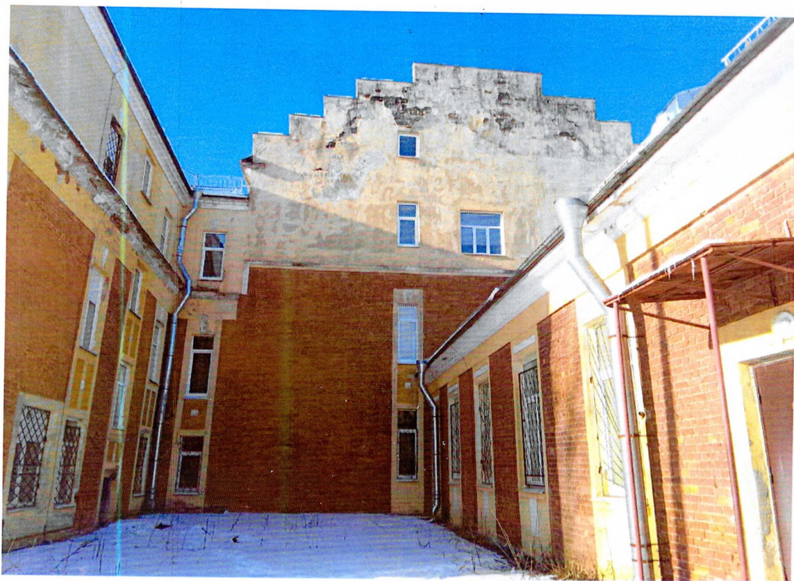
Фото 21. Восточный фасад, центральная часть.
