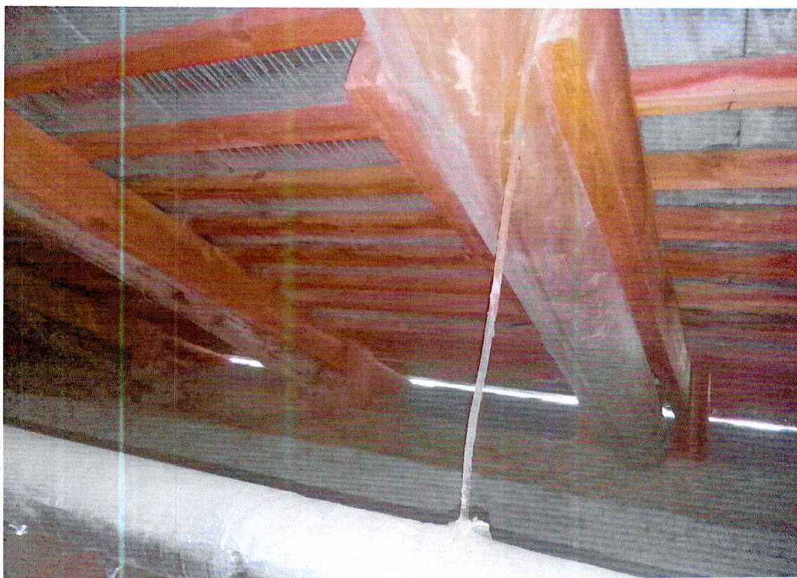
Фото 32. Стропильная система.
