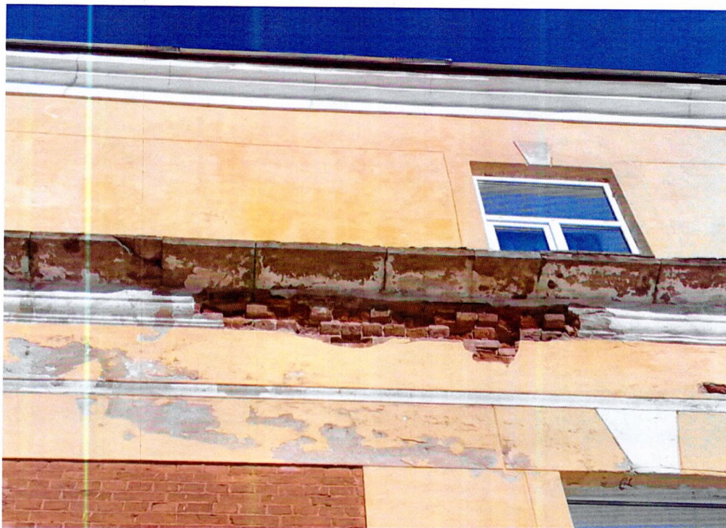
Фото 11. Фрагмент юго-западного фасада. Утрата участка штукатурных профилированных тяг, обнажение кирпичной кладки, выпадений отдельных кирпичей
