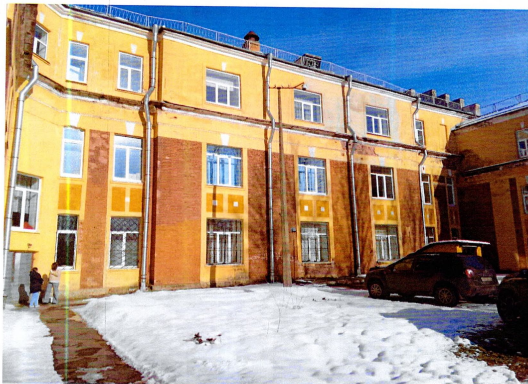
Фото 13. Южный фасад, центральная часть.
