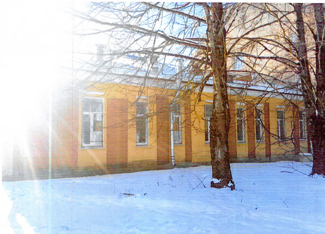
Фото 25. Северный фасад, западная часть.
