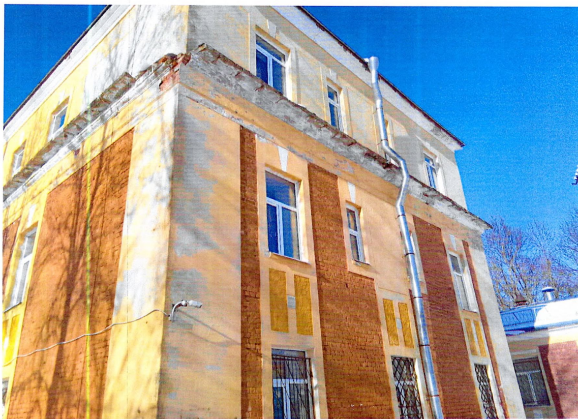
Фото 18. Юго-восточный фасад, восточная часть.
