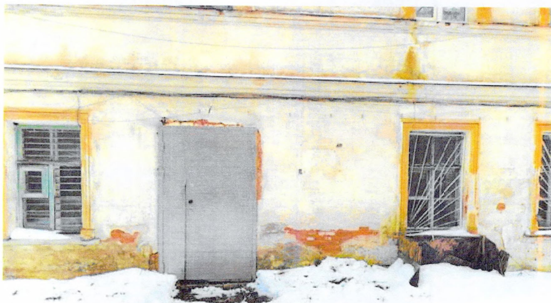
Фото 7. «Бывший дом Марфина, впоследствии богадельня, сер. XIX в.», отслоение штукатурного слоя от карнизов здания.
