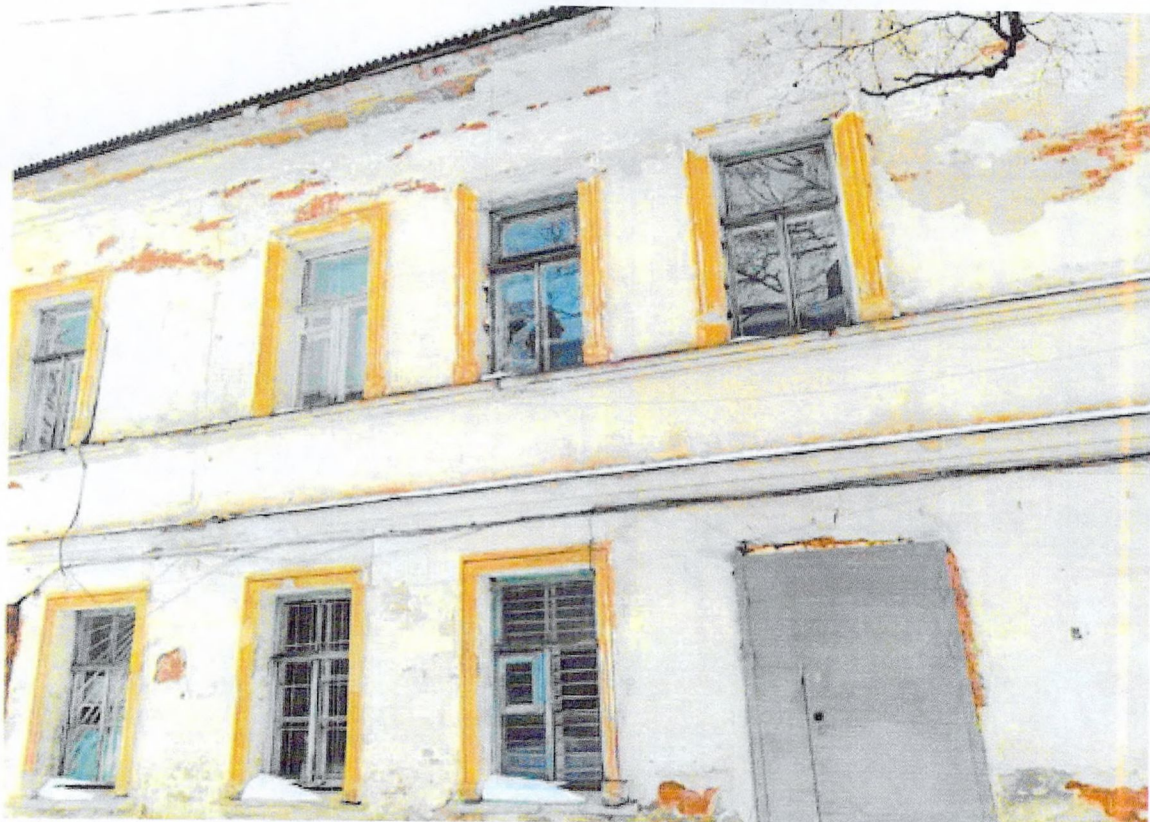
Фото 7. «Бывший дом Марфина, впоследствии богадельня, сер. XIX в.», отслоение штукатурного слоя от карнизов здания.
