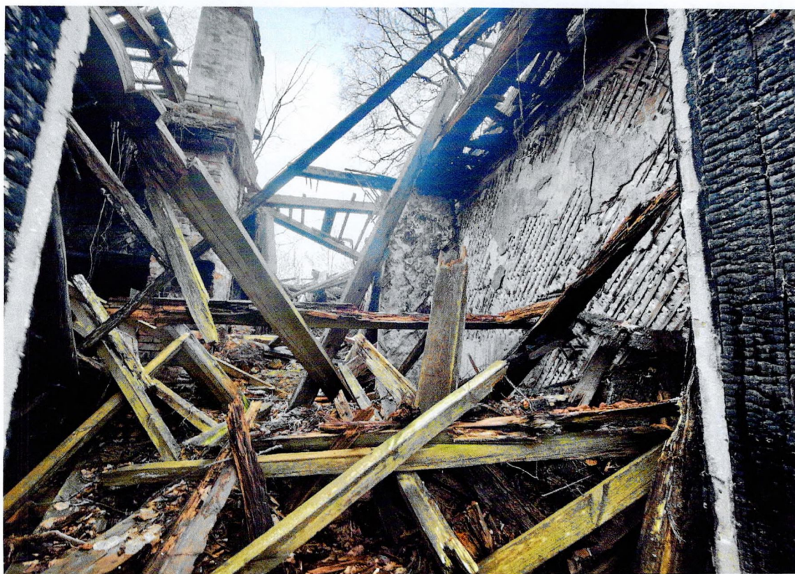
Фото 4. Фрагмент северного фасада. Сохранились кирпичные дымоходы, фрагменты деревянных перегородок обшитые дранкой и фрагменты деревянных балок чердачного перекрытия.
