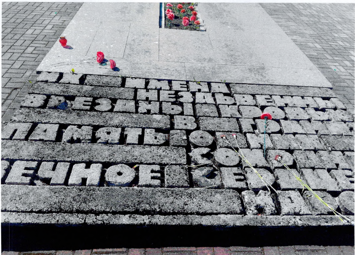
Фото 8. Могильный холм. Надпись из бетона. Прорастание растений.
