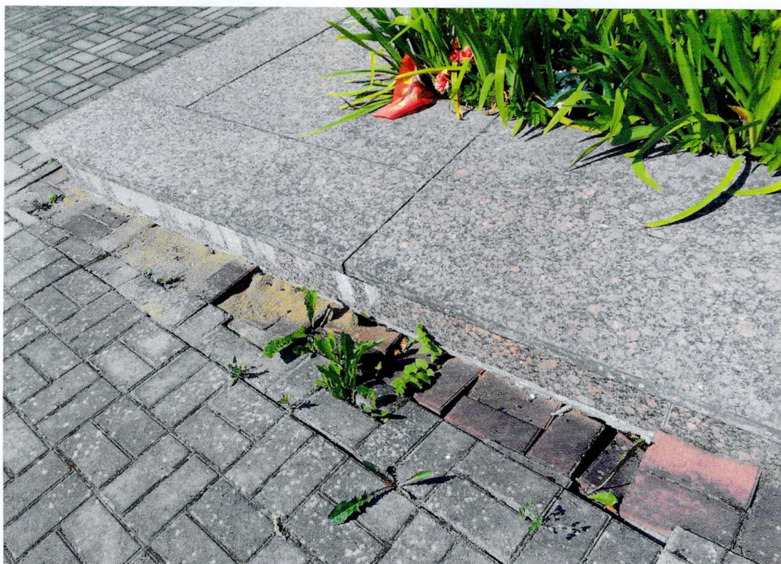
Фото 14. Стела, расположенная справа от скульптуры партизана. Просадки отместки.
