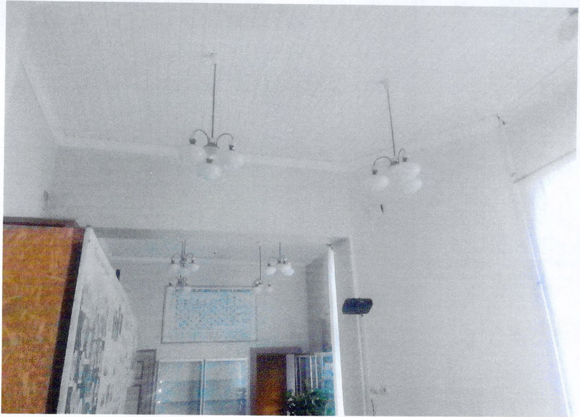
Фото 35. Третий этаж. Подшивной потолок.
