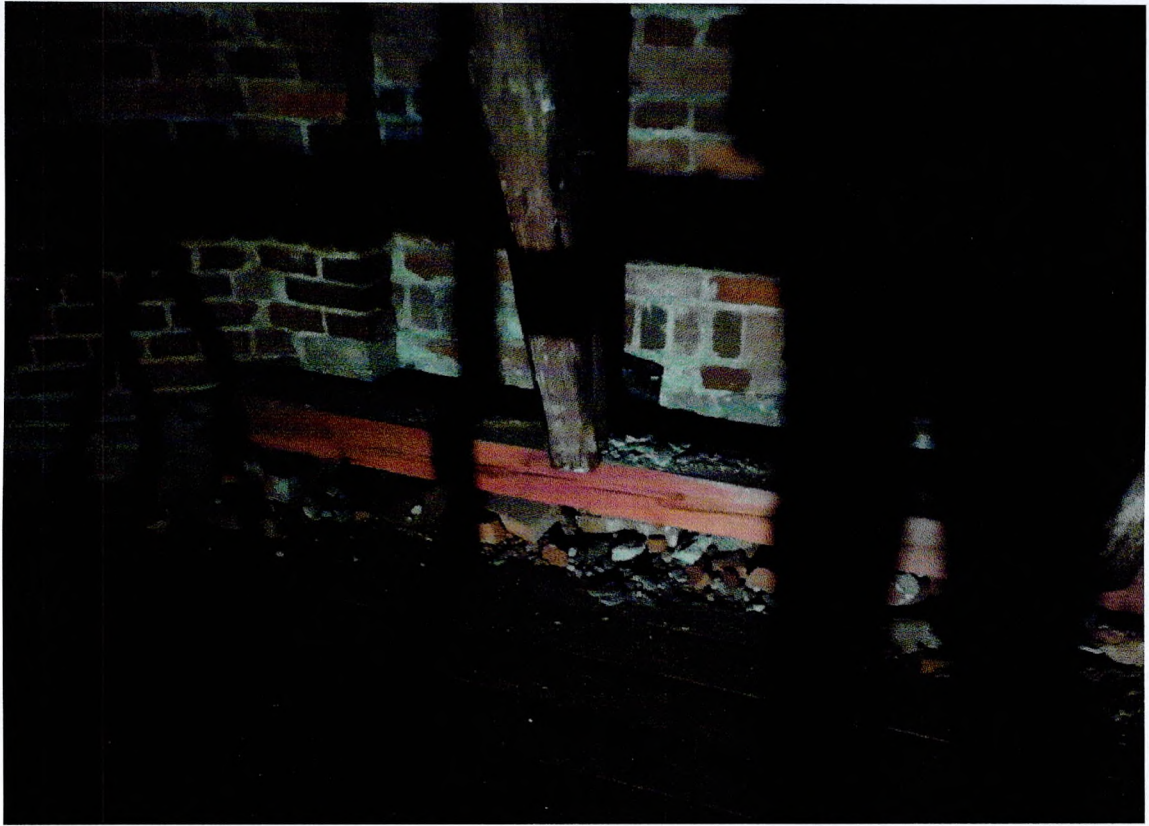
Фото 39. Чердак. Разрушение кирпичной кладки в месте опирания стропильной системы.
