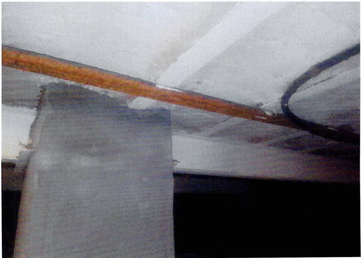
Фото 20. Подвал. Обетонированная колонна.
