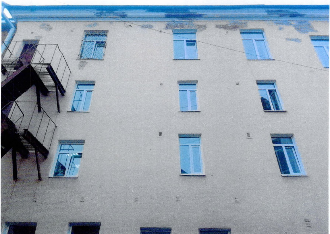
Фото 16. Фрагмент дворового фасада. Фрагментарно демонтирован отделочный слой поверхности стен.
