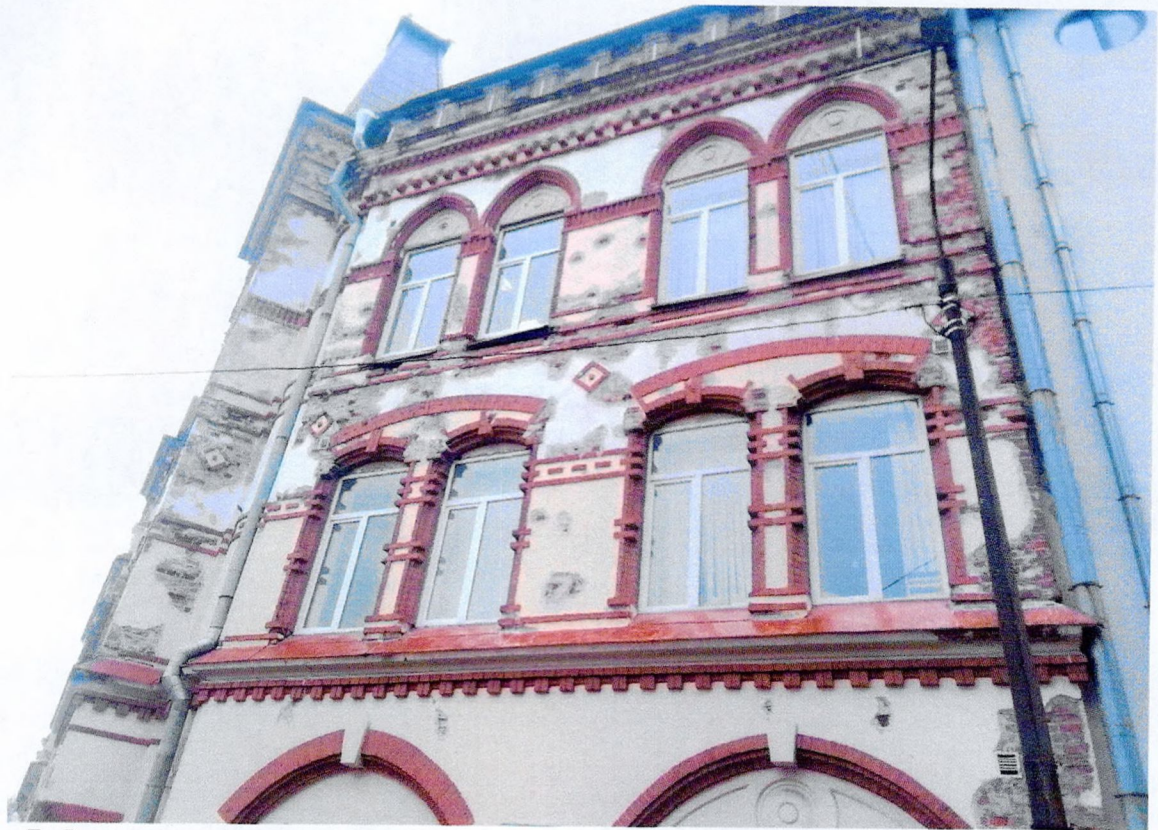
Фото 7. Фрагмент южного уличного фасада. Фрагментарно демонтирован отделочный слой поверхности стен.
