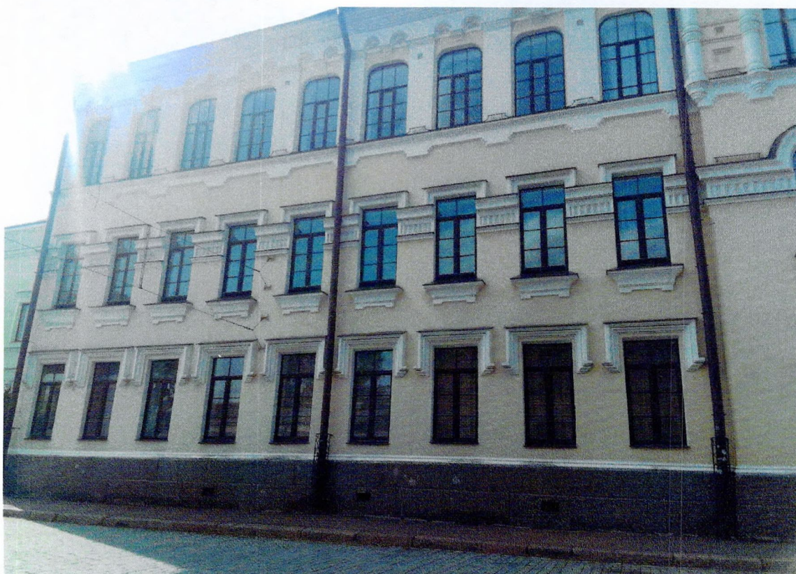
Фото 10. Фрагмент северо-восточного фасада.
