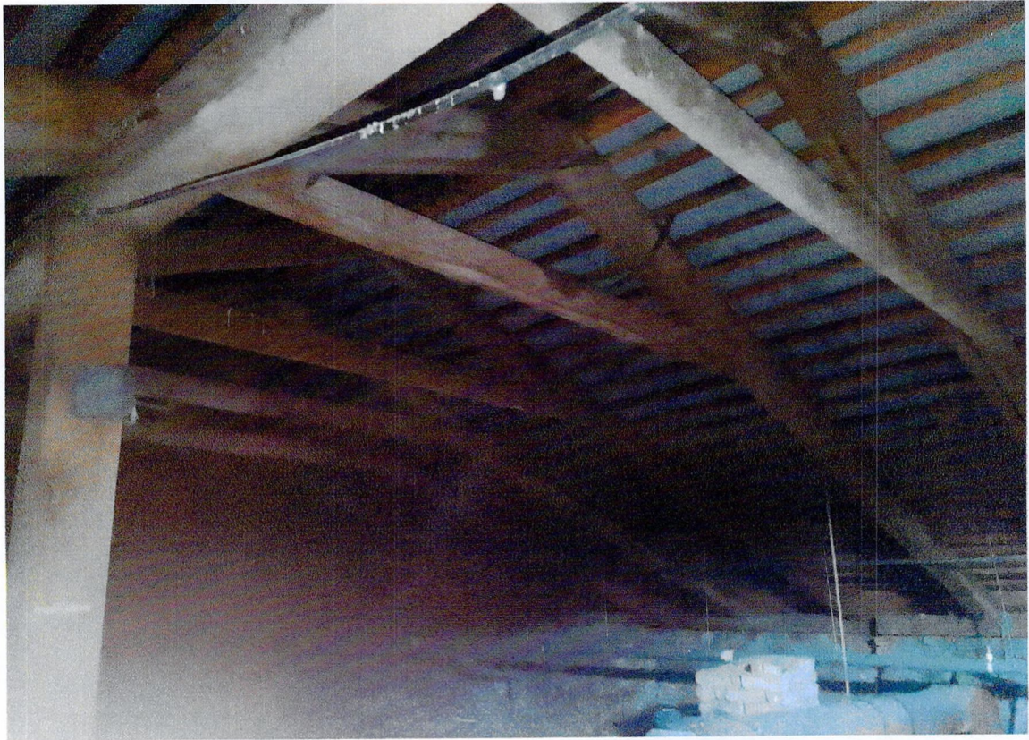
Фото 39. Общий вид стропильной системы.
