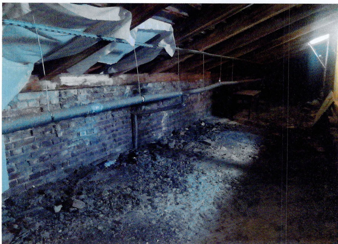
Фото 36. Чердак. Подвеска магистрали теплоснабжения к стропильным конструкциям.
