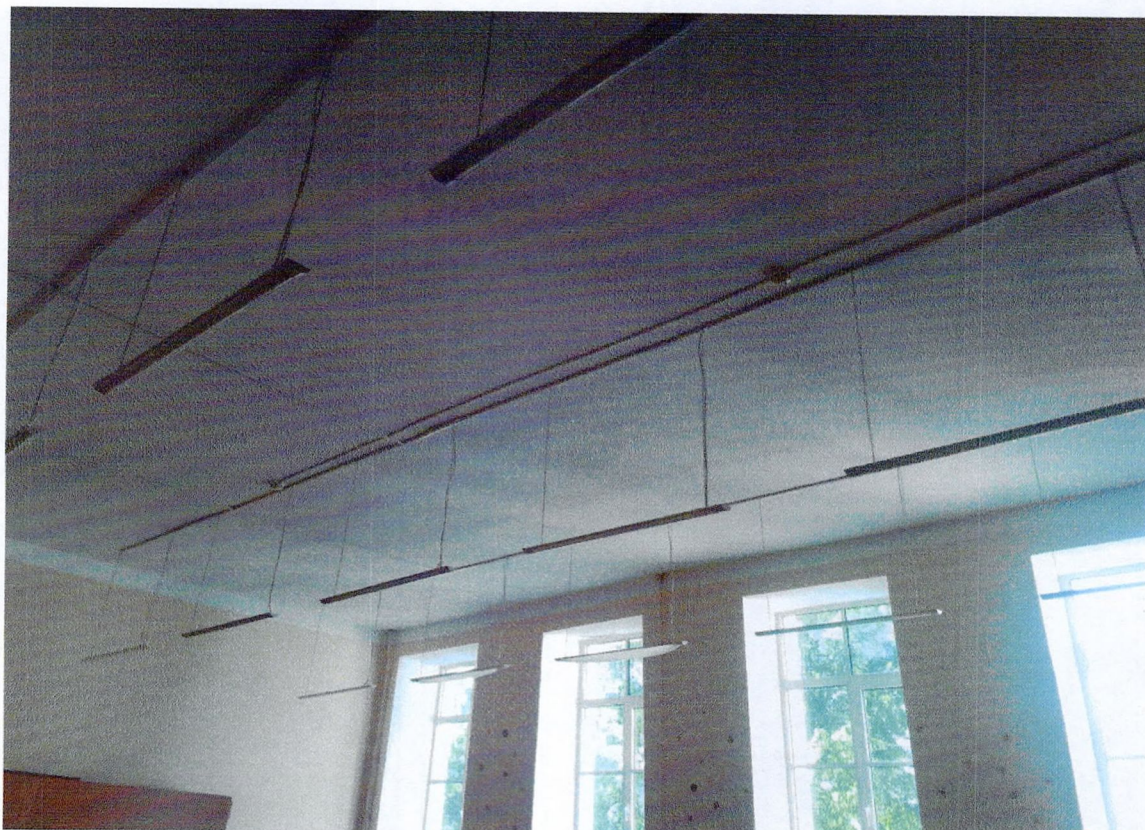
Фото 33. Внутренние помещения. Плоское перекрытие.
