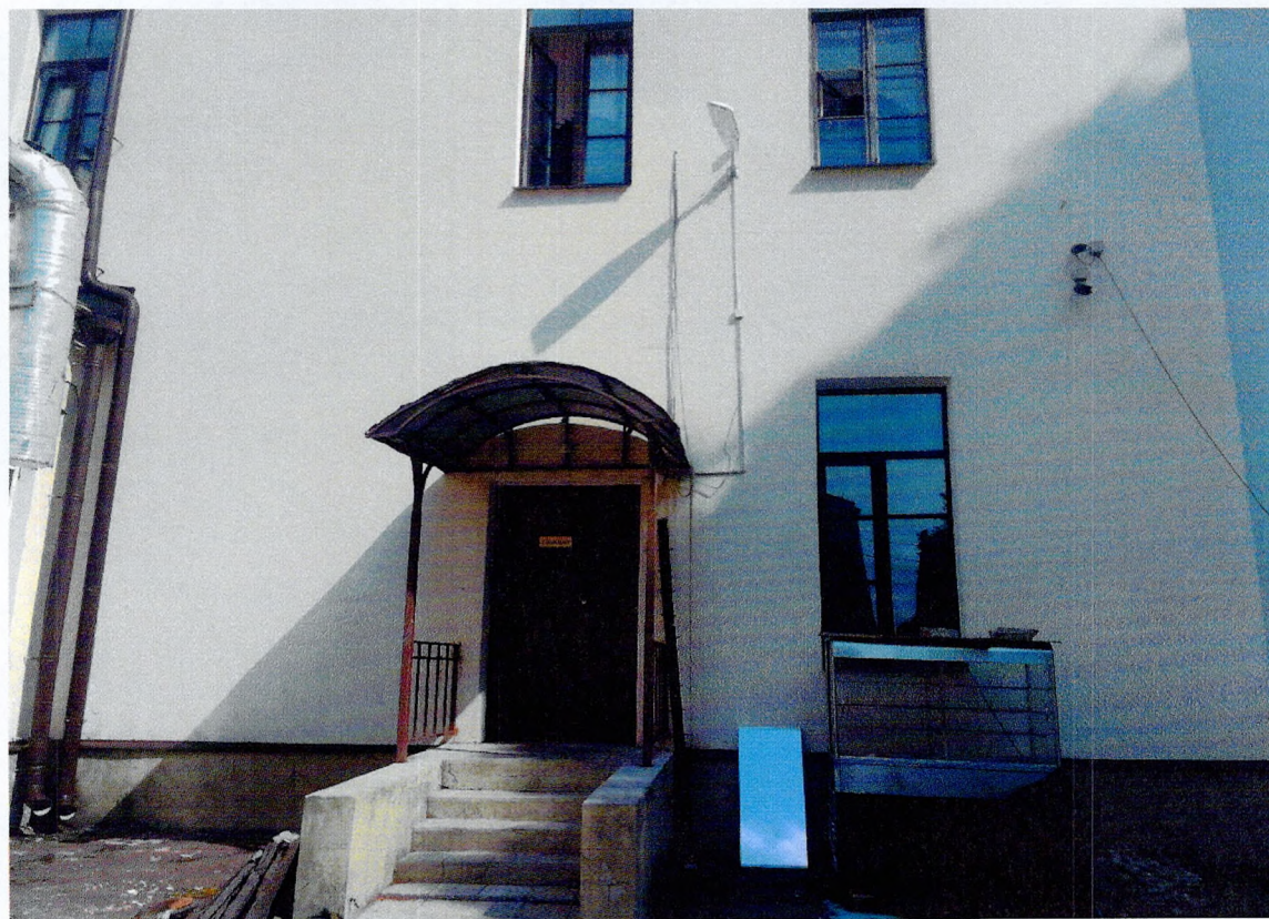
Фото 13. Фрагмент юго-западного дворового фасада восточного крыла.
