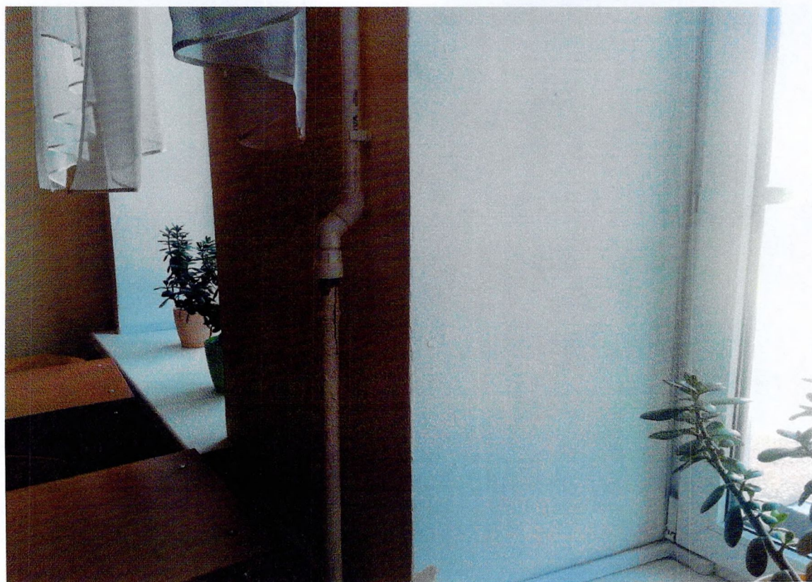
Фото 32. Внутренние помещения. Замена мест трубопроводов отопления отдельными местами.
