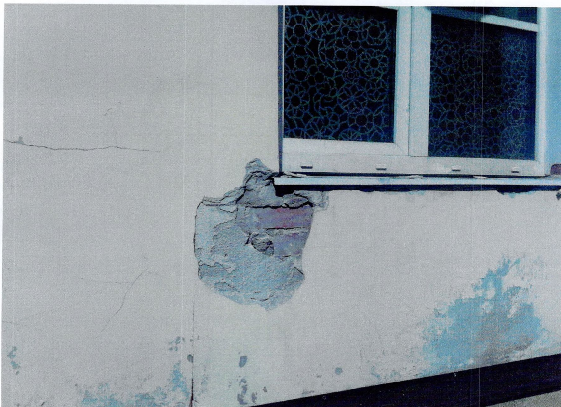
Фото 15. Фрагмент юго-западного дворового фасада. Обнажение кирпичной кладки.
