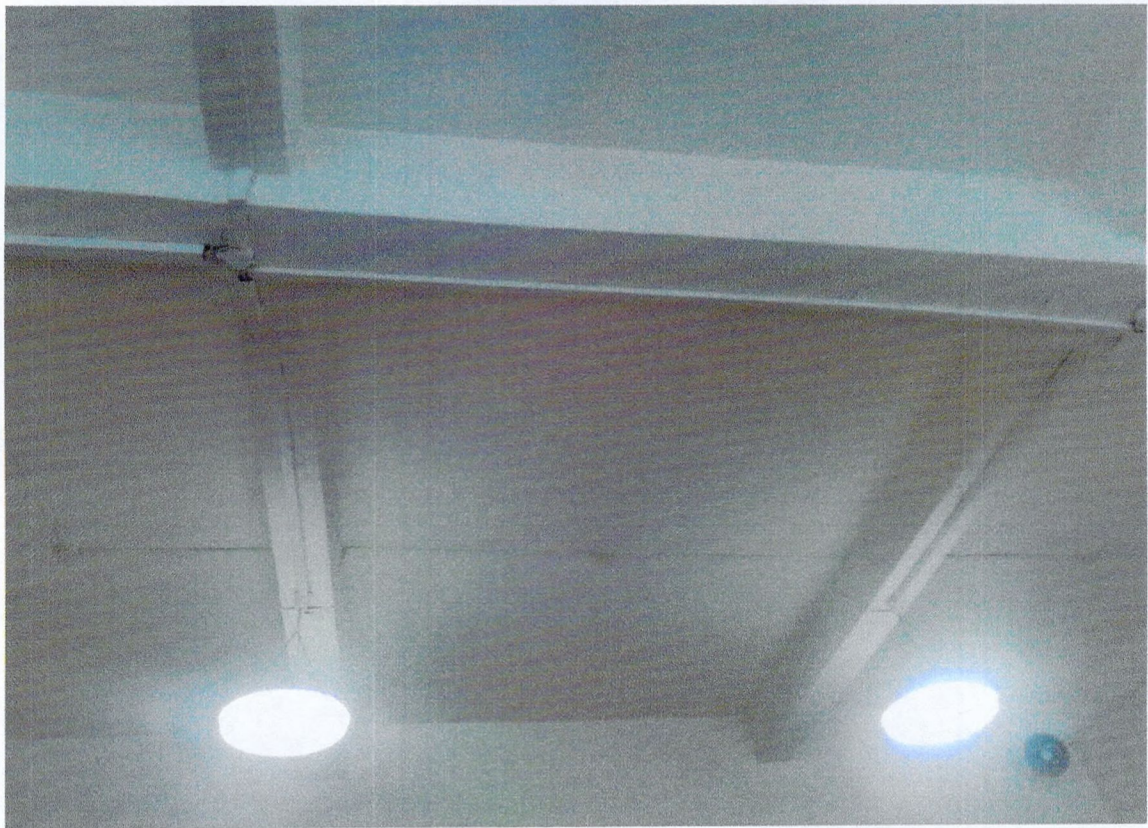
Фото 23. Внутренние помещения. Балочное перекрытие.
