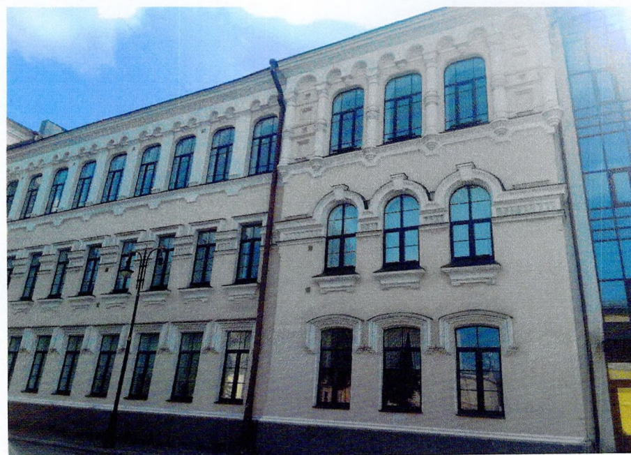
Фото 2. Фрагмент северо-западного фасада.
