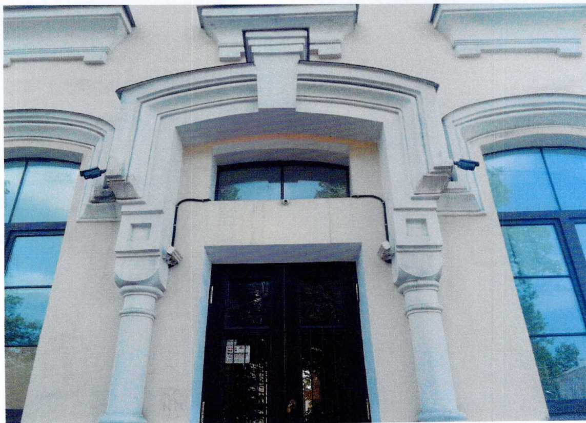
Фото 8. Фрагмент северо-западного фасада. Главный вход.
