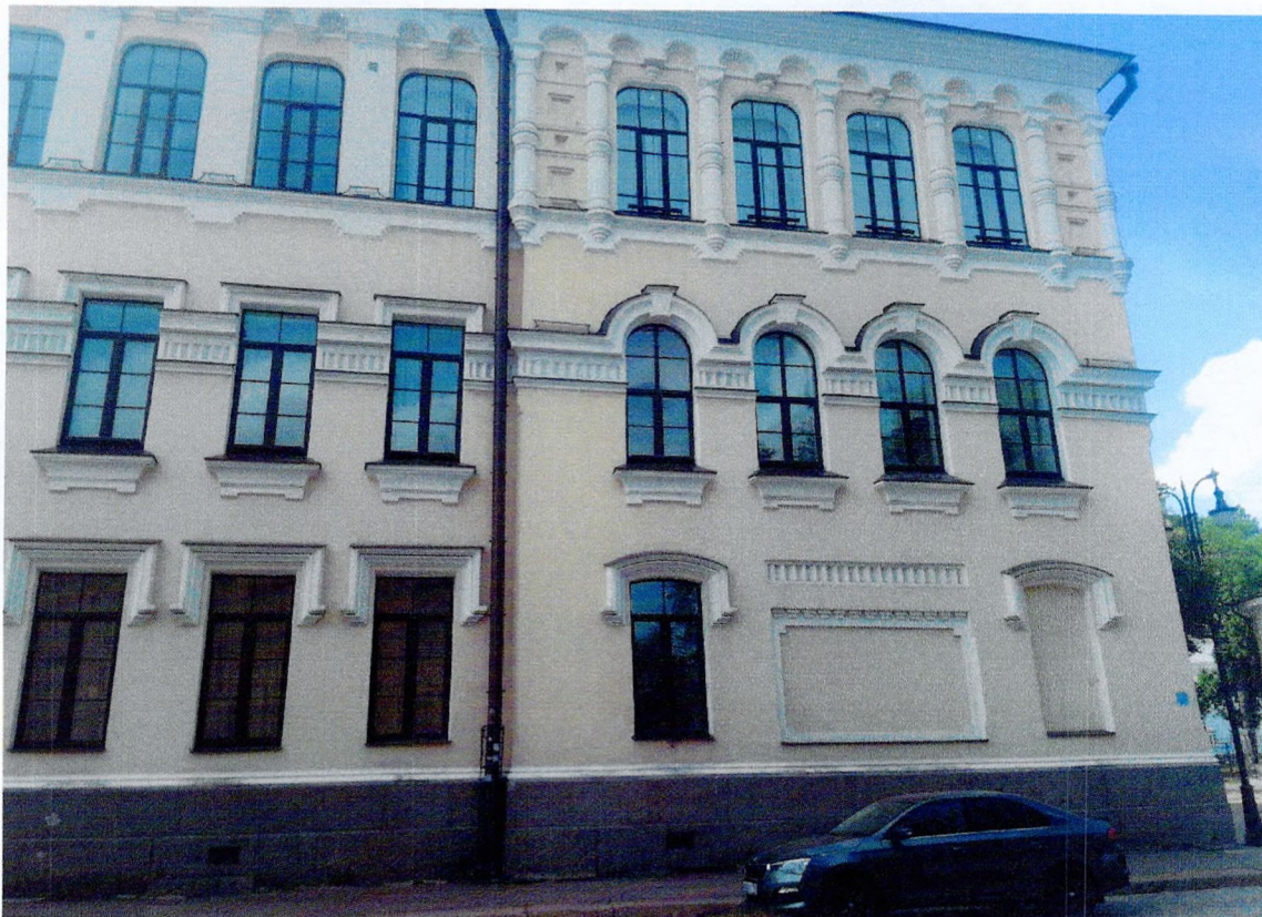
Фото 9. Фрагмент северо-восточного фасада.
