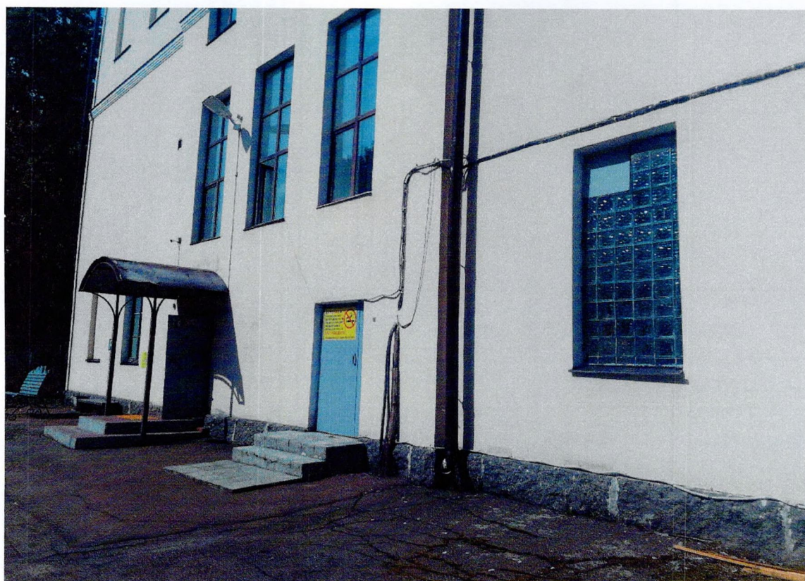
Фото 16. Фрагмент юго-восточного фасада дворового центрального ризалита.
