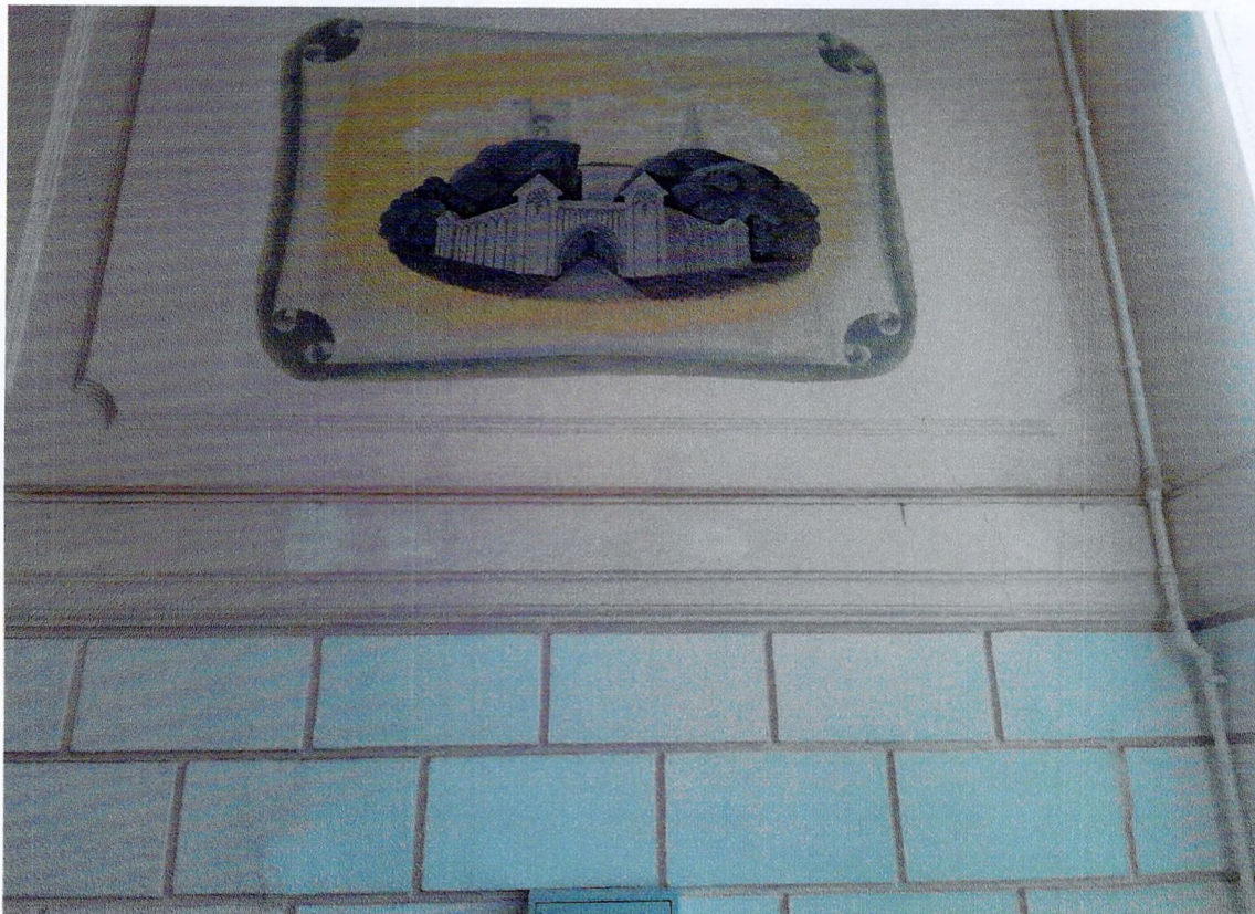
Фото 27. Внутренние помещения. Трещина на стене лестничной клетки.
