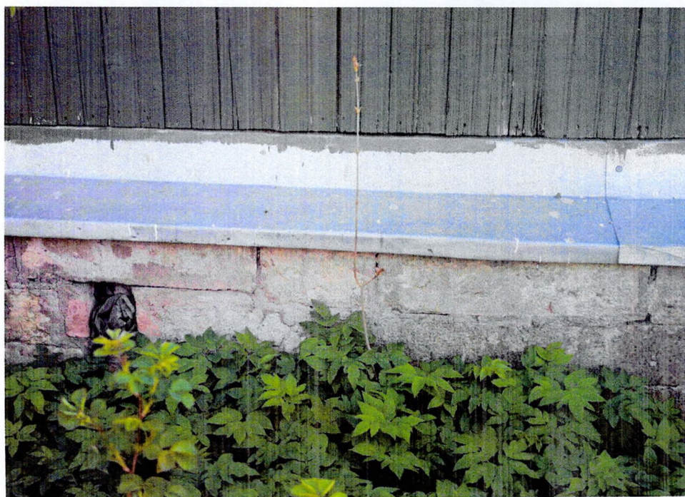
Фото 2. Фрагмент западного фасада. Каменный цоколь.
