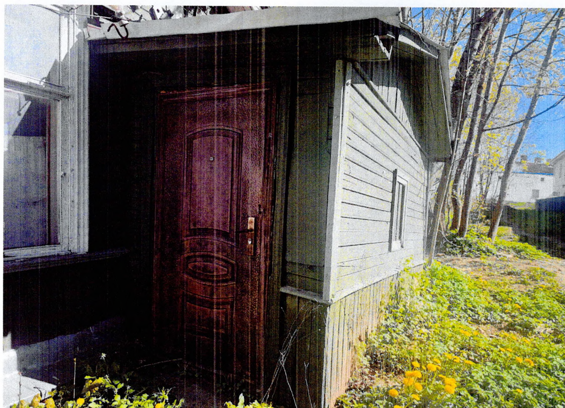
Фото 18. Фрагмент южного фасада. Позднее дверное заполнение.
