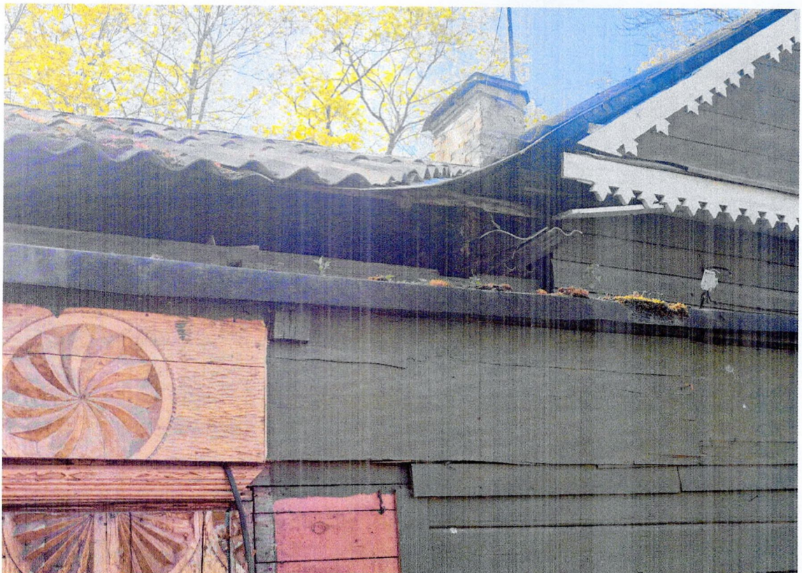
Фото 8. Фрагмент северного фасада. Резные (с орнаментом трехлистника) подзоры в обрамлении фронтона. Утрата подшива карниза кровли.
