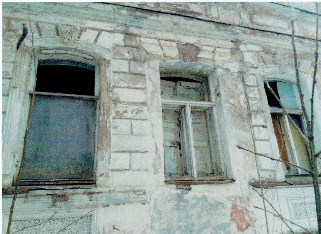
Фото 6. Фрагмент юго-западного фасада. Вид на оконные проемы 1 этажа. В уровне 1 этажа: углы здания декорированы прямоугольным рустом, плоскость фасада решена в виде кирпичной кладки с разбивкой швов «в разбежку». Оконные проемы с лучковым завершением декорированы замковым камнем и профилированным рамочным штукатурным наличником. Наблюдаются значительные участки утраты штукатурного слоя.
