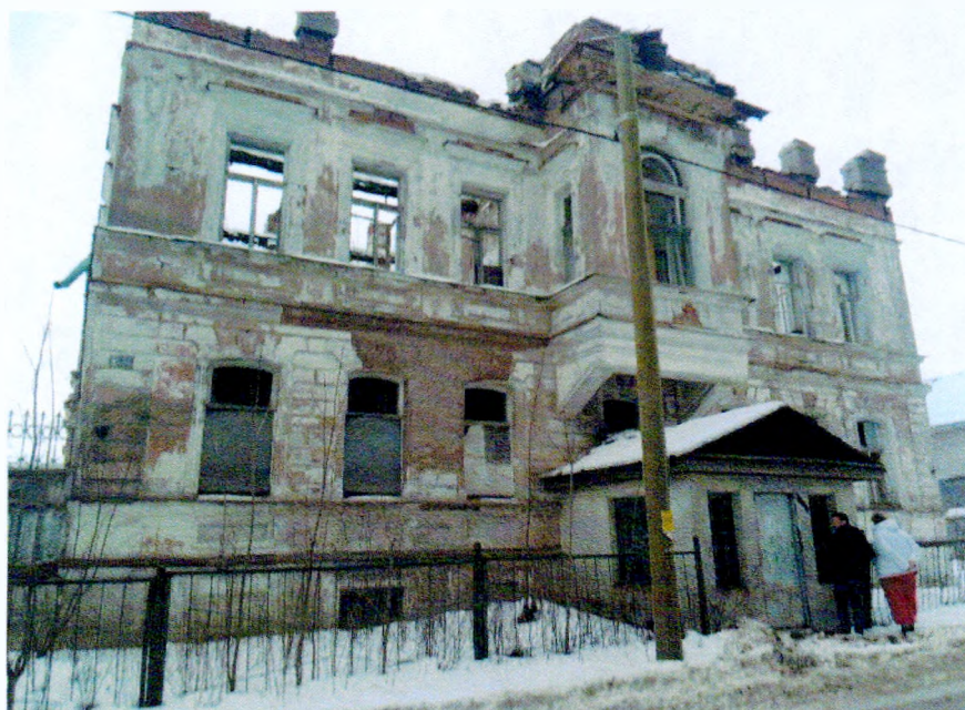
Фото 1. Вид на юго-западный (главный) фасад. Фасад в 7 световых осях. По центральной световой оси в уровне 2 этажа расположен ризалит с оконным проемом с полуциркульным завершением. Имеется пристройка более позднего периода при входе, ведущим в подвал.
