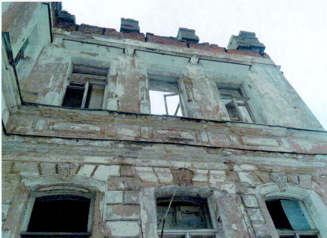
Фото 7. Фрагмент юго-западного фасада. Вид на оконные проемы 2 этажа. Прямоугольные оконные проемы имеют декор в виде штукатурных профилированных сандриков.
