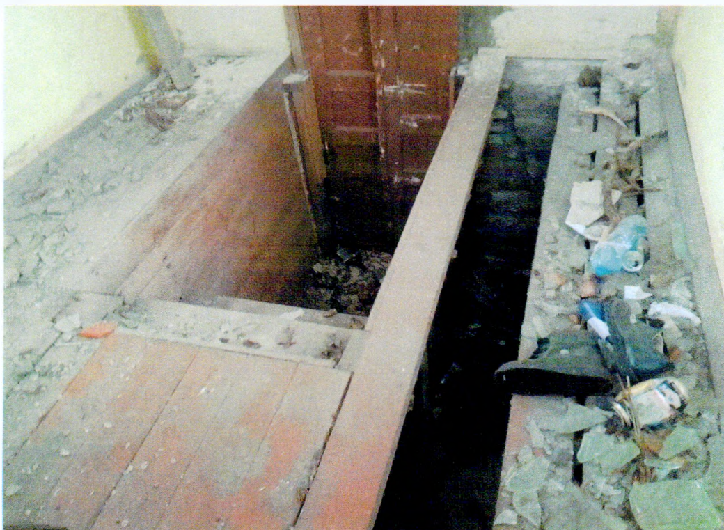
Фото 5. Фрагмент юго-западного фасада. Вход в подвал.
