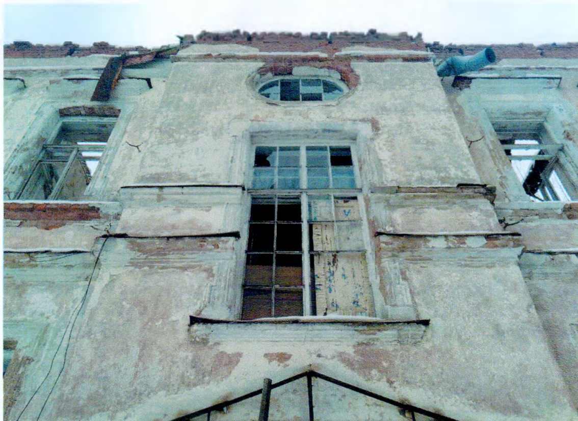
Фото 11. Фрагмент северо-западного фасада, вид на оконные проемы помещения главной лестницы. Частично сохранилась историческая многочастная расстекловка.
