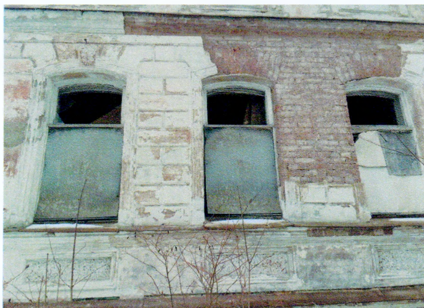
Фото 2. Фрагмент юго-западного фасада. Вид на оконные проемы 1 этажа. В уровне 1
