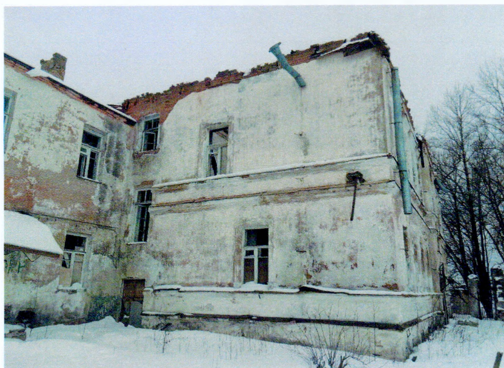
Фото 14. Вид на северо-восточный фасад. Поверхность оштукатурена, текстура – гладкая. 1 и 2 этажи разделены двумя профилированными карнизами из лекального кирпича с оштукатуриванием. Заполнение оконных проемов и кровля утрачены.
