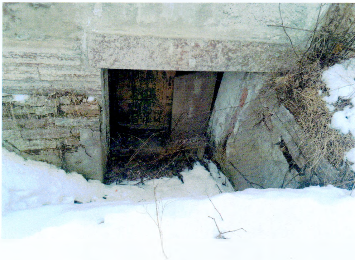
Фото 23. Фрагмент юго-восточного фасада. Прямо́к со входом в подвал.
