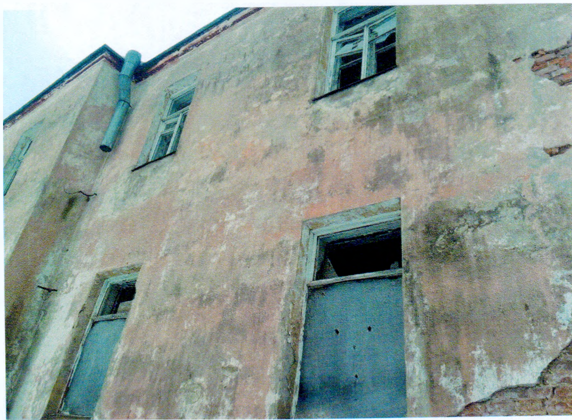
Фото 20. Фрагмент восточного фасада. Оконные проемы 1 и 2 этажа с прямоугольным завершением.
