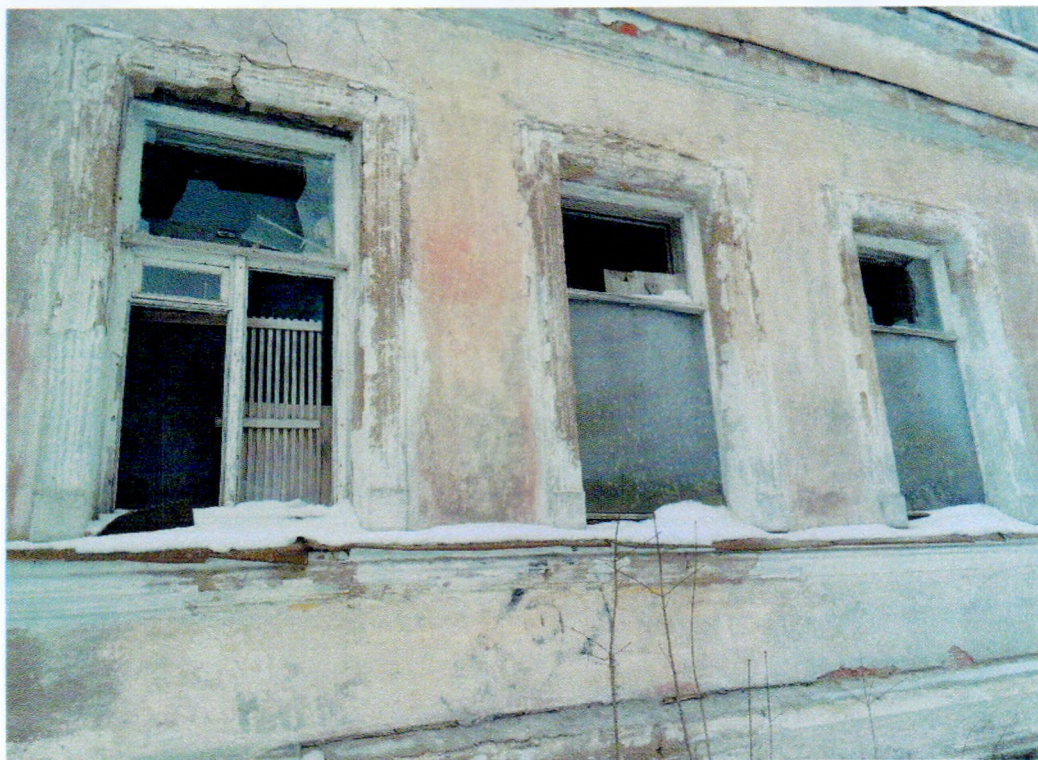
Фото 13. Фрагмент северо-западного фасада, вид на оконные проемы 1 этажа. Декор в виде профилированного штукатурного рамочного наличника.
