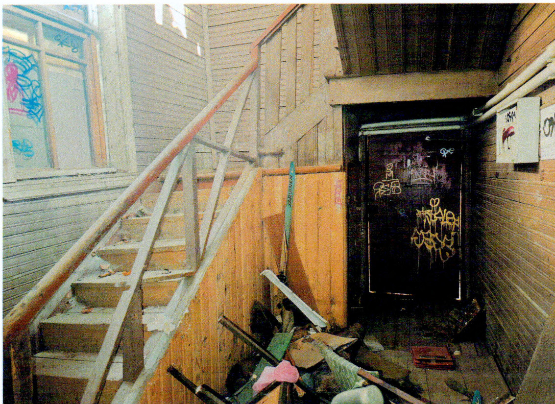
Фото 14. Помещение лестничной клетки в дворовом ризалите.
