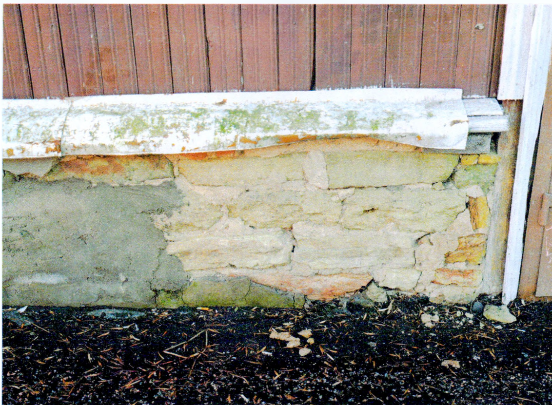
Фото 3. Фрагмент лицевого фасада. Каменный цоколь скрытый поздним штукатурным слоем.
