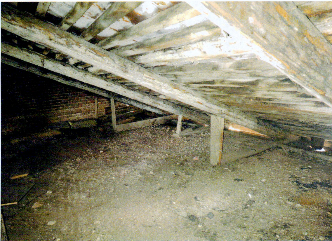
Фото 20. Фрагмент стропильной системы.
