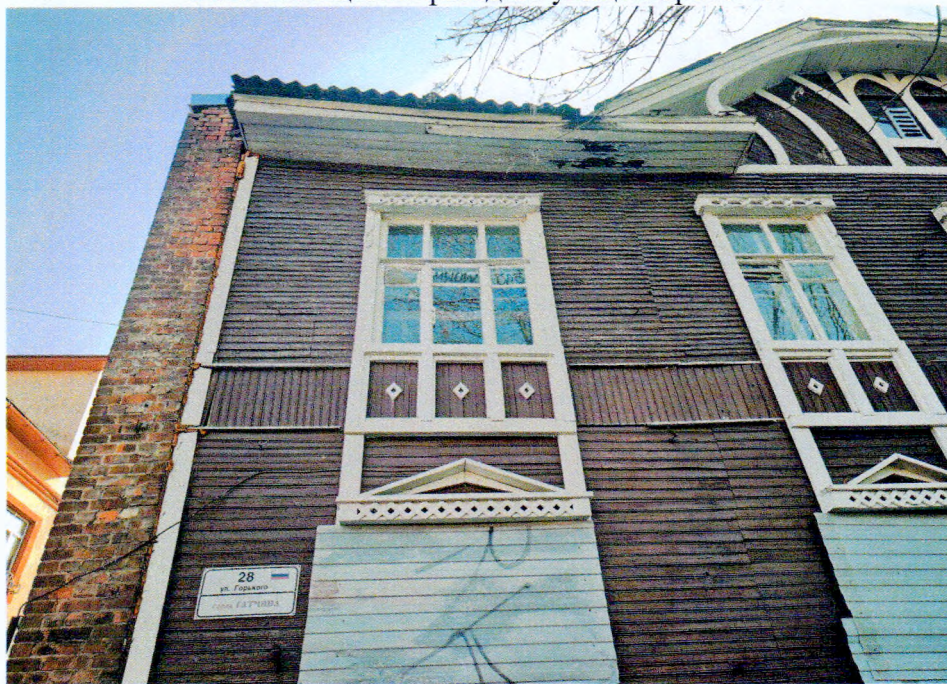
Фото 2. Фрагмент лицевого фасада. Примыкание брандмауэрной торцевой стены.
