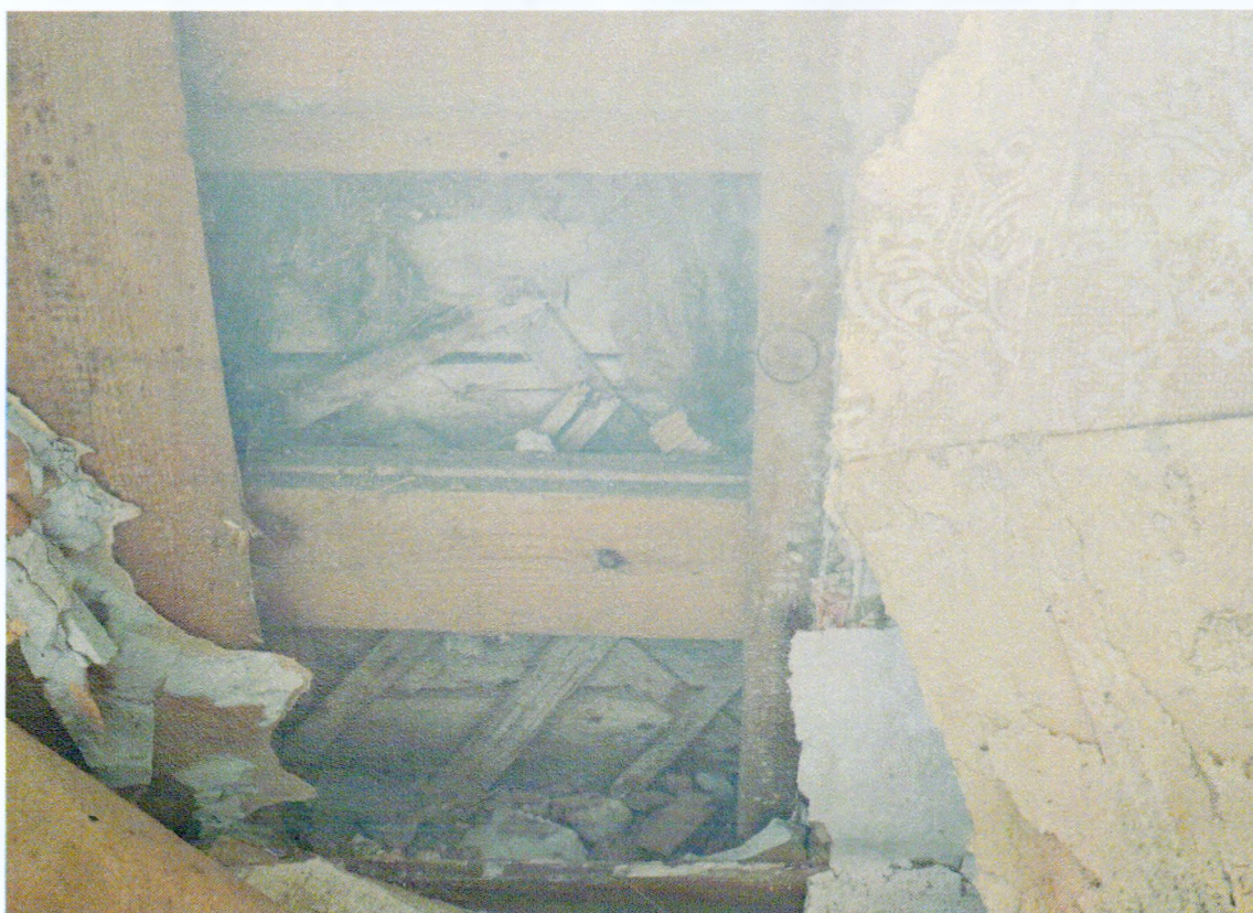
Фото 18. Фрагмент деревянной наружной стены.
