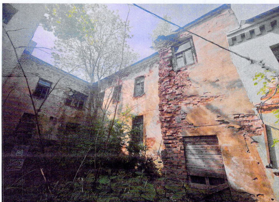
Фото 2. Дворовые фасады. Примыкание к соседнему зданию.
