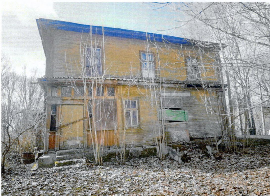
Фото 6. Восточный фасад. Одноэтажная деревянная пристройка с крыльцами.
