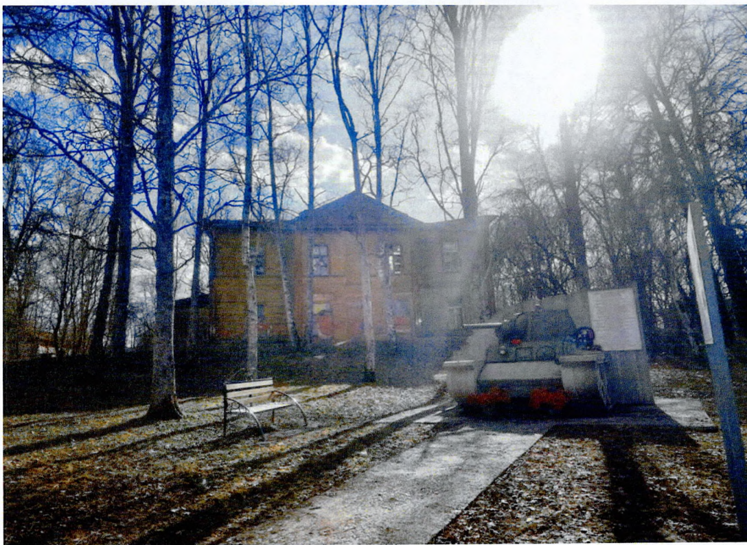
Фото 16. Вид на здание с севера.
