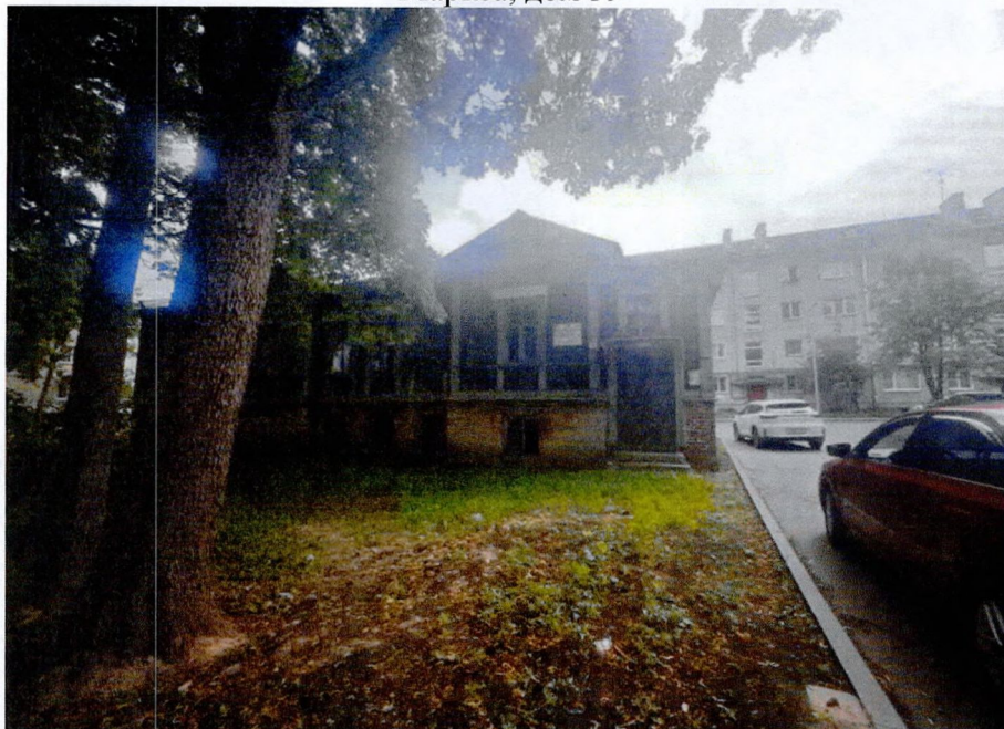
Фото 1. Территория объекта с запада.
