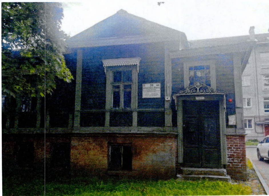
Фото 2. Фрагмент западного фасада.
