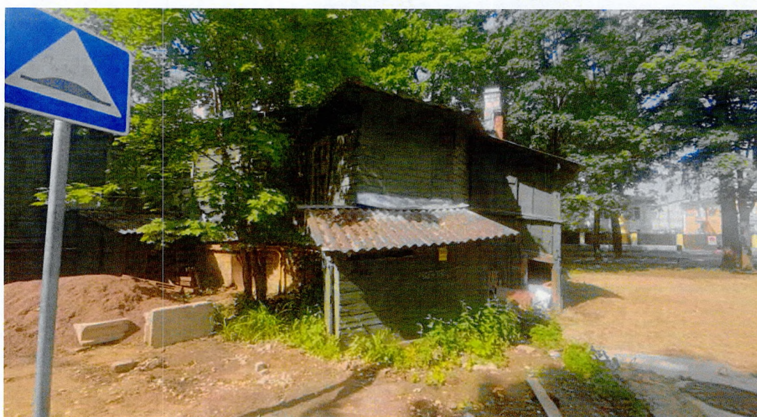
Фото 8. Северо-восточный фасад. Перекос конструкций выступающего объема.
