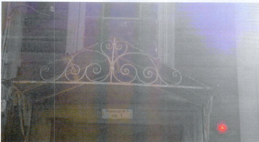
Фото 3. Фрагмент западного фасада. Металлический козырек над главным входом.
