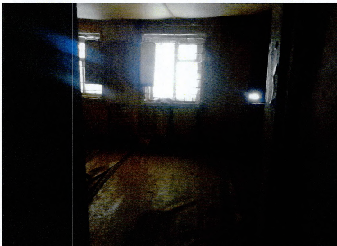
Фото 18. Помещение цокольного этажа.
