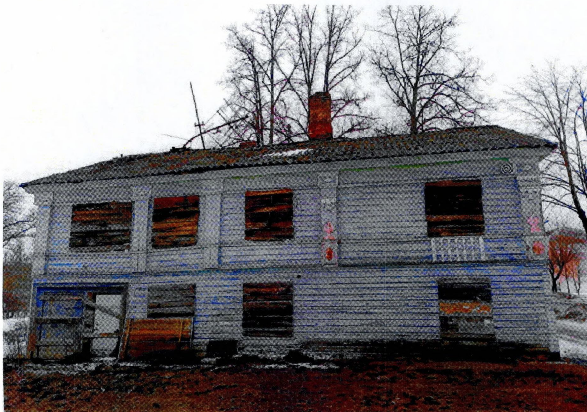
Фото 4. Дворовый фасад. Оконные и дверные заполнения утрачены. Имеются следы намокания и биопоражения деревянной обшивки. Прилегающая территория изрыта.
