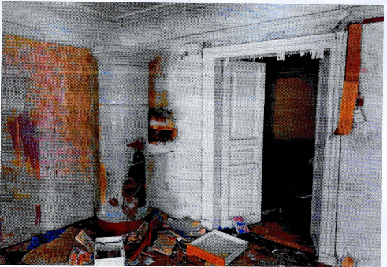
Фото 9. Интерьер помещения 2 этажа. Круглая металлическая печь, деревянные филенчатые двери, тянутый профилированный штукатурный карниз.
