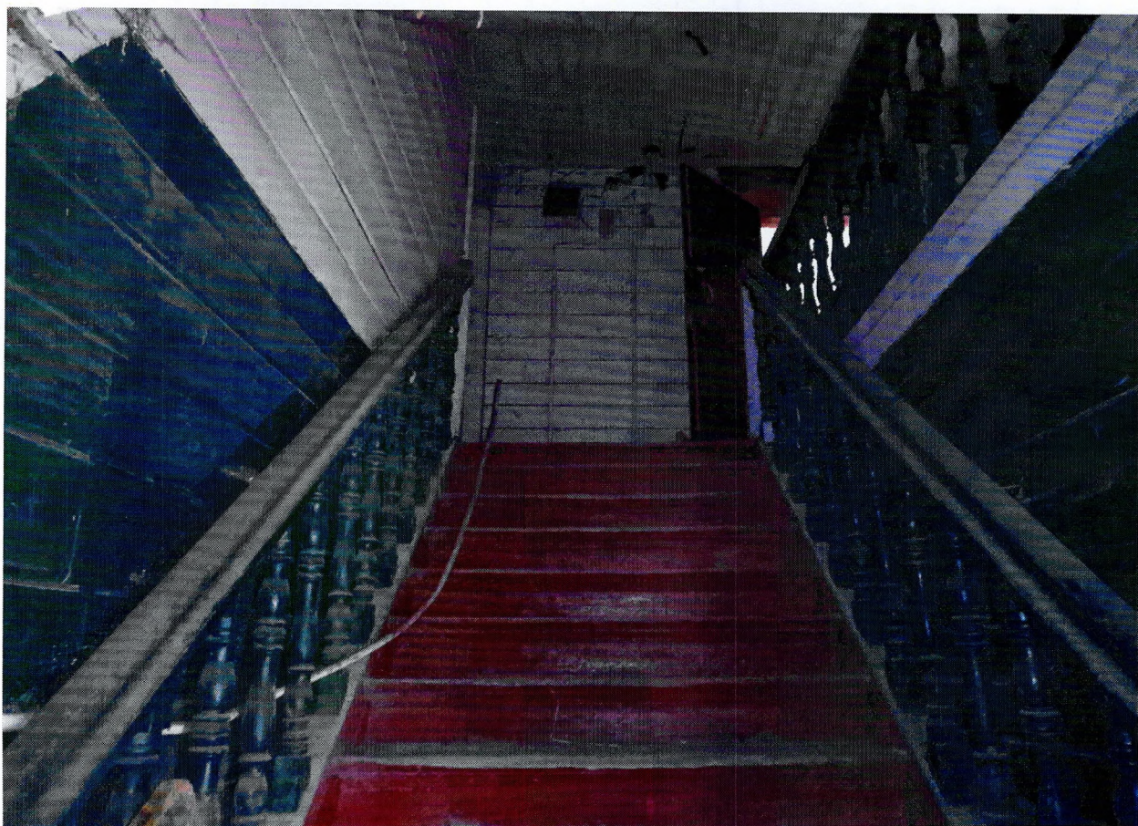
Фото 8. Вид на главную лестницу. Фигурные деревянные балясины.
