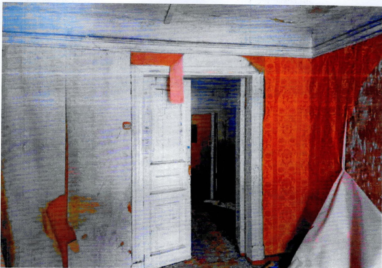
Фото 11. Интерьер помещения 2 этажа. Деревянные филенчатые двери, тянутый профилированный штукатурный карниз.
