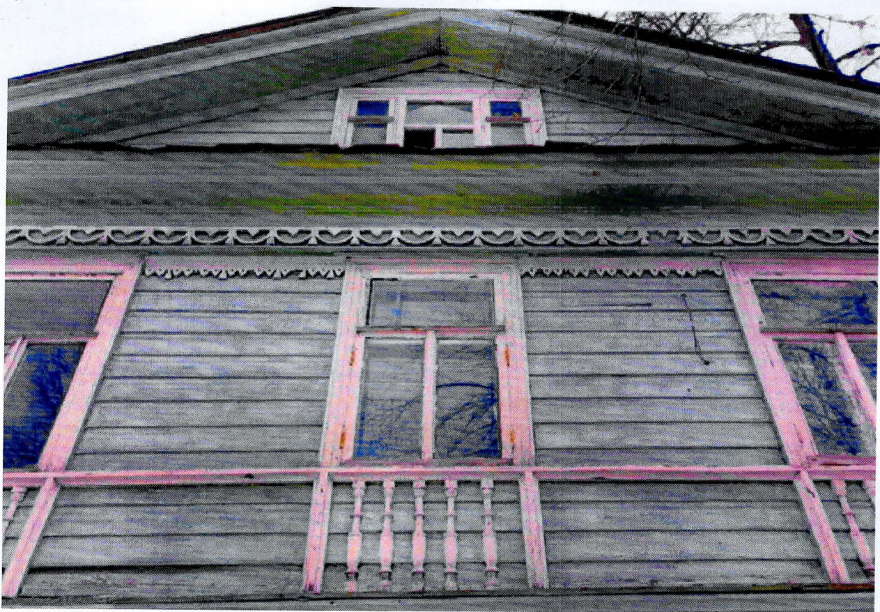
Фото 7. Фрагмент главного фасада. Элементы декора: деревянный профилированный карниз, пропильная резьба, пилястры, ряд фигурных балясин в подоконном пространстве окна 2 этажа.
