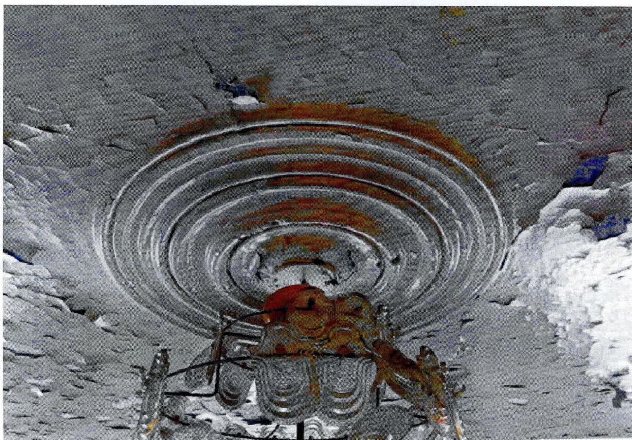
Фото 12. Элемент декора интерьера помещения 2 этажа: декоративная штукатурная розетка.
