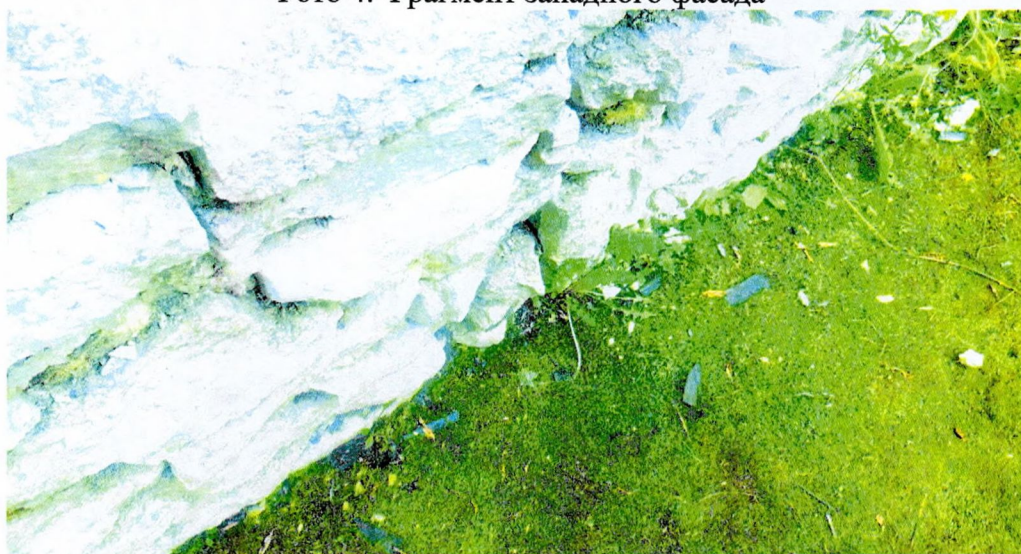
Фото 5. Фрагмент южного фасада
