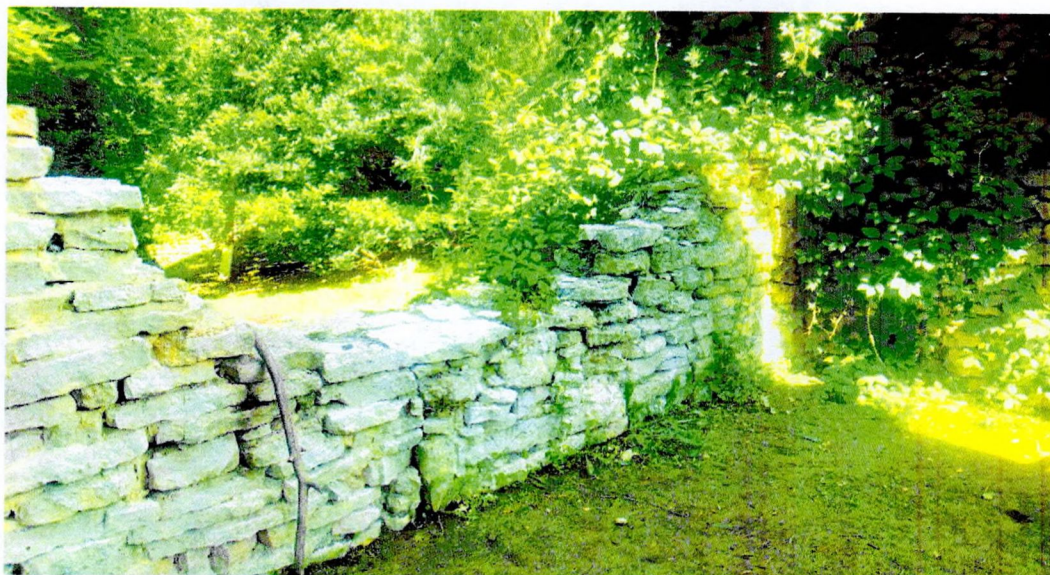
Фото 3. Фрагмент западного фасада
