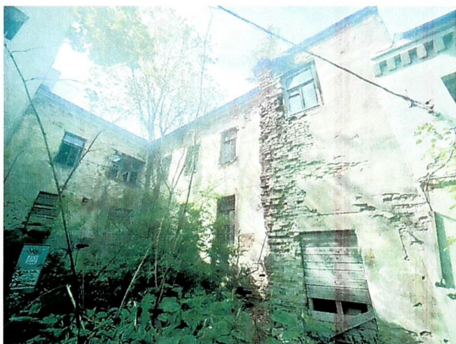
Фото 2. Дворовые фасады. Примыкание к соседнему зданию.
