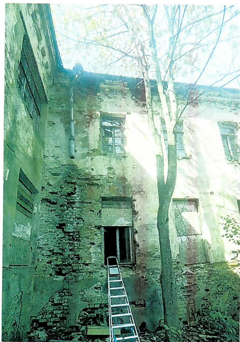
Фото 4. Западный (дворовой) фасад.
