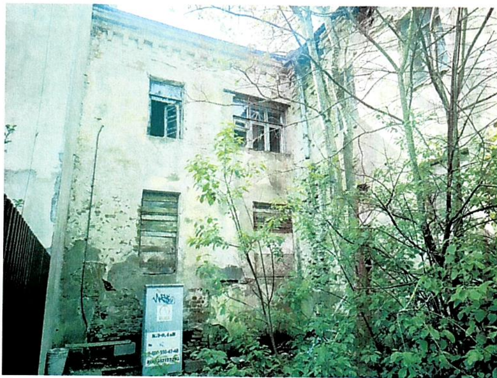
Фото 3. Северный (дворовой) фасад).
