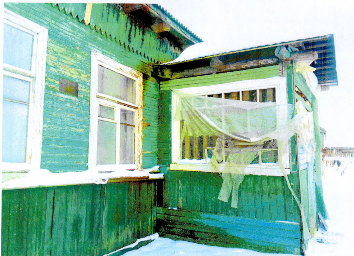
Фото 6. Фрагмент северо-западного фасада. Крыльцо главного входа.
