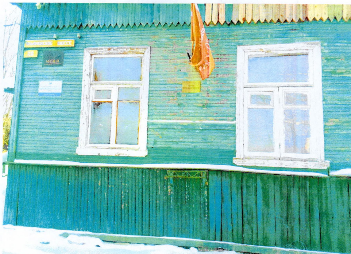
Фото 2. Фрагмент северо-западного фасада. Искривление горизонтальных линий фасада. Отслоение окрасочного слоя, увлажнение деревянных конструкций.
