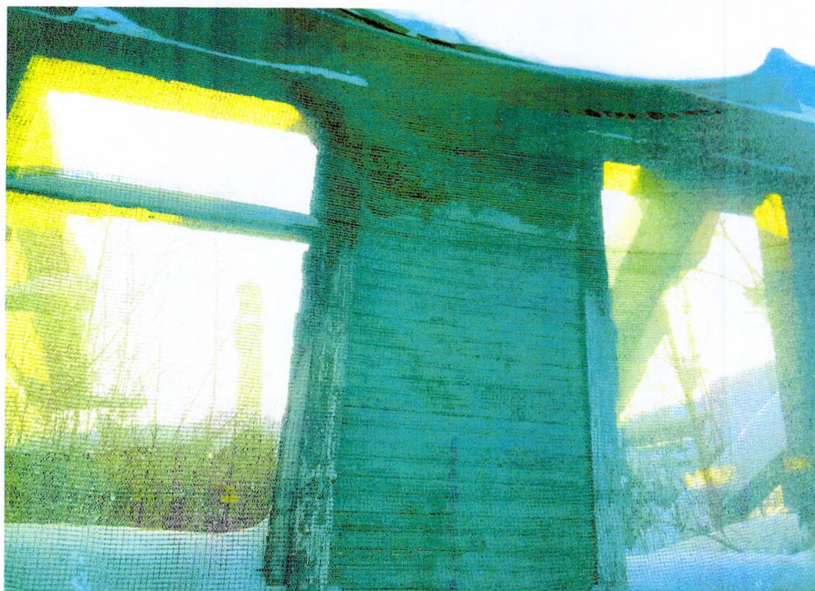
Фото 7. Фрагмент северо-западного фасада. Южная часть стены. Утрата оконных заполнений, чердачного перекрытий и крыши.
