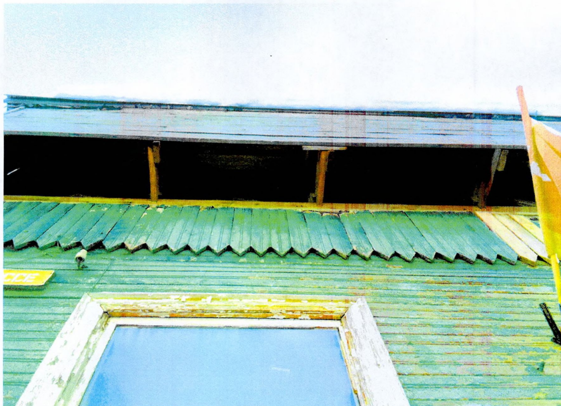
Фото 4. Фрагмент северо-западного фасада. Поздние деревянные конструкции крыши.
