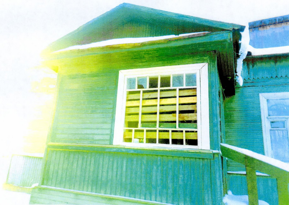
Фото 10. Фрагмент северо-восточного фасада. Утрата остекления, повреждение оконного заполнения.
