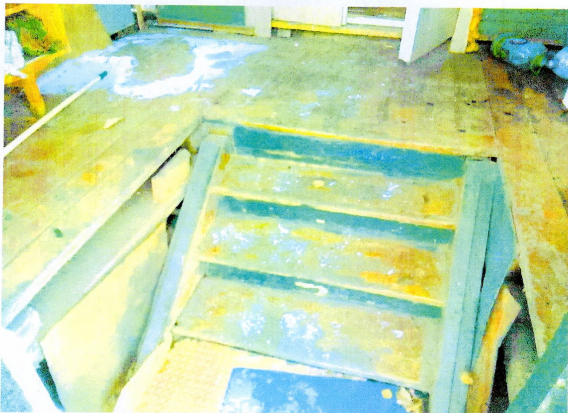
Фото 12. Внутренняя лестница крыльца главного входа.
