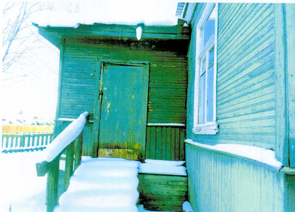
Фото 11. Фрагмент северо-восточного фасада. Вход в здание.
