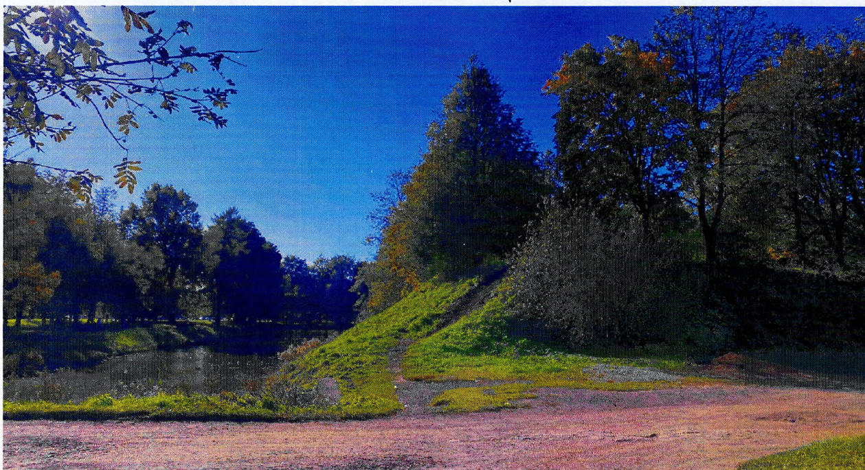
Фото 1. Земляной вал. Вид с востока
