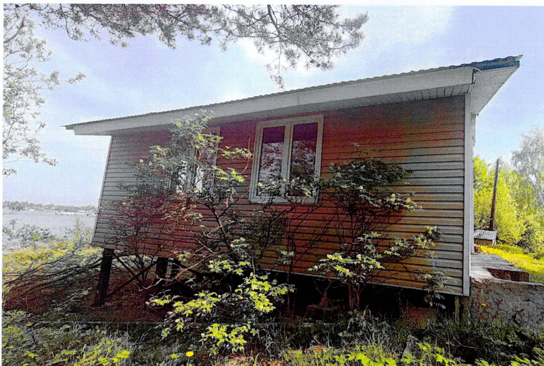
Фото 6. Поздняя пристройка, примыкающая к объекту с юго-запада
