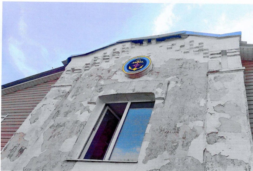
Фото 5. Фрагмент лицевого северо-западного фасада
