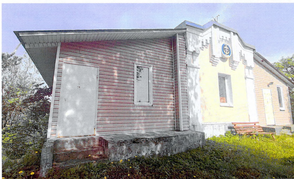
Фото 2. Общий вид лицевого юго-восточного фасада
