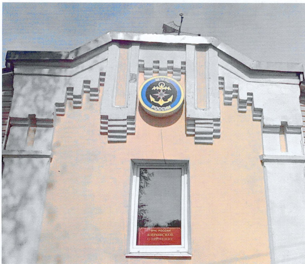
Фото 4. Фрагмент лицевого юго-восточного фасада
