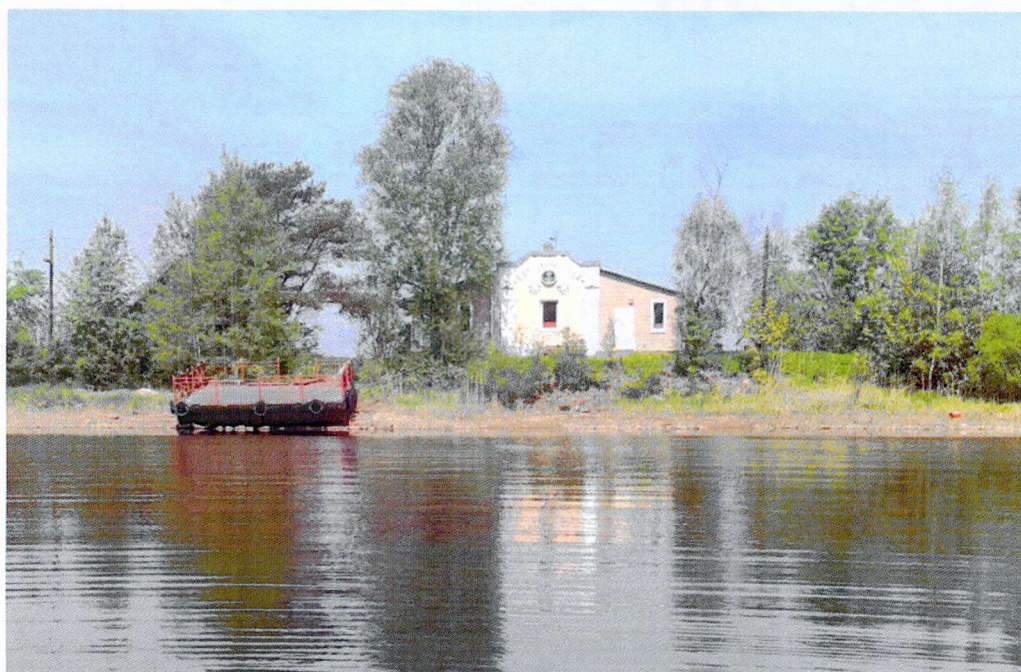
Фото 1. Общий вид здания и застройки дамбы со стороны Новоладожского канала
