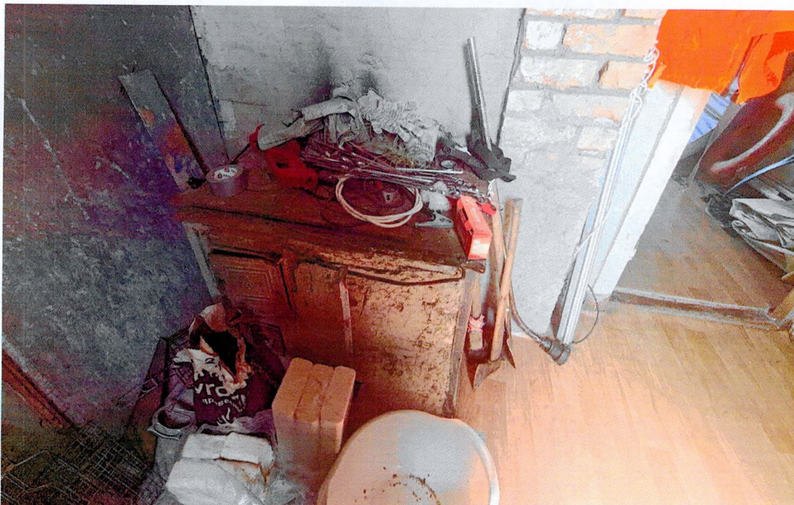
Фото 9. Кирпичная плита со щитом. Фрагмент внутренней отделки здания
