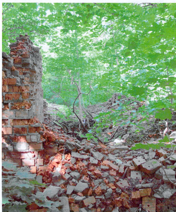
Фото 2. Утрата оконных, дверных проемов, разрушение кирпичной кладки
