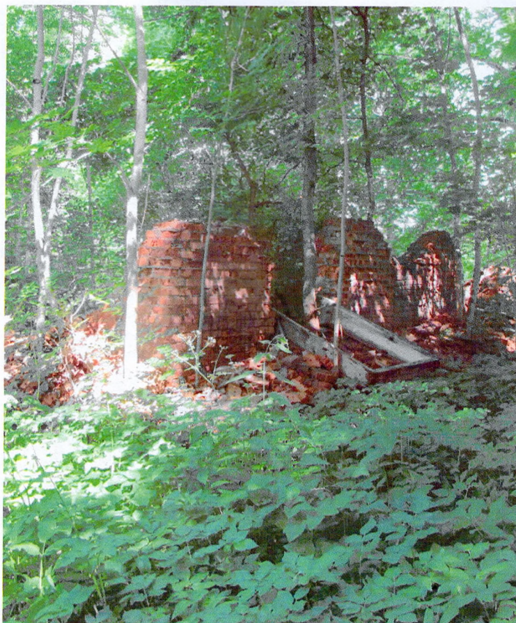
Фото 2. Утрата оконных, дверных проемов, разрушение кирпичной кладки
