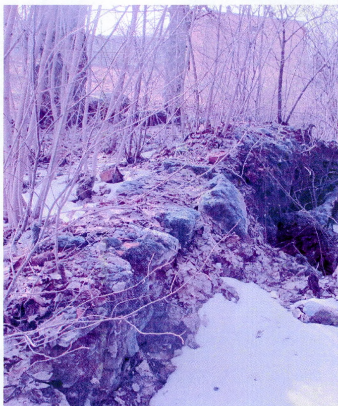
Фото 5. Фрагмент фундамента, вид в северо-западном направлении
