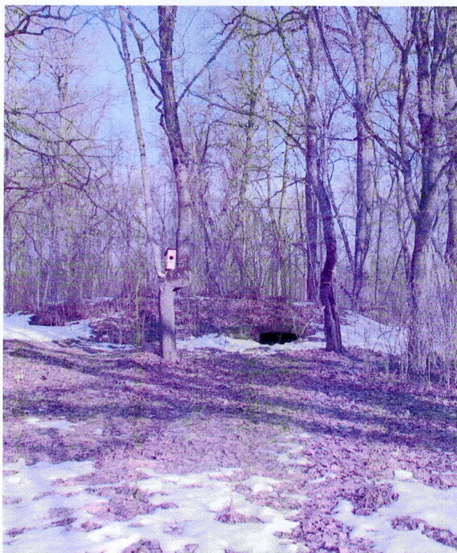
Фото 1. Общий вид на руинированную постройку с полуподвалом
